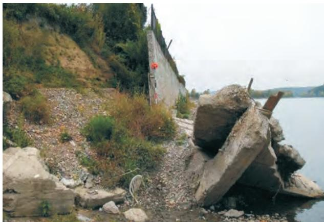
Рис. 2.30. Разрушение подпорной стенки в с.Боровково, Кемеровская область (ОАО “Томскгеомониторинг”)
