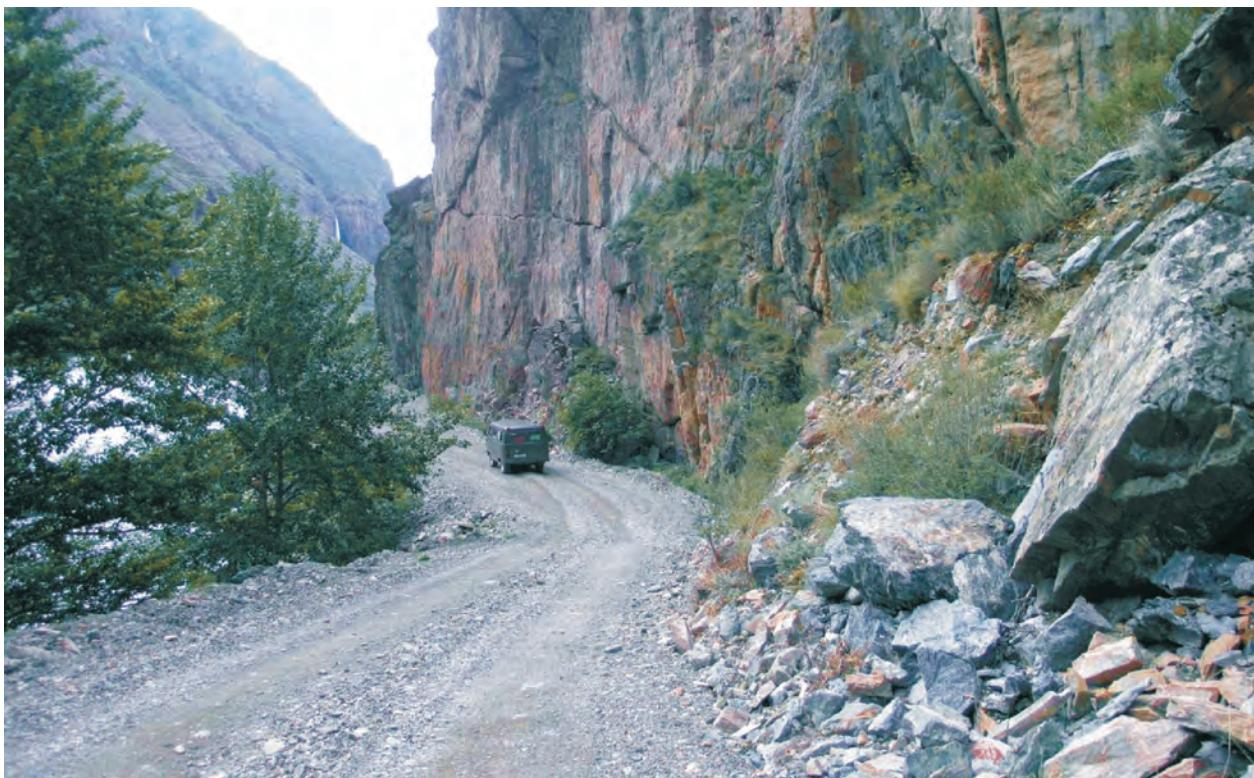
**Рис. 2.16. Обвалоопасный участок дороги Бапыктуюль–Бапыкча (47,7-48,1 км), Республика Алтай (ОАО “Томскгеомониторинг”)**
