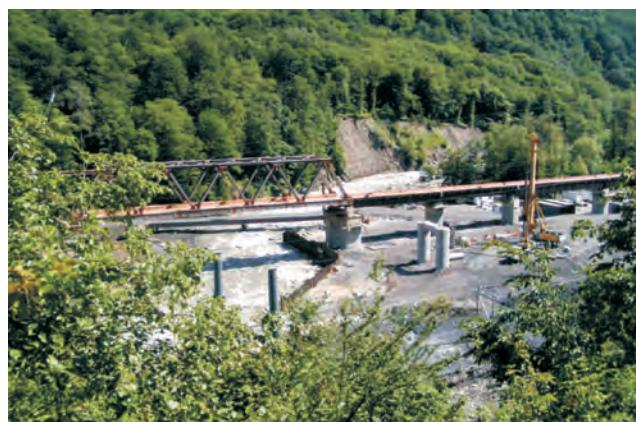
Рис. 2.14. Новый участок развития обвально-осыпных процессов на левом берегу р.Мзыма, возникший в результате техногенного изменения направления стока реки (ГУП “Кубаньгеология”)
