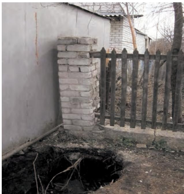
Рис. 2.22. Суффозионный провал в г.Питецке по ул.Кочеткова, 12 (ТЦ “Питецкгемониторинг”)
