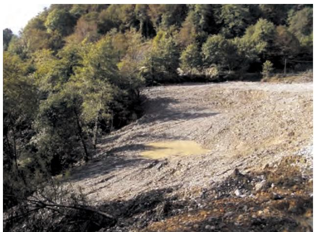
Рис. 2.4. Оползневые смещения в низовом откосе автодороги Агпер—Красная Поляна на южной окраине п.Гопицыно (ГУП “Кубаньгеология”)
