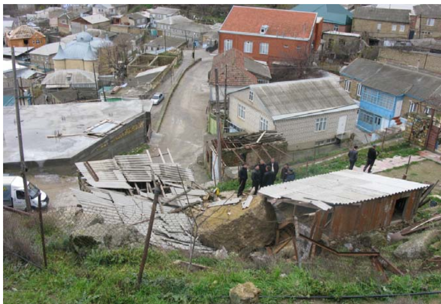
Рис. 4. Разрушенные строения в результате активизации обвального процесса в пос. Тарки; 09.12.2009 (ГУП «РЦ Дагестангеомониторинг»).
