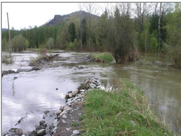
Рис.13. Размыв дороги на с. Саксобай. Прораны в полотне дороги на отрезке около 30 м (ОАО "Алтай-Гео")
