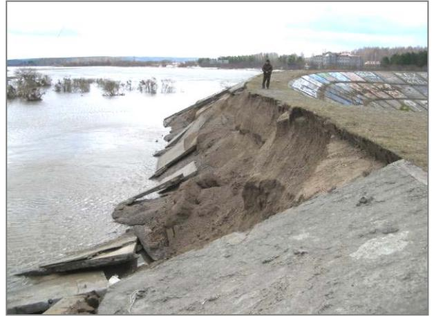
Рис.2. Размыв ледозащитных сооружений моста через р. Томь, г. Томск (ООО «Сибгеомониторинг»)
