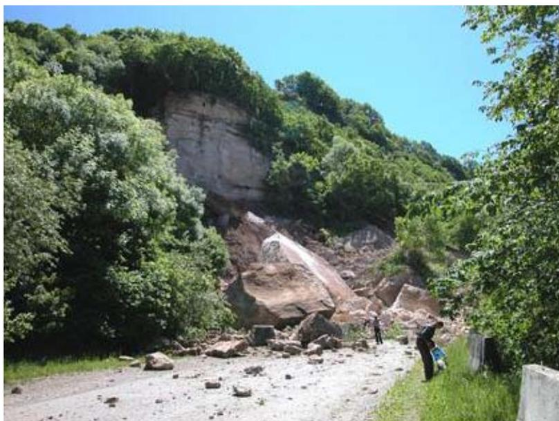
Рис.9. Активизация обвально-осыпных процессов на участке автодороги ст.Исправная – ст.Сторожевая в Зеленчукском районе; 27.05.2010 (ОАО «ГИДРОГЕОЭКОЛОГИЯ»)
