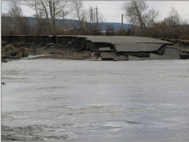
Рис.1. Размыв автодороги в районе моста, г. Томск (ООО «Сибгеомониторинг»)
