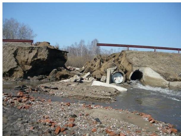
Рис.16. Разрушение а/дороги с. Сухобузимское-с. Павловщина в результате активизации процесса боковой эрозии на руч. Алырчикова (МУП ЭМР «ТЦ «Эвенкиягеомониторинг»)
