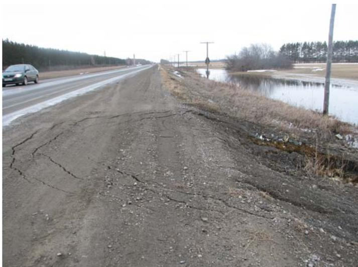
Рис.12. Трещины на автодороге Богданович-Сухой Лог, образовавшиеся после повторной активизации карстово-суффозионных процессов на 12 км автодороги Богданович-Сухой Лог; 22.04.2010 (ОАО «Уральская гидрогеологическая экспедиция»)
