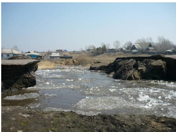
Рис.15. Разрушение а/дороги в результате активизации процесса боковой эрозии на р. Сухой в с. Сухобузимское (МУП ЭМР «ТЦ «Эвенкиягеомониторинг»)
