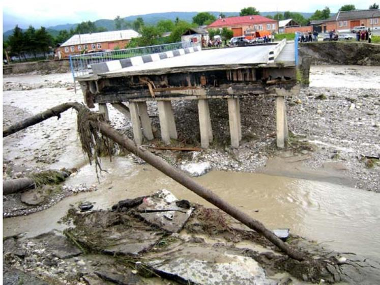
Рис.11. Разрушенный мост через р. Цраудонв в результате активизации процесса боковой эрозии; 06.06.2010 (ГУП РСО-А «СЕВОСЕТИНГЕОЭКОМОНИТОРИНГ»)
