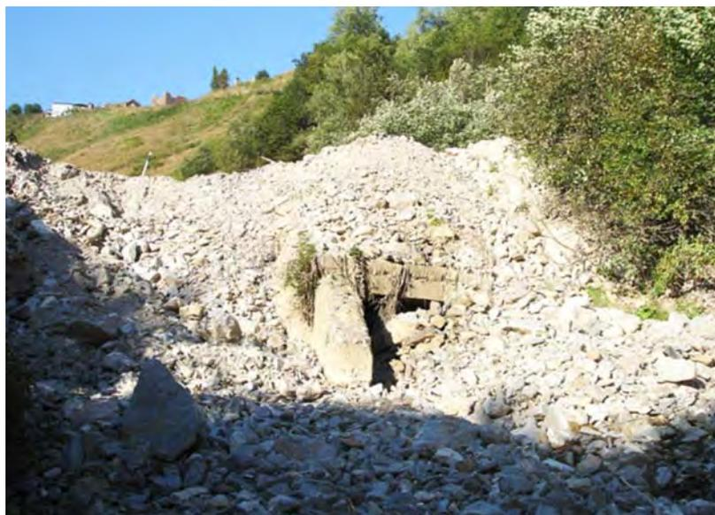
Рис.12. Селепропуск, забитый и деформированный селевым выбросом по р. Кубальчиком.
