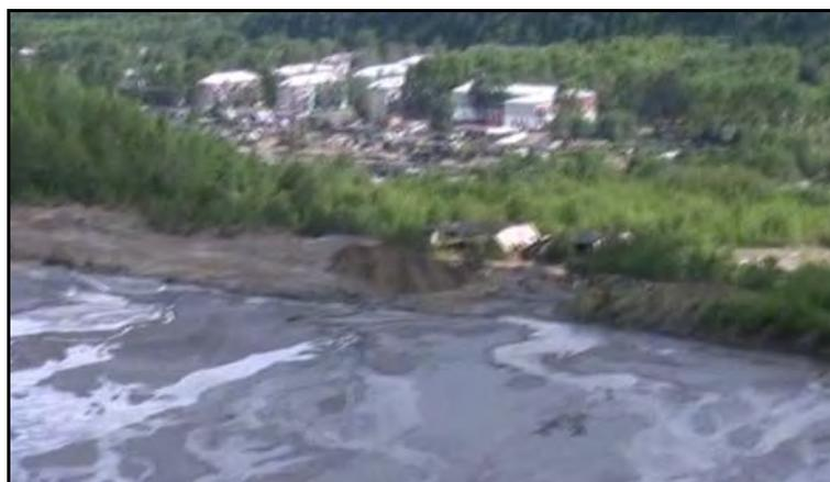
Рис. 17. Вид сверху на размываемую дамбу хвостохранилища, на заднем плане жилые дома пос. Горный
