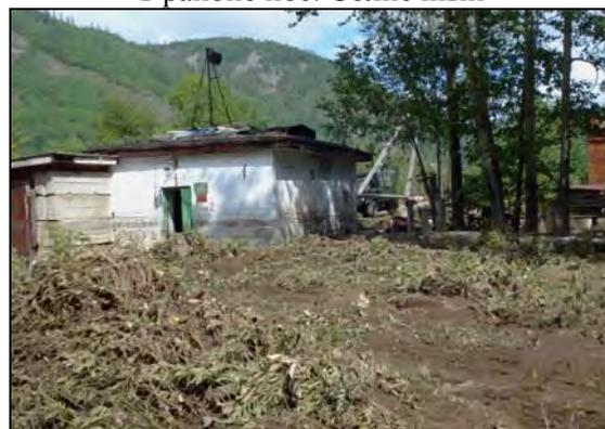
Рис.16. Водозабор пос. Горный после паводка (темная полоса на стене павильона указывает максимальный уровень воды на пике паводка)
