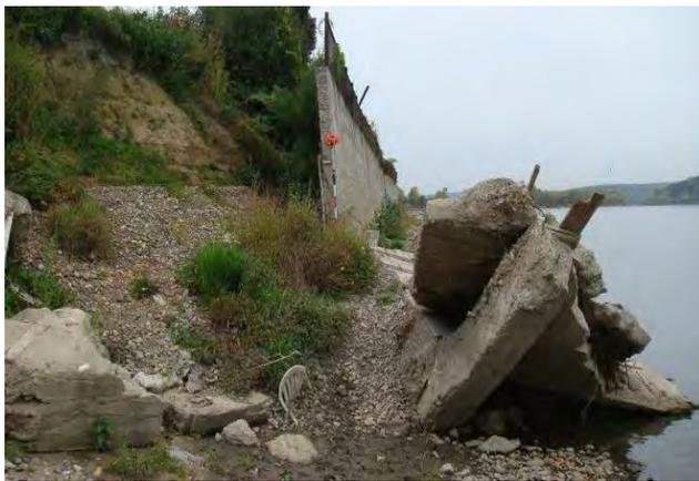
Рис.9. Разрушение подпорной стенки в с. Боровково на р. Томь, Кемеровская область (ТЦ ГМСН по Кемеровской области)
