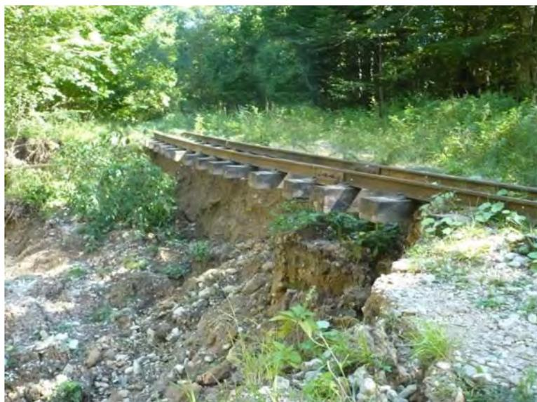
Рис.11. Активный оползневой блок в низовом откосе узкоколейной железной дороги.
