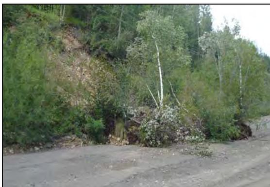
Рис. 13. Оплывины дерна с древостоем на участке дороги пос. Горный – турбаза «Амут»
