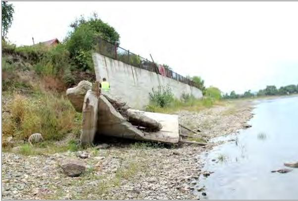
Рис.4. Обрушение подпорной стенки в с. Боровково (Кузбасский ТЦ ГМСН)
