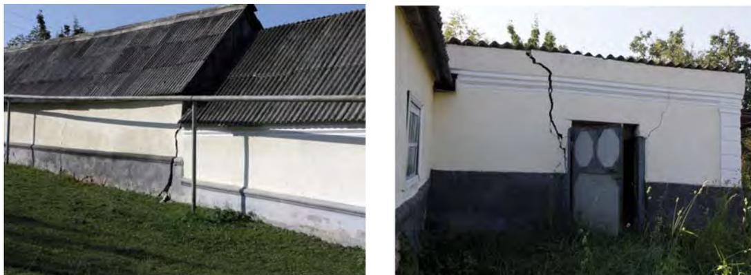
Рис.9. Деформации хозяйственной постройки на ул. Бабгоева, 15 в с. В. Куркужин (ООО «Каббалкгеомониторинг»)
