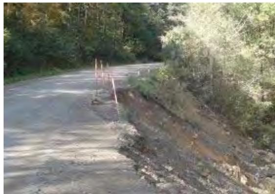
Рис.19. Подмыв дорожной выемки на 108,8 км автодороги Находка – Кавалерово. по правому борту долины р. Лазовка (Приморский ТЦ ГМСН)
