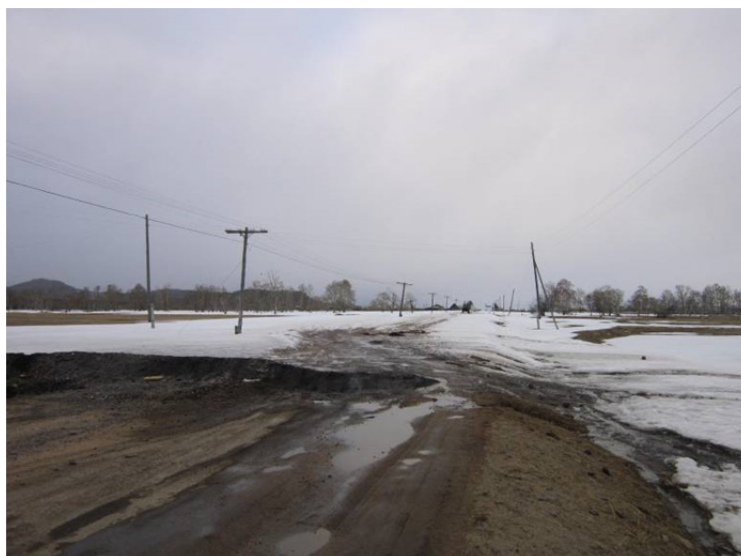
Рис.16. Наледь на автомобильной дороге в с. Улюкчикан, Республика Бурятия (ТЦ ГМСН по Республике Бурятия)
