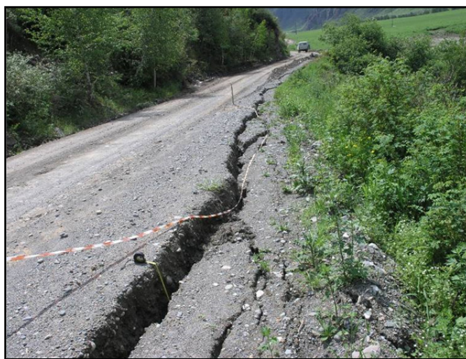
Рис.5. Участок автодороги Чемал – Куюс (78,6 км). Фронтальный оползень по бровке дорожного полотна, Республика Алтай (Алтайский ТЦ ГМСН)
