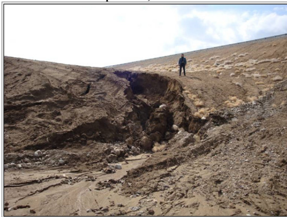
Рис.17. Процессы овражной эрозии в искусственной насыпи у автодороги М-54 «Енисей», Республика Тыва (Тувинский ТЦ ГМСН)
