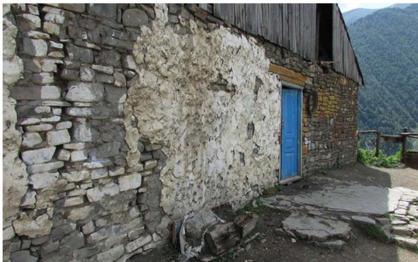
Рис.35. Трещины в стене здания школы в результате развития оползневой процесса в с. Хутрах (ГУП РЦ «Дагестангеомониторинг»)
