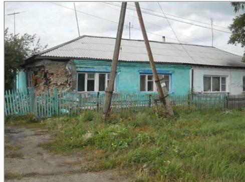
Рис.29. Разрушение жилого здания по ул. Фабричная, 2, пгт. Коченево, Новосибирская область (Новосибирский ТЦ ГМСН)
