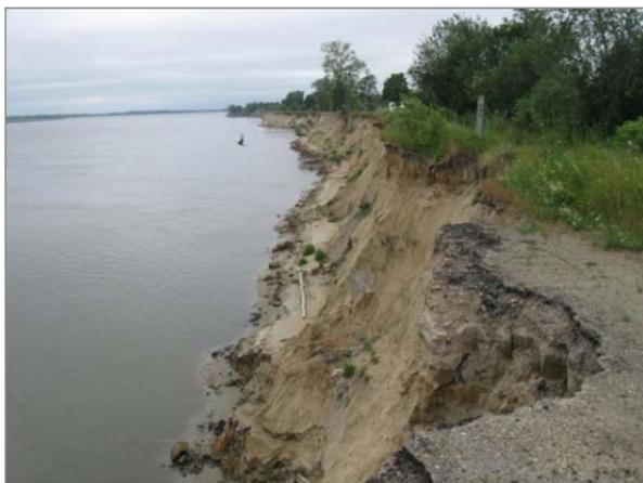
Рис.11. Разрушение дорожного полотна в результате развития гравитационно-эрозионных процессов по ул. Дзержинского, г. Колпашево, Томская область (ОАО «Томскгеомониторинг»)
