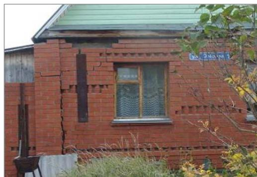
Рис.23. Разрушение жилого дома в результате подтопления подземными водами, с. Ягуновское, Кемеровская область (ТЦ по Кемеровской области)
