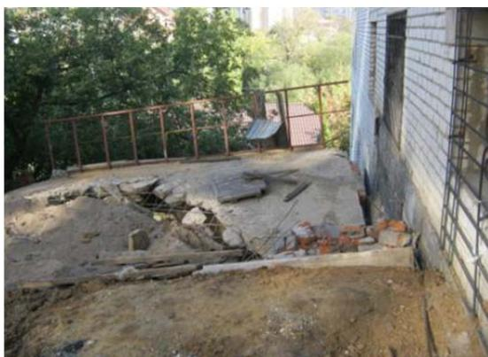
Рис.1. Разрушенная в результате активизации эрозионных процессов бетонная плита, г. Липецк, ул. Льва Толстого, д.28 (ОАО «Геоцентр-Москва»)
