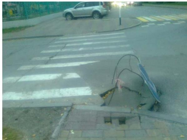
Рис.8. Суффозионный провал (перекресток ул.Пушкина – Коминтерна, г.Ханты-Мансийск, сентябрь 2014 г.) (ТЦ ГМСН по Ханты-Мансийскому автономному округу)
