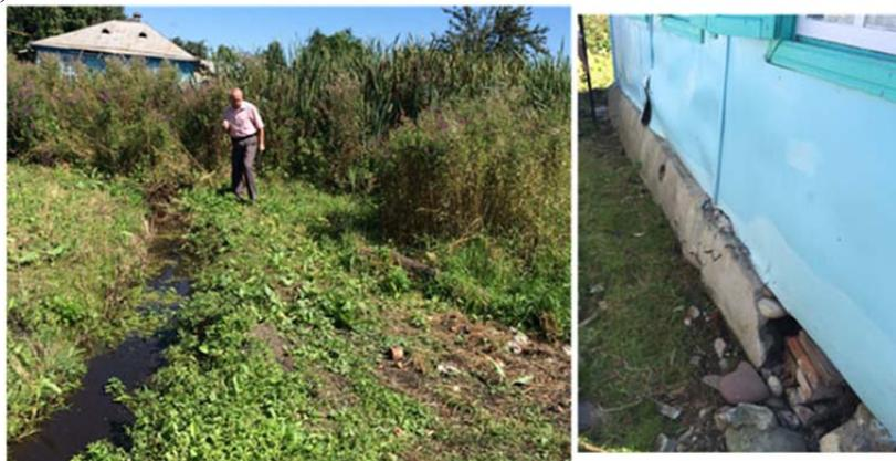
Рис.5. Участок подтопления в северо-западной части ст. Кардоникской, деформация фундамента жилого дома в результате воздействия процессов подтопления (ТЦ ГМСН по Карачаево-Черкесской Республике)
