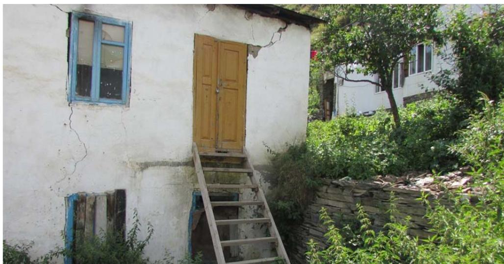
Рис.31. Трещины в стенах домостроений в селении Ретлоб (ГУП РЦ «Дагестангеомониторинг»)
