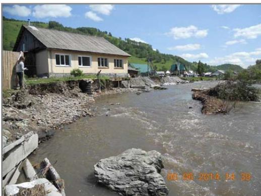
Рис.16. Разрушение фундамента дома, смыв огорода, хозпостроек в г. Горно-Алтайск, Республика Алтай (ТЦ «Алтайгеомониторинг»)
