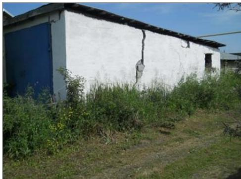
Рис.29. Образование трещин в стенах строения по ул. Мира, 45/1, с. Лебедевка, Новосибирская область (Новосибирский ТЦ ГМСН)
