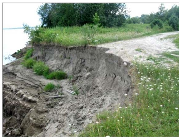
Рис.12. Разрушение автодороги в результате развития гравитационно-эрозионных процессов в д. Тискино, Томская область (ОАО «Томскгеомониторинг»)
