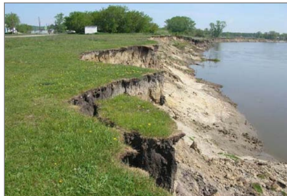
Рис.20. Оползневые блоки в с. Новотроицкое, Алтайский край (Алтайский ТЦ ГМСН)
