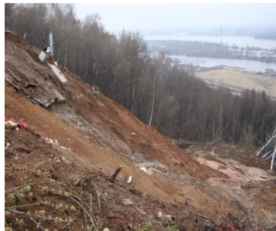
Рис.3. Участок активизации оползня, ул. Новая деревня, Нижний Новгород, апрель 2016 г. (ТЦ ГМСН по Нижегородской области)
