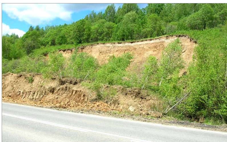
Рис.21. Участок развития оползневых процессов на уч. Залесовский, Алтайский край (Алтайский ТЦ ГМСН)
