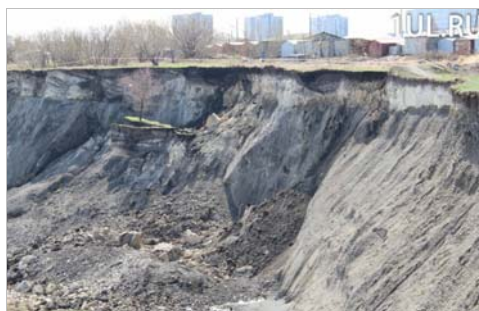
Рис.42. Оползень на обрыве Милановского вблизи ул. Любви Шевцовой, г. Ульяновск (ТЦ ГМСН по Ульяновской области)
