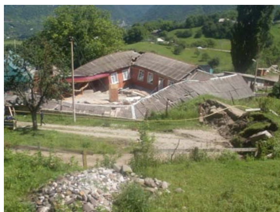
Рис.37. Разрушенный дом в н.п. Гуш-Керт, справа перед домом – вал выпирания оползня (ООО «Центр ГИДИС»)
