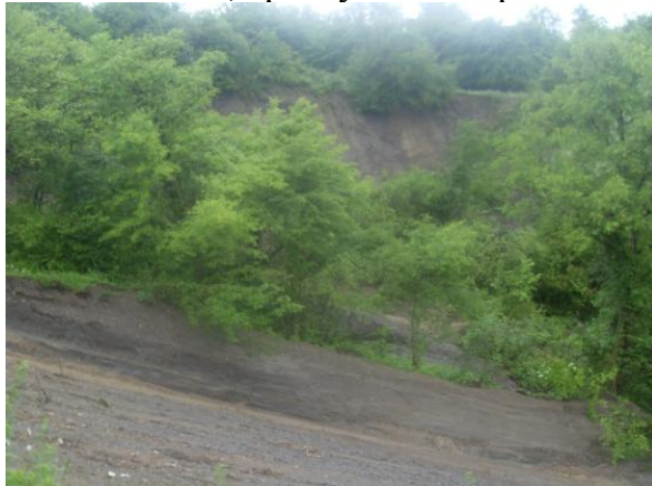
Рис.34. Плоскость отрыва в головной части оползня н.п. Ца-Ведено (ООО «Центр ГИДИС»)
