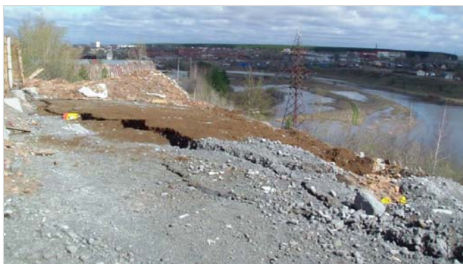
Рис.8. Участок развития оползня г. Арамиле, ул. Октябрьская, 171/1, Свердловская область, апрель 2016 г. (РЦ ГМСН по Уральскому федеральному округу)
