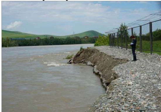
Рис.12. Катунский водозабор. Участок разрушения дамбы обвалования, Республика Алтай (ТЦ ГМСН по Республике Алтай)
