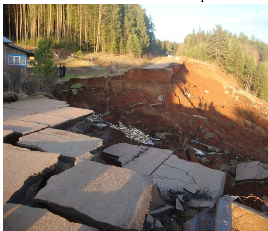
Рис.1. Участок развития оползневого процесса на склоне Обвинского залива Камского водохранилища, д. Подборная, Ильинский район, Пермский край (ТЦ ГМСН по Пермскому краю)
