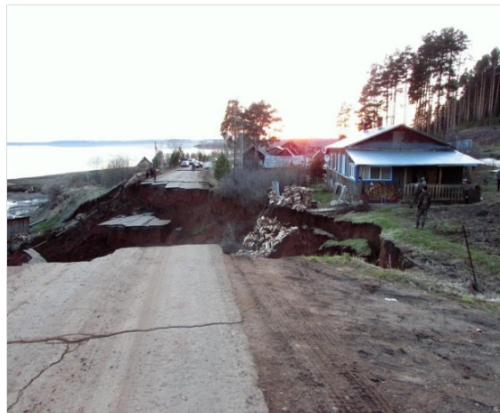
Рис.1. Участок развития оползневого процесса на склоне Обвинского залива Камского водохранилища, д. Подборная, Ильинский район, Пермский край (ТЦ ГМСН по Пермскому краю)
