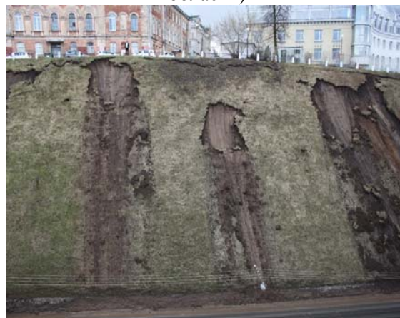
Рис.5. Участок активизации оползней на Зеленском съезде, г. Нижний Новгород, апрель 2016 г. (ТЦ ГМСН по Нижегородской области)
