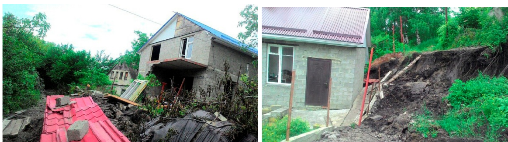
Рис. 70. Деформированные дома в результате активизации оползневой оползневой процесса на территории садового некоммерческого товарищества «Ягодка», г. Ставрополь (ТЦ ГМСН по Ставропольскому краю)
