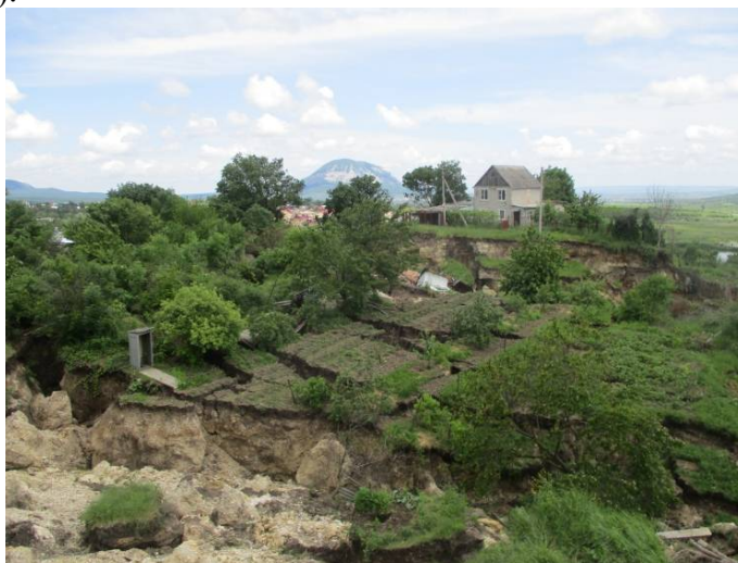
Рис. 66. Оползневой массив разбитый многочисленными трещинами на блоки (ТЦ ГМСН по Ставропольскому краю)
