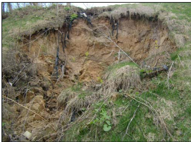
Рис. 27. Участок активизации оползневого процесса в г. Воронеж (ТЦ ГМСН по Воронежской области)
