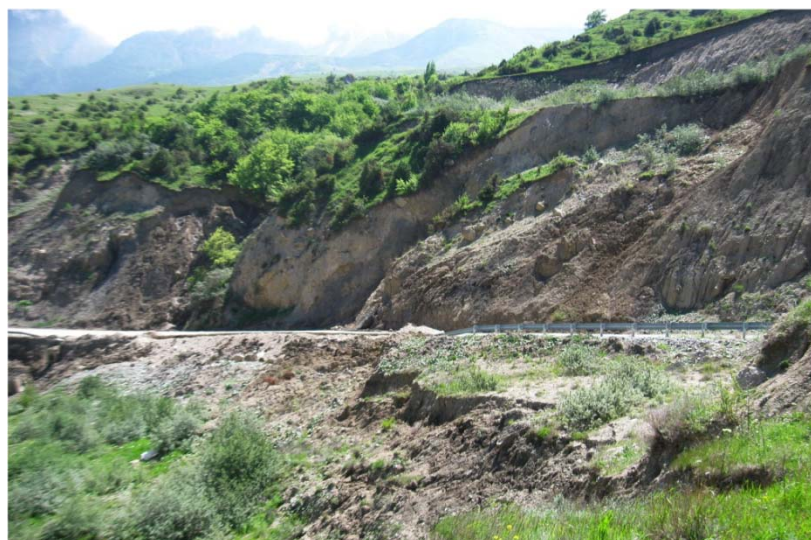
Рис. 61. Смещенные блоки в головной и центральной частях оползня Низовой, Задалесский участок (ТЦ ГМСН по Республике Северная Осетия – Алания)
