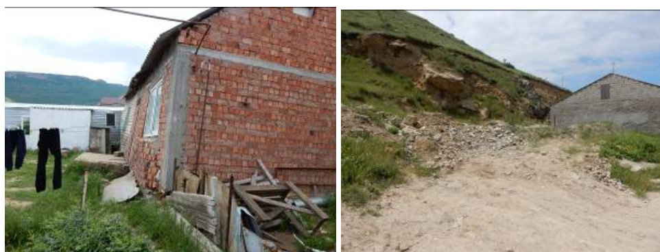
Рис. 52. Деформированные в результате активизации оползневого процесса домостроения на Махачкалинской площади (ТЦ ГМСН по Республике Дагестан)
