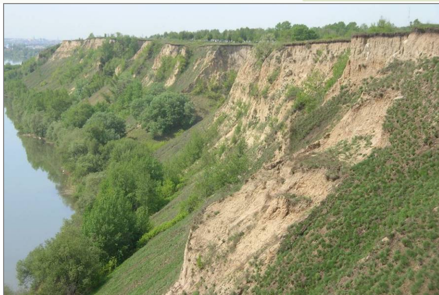
Рис. 94. Активный оползень на склоне в г. Бийск, Алтайский край (ТЦ ГМСН по Алтайскому краю)
