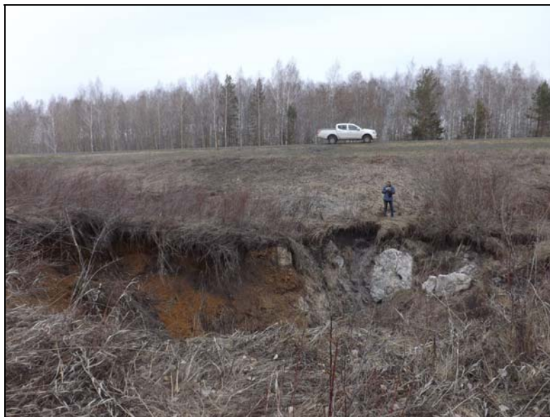
Рис. 9. Карстово-суффозионный провал на 8-м километре а/д г. Богданович – г. Сухой Лог, 26.04.2017 Вид на восток. (ТЦ ГМСН по Свердловской области)
