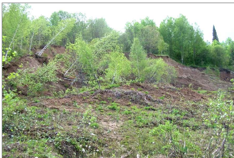
Рис. 92. Проявления оползневого процесса на уч. Залесовский, Алтайский край (ТЦ ГМСН по Алтайскому краю)
