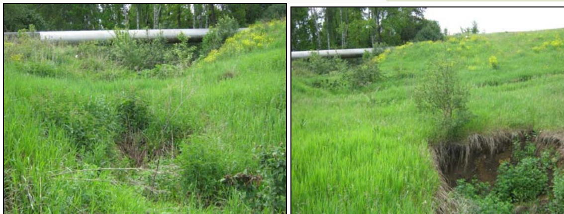
Рис. 30. Участок активизации карстово-суффозионного процесса у магистрального газопровода в Лебедянском районе, Липецкой области (ТЦ ГМСН по Липецкой области)
