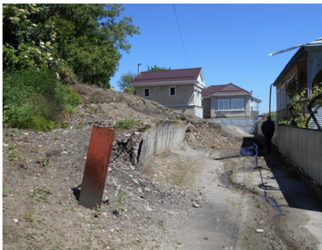
Рис. 56. Оползневые массы, перекрывшие проезжую часть автодороги по ул. Каюмова, 69 (ТЦ ГМСН по Карачаево-Черкесской Республике)
