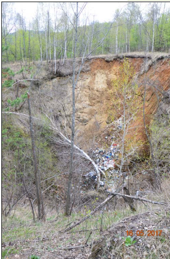
Рис. 21. Воронкообразный провал со свежими следами обрушения (п. Магнитка, Челябинская область) (ТЦ ГМСН по Челябинской области)
