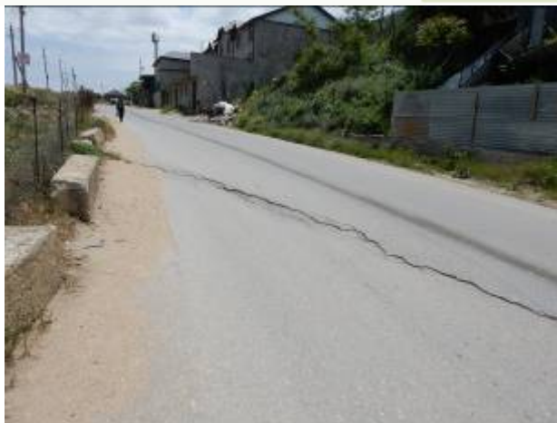
Рис. 53. Деформированная в результате активизации оползневой процесса а/д в п. Альбурикебнт (ТЦ ГМСН по Республике Дагестан)
