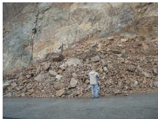
Рис. 14. Обвальные отложения на придорожном склоне, 81 км автодороги Лидога – Ванино, Хабаровский край
