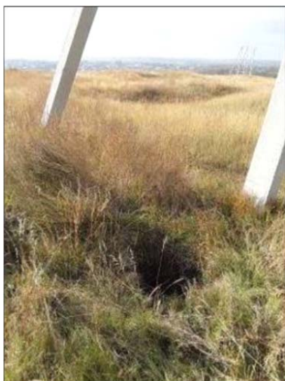
Рис.4. Провал под опорами ЛЭП, г. Сердобск, Пензенская область
