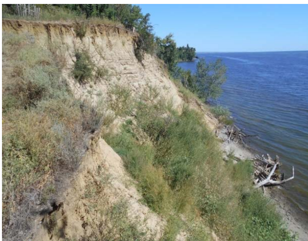
Рис. 19. Обвально-оползневой берег Волгоградского водохранилища у п. Винновка, Волгоградская область
