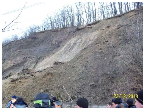
Рис. 26. Поверхность скольжения оползня на склоне юго-восточной экспозиции в 400 м к северо-востоку от с. Навагинское, Апшеронский район, Краснодарский край
