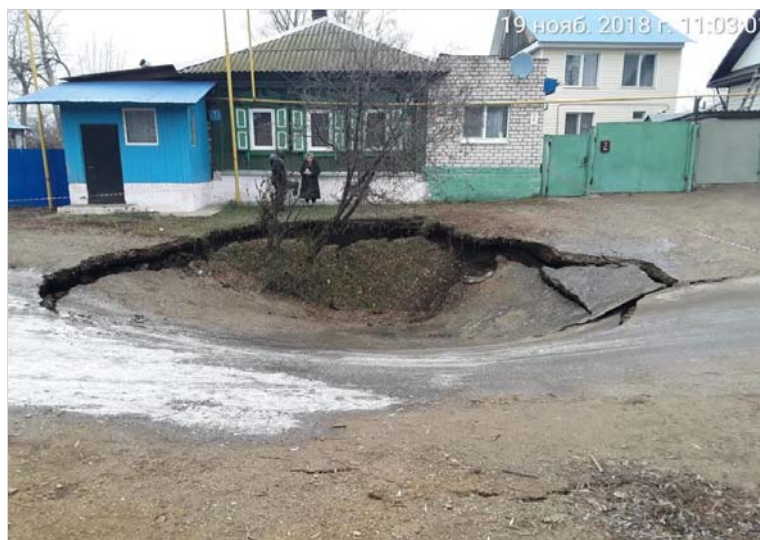
Рис.30. Карстово-суффозионный провал по ул. Болотная, д.7 в г. Уфе, Республика Башкортостан
