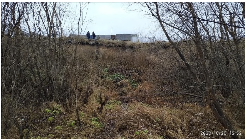
Фото 66.2020.00010-3. Вид со стороны реки на оползающий береговой эрозионный уступ Свердловская область.
