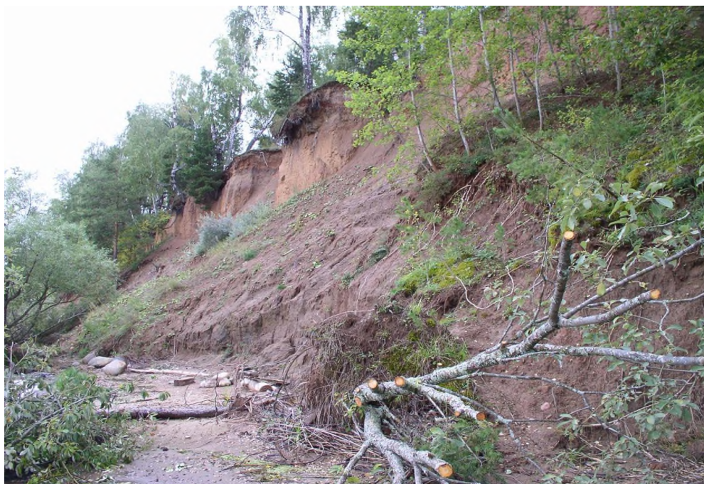
Фото 76-2020-0005 Сместившийся оползневой блок породы в п. Алтыново, Угличский район, Ярославская область
