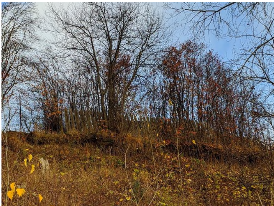
Фото 29-2020-0001 (б). г. Котлас, район ДОКа, ж/д станция Заовражье, ул. Мостозавод, 107, лестница близ ж/д моста. Активное проявление оползневого процесса
