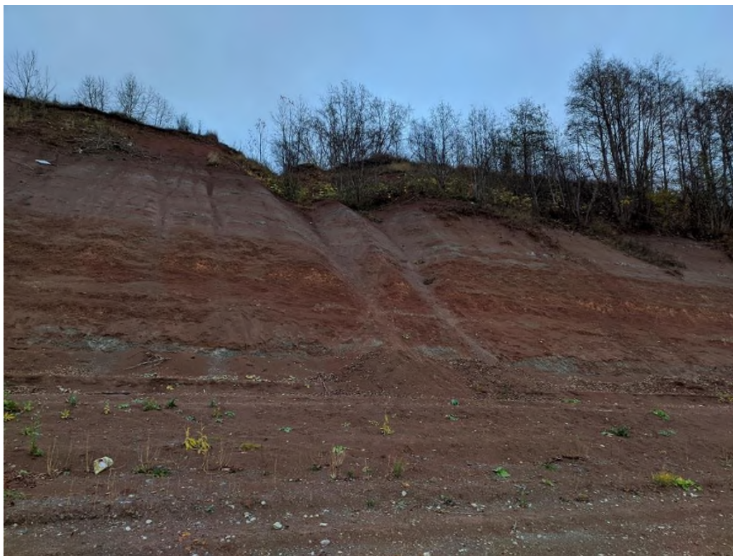
Фото 29-2020-0004 (а). район ДОКа, ж/д станция Заовражье. Активное проявление оползневой процесса
