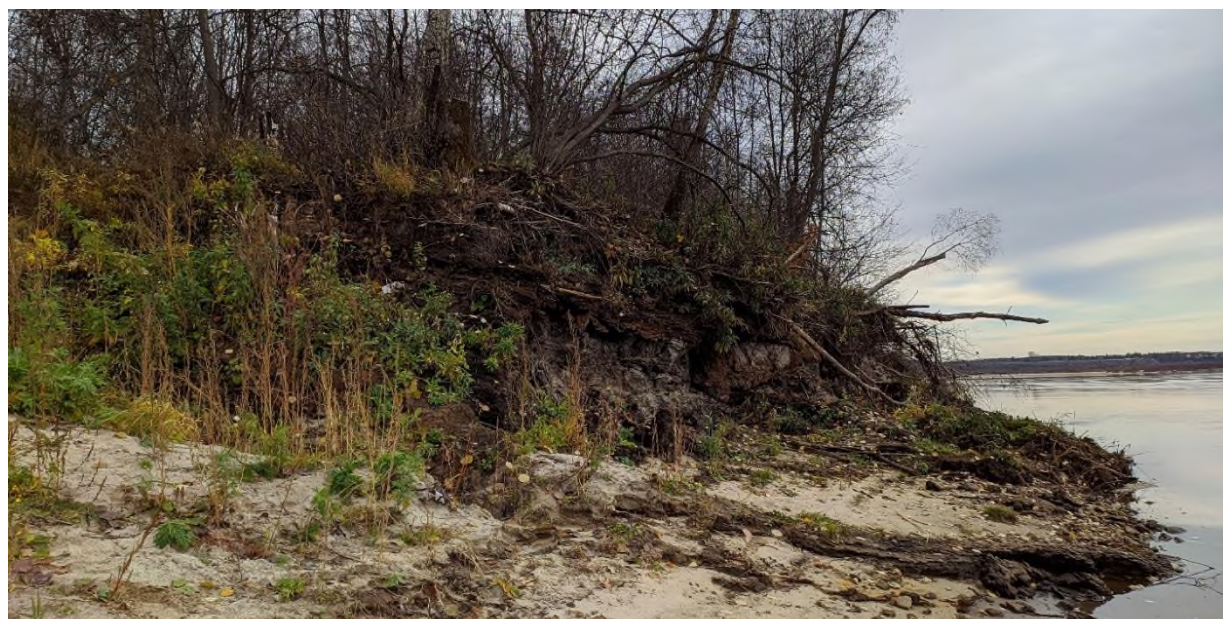
Фото 29-2020-0006 (в). МО Приводинское, между д.д. Новинки – Пускино. Активное проявление оползневого процесса
