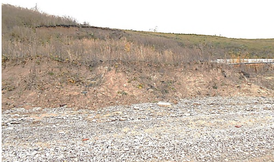
Фото 16.2020.0003. Активизация и сход оползня скольжения на южном конце набережной пгт. Камское Устье, Республика Татарстан
