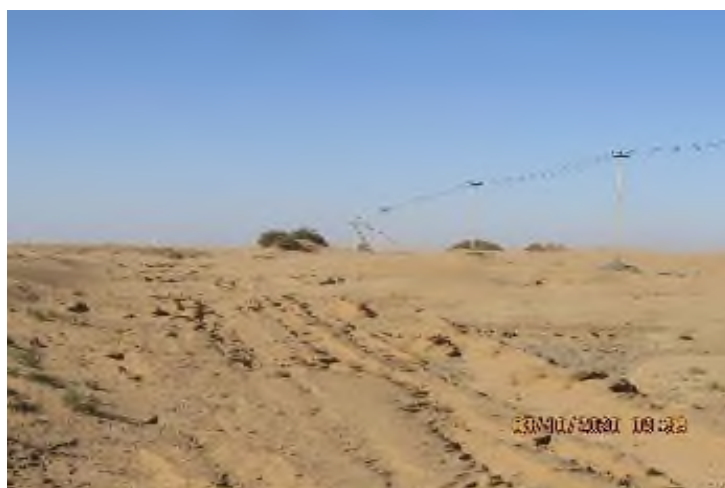
Фото 08.2020.0027. Черноземельский район, участок грунтовой а/дороги в 6,5 км юго-восточнее п. Чанта
