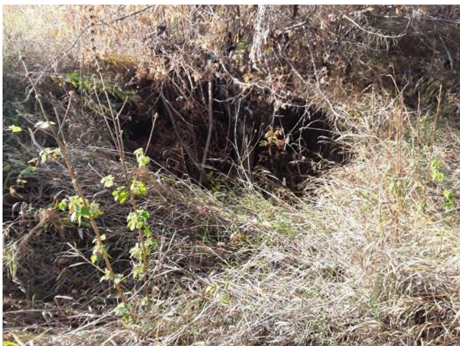
Рис. 63.2020.0003. Новый карстовый провал, образовавшийся летом 2020 г. в 85 м северо-восточнее 3-х этажного здания Поста ЭЦ ст. Сызрань-1, г.Сызрань, Самарская область.
