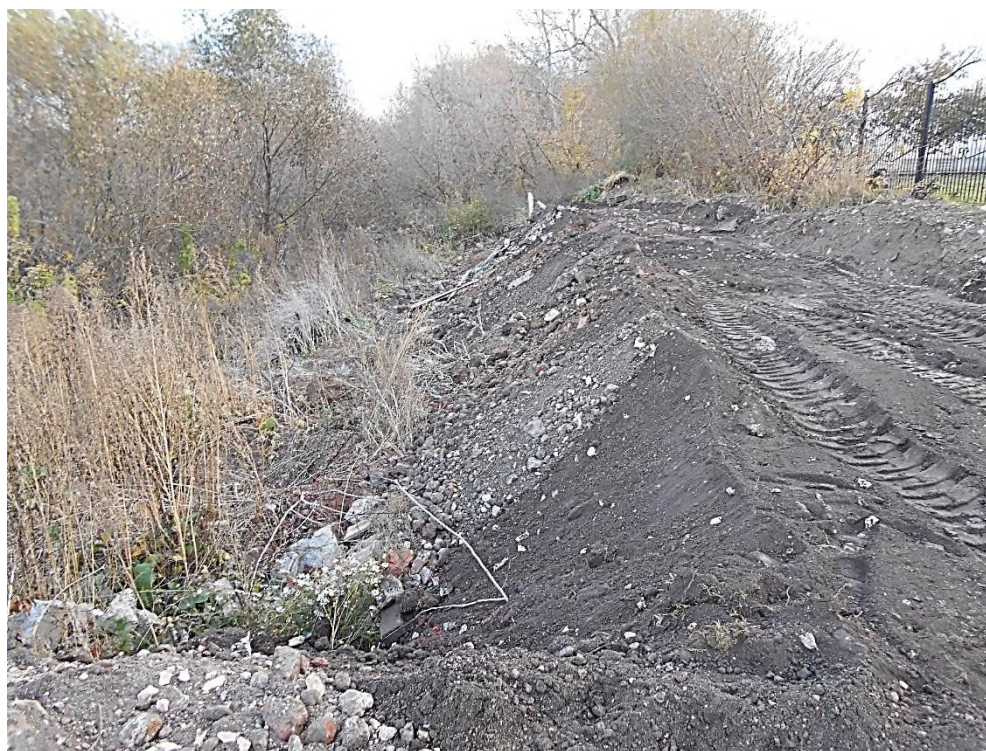
Фото 16.2020.0002. Активизация и сход оползня проседания, засыпка свежим привозным грунтом по пер. Фрунзе д.7д, г. Чистополь, Республика Татарстан
