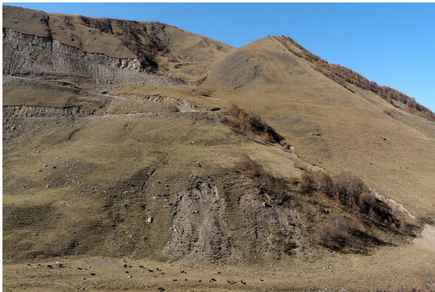
Фото 07.2020.0019. Оползень на левом борту долины р. Малка (в центре снимка), активность которого приводит к деформации автодороги Кисловодск - Долина нарзанов – Джилысу. Вид с правого борта долины р. Малка
