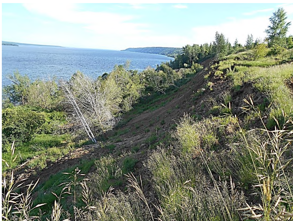
Фото 16.2020.0006. Активизация и продолжение схода оползня на волжском склоне южнее 3 створа, г. Тетюши, Республика Татарстан
