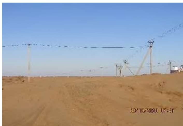
Фото 08.2020.0019. Черноземельский район, участок грунтовой а/дороги в 17 км юго-восточнее п. Чанта
