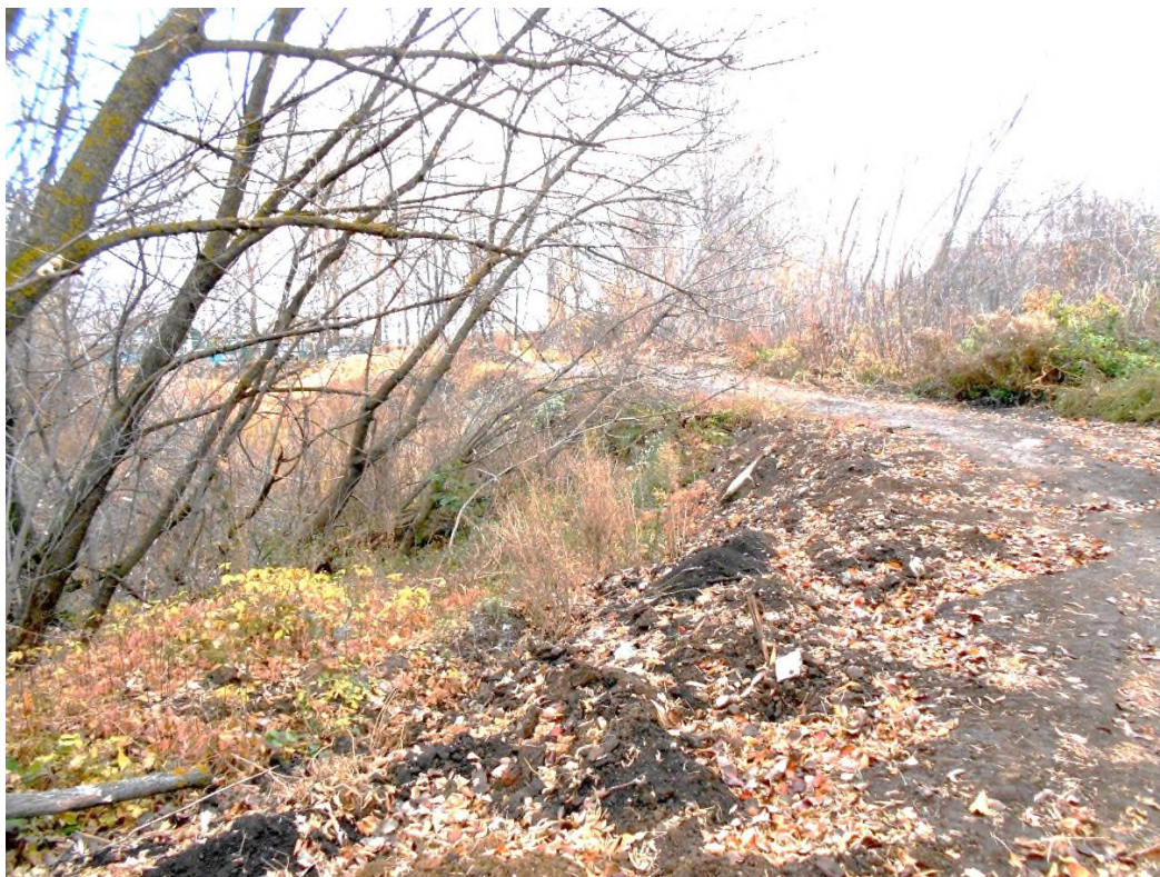
Фото 16.2020.0005. Активизация и продолжение схода оползня проседания по ул. Вахитова д.2, г. Тетюши, Республика Татарстан
