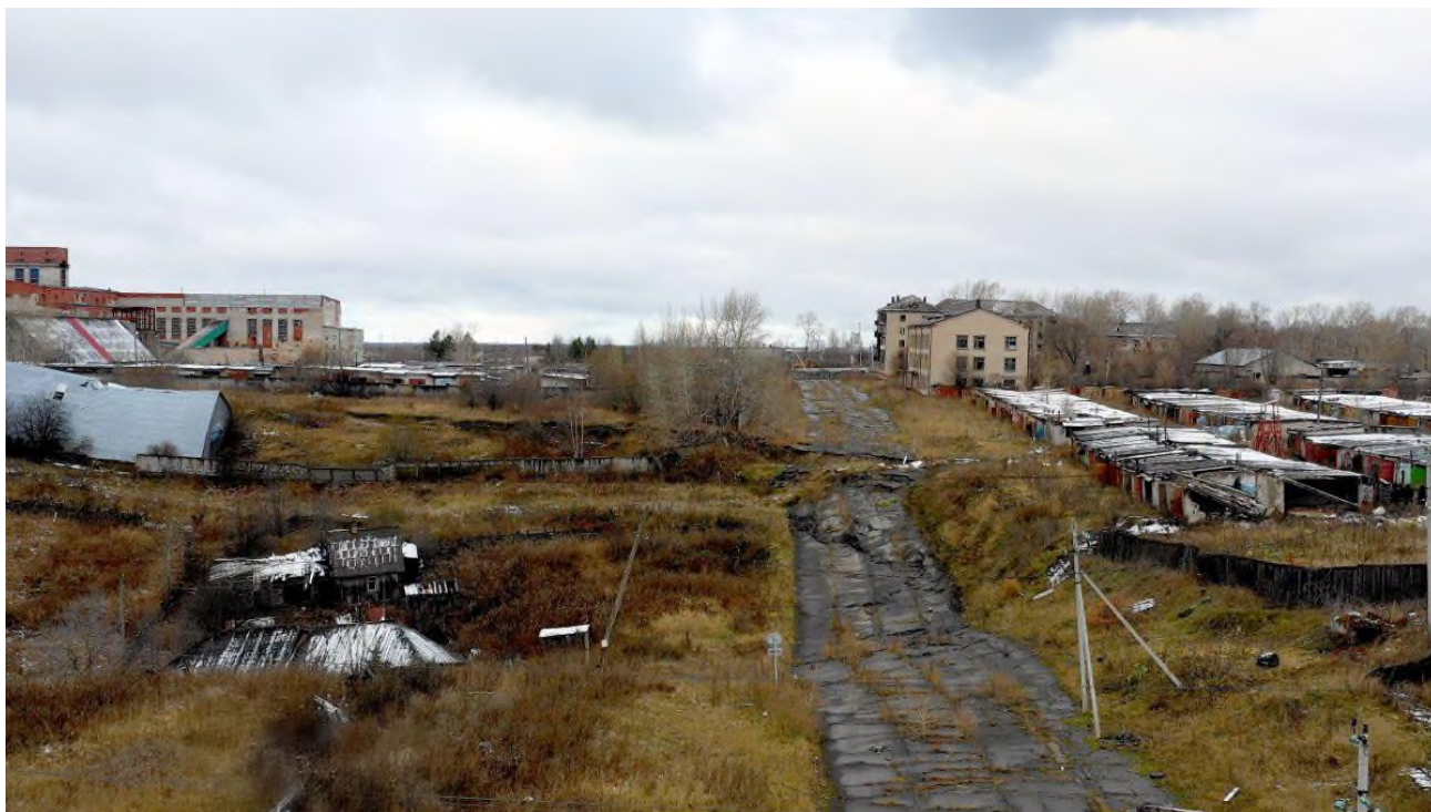
Фото 59.2020.0004. Мульда оседания поверхности и разрушенное асфальтовое покрытие улицы М. Горького, г. Березники, октябрь 2020 г. Пермский край
