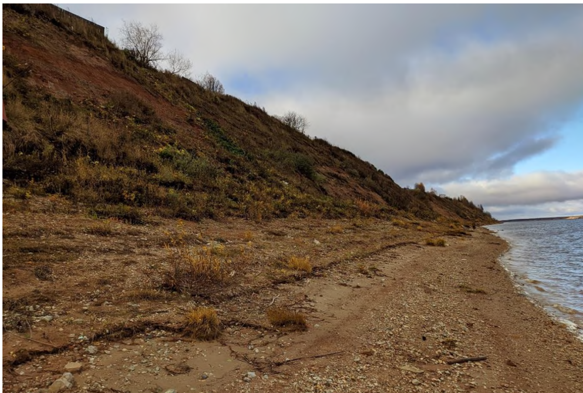
Фото 29-2020-0010 (а). МО Телеговское, д. Марковская, 21. Активное проявление оползневого процесса
