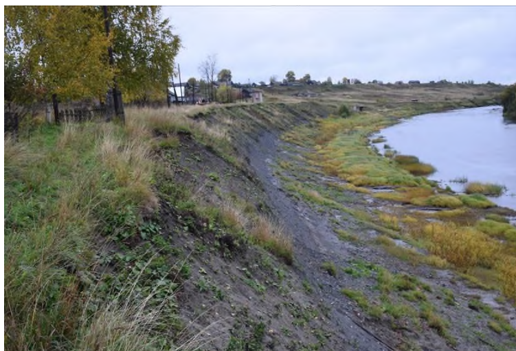
Фото 43.2020.0009. Развитие обвально-осыпного процесса на участке склона р. Кама в с. Лойно Верхнекамского района Кировской области
