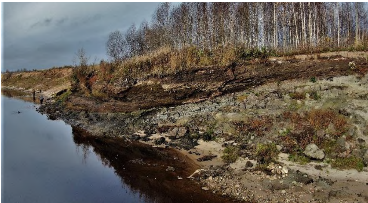
Фото 29-2020-0006 (б). МО Приводинское, между д.д. Новинки – Пускино. Активное проявление оползневого процесса
