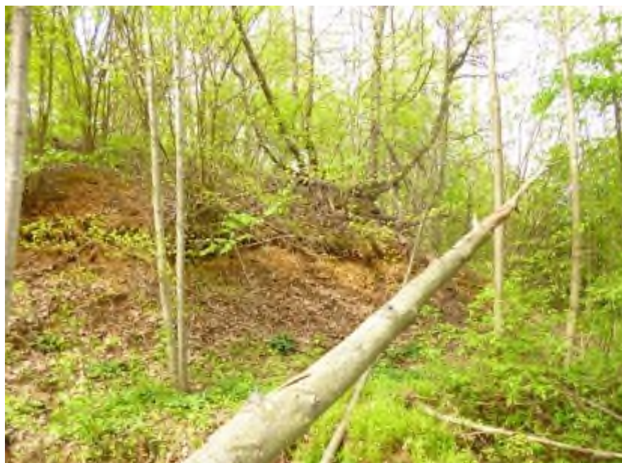
Фото 66-2020-0005. Сместившийся оползневой блок породы по ул. Кловская, г. Смоленск, Смоленская область
