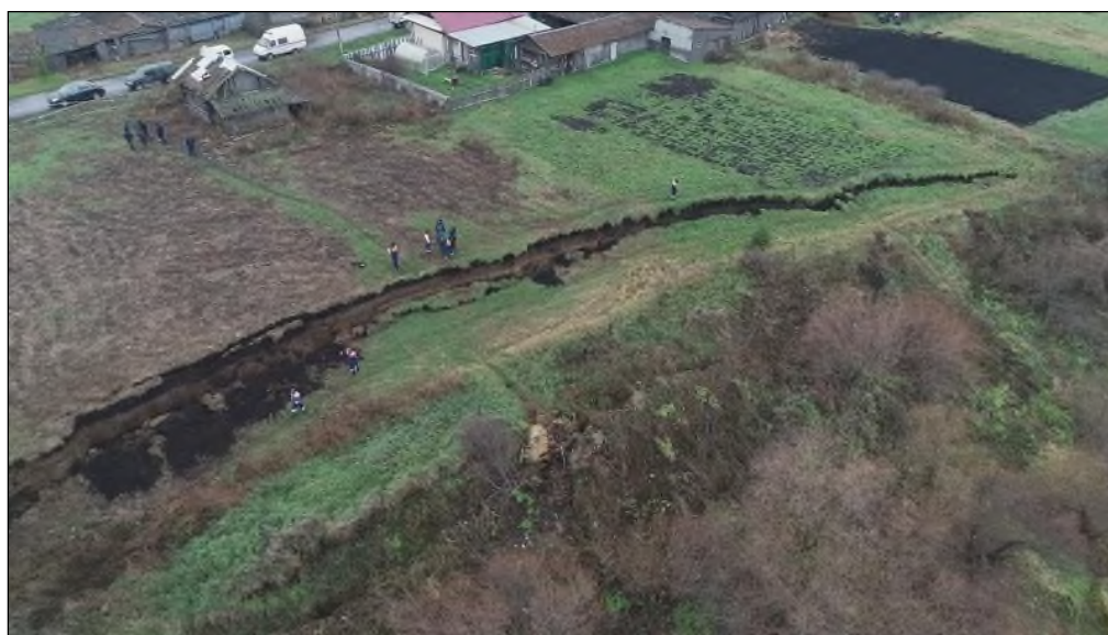
Фото 66.2020.00010-2. Общий вид участка активизации оползневого процесса в д. Верхняя Иленка, Свердловская область.
