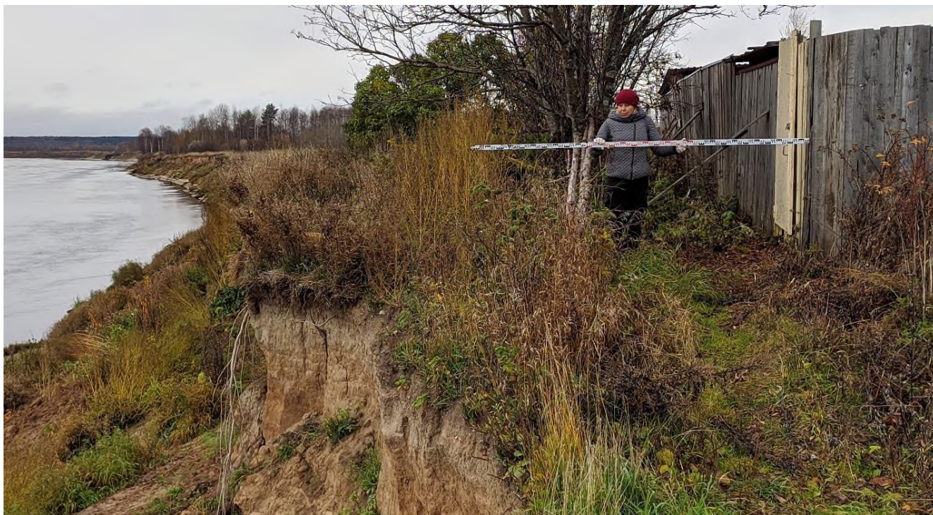
Фото 29-2020-0005 (б). МО Приводинское, д. Пускино. Активное проявление оползневого процесса
