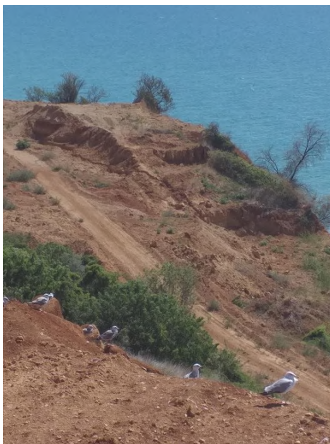
Фото № 67.2020.0005-1. Оползневой процесс в Языковой балке. Нахимовский МО г. Севастополь.
