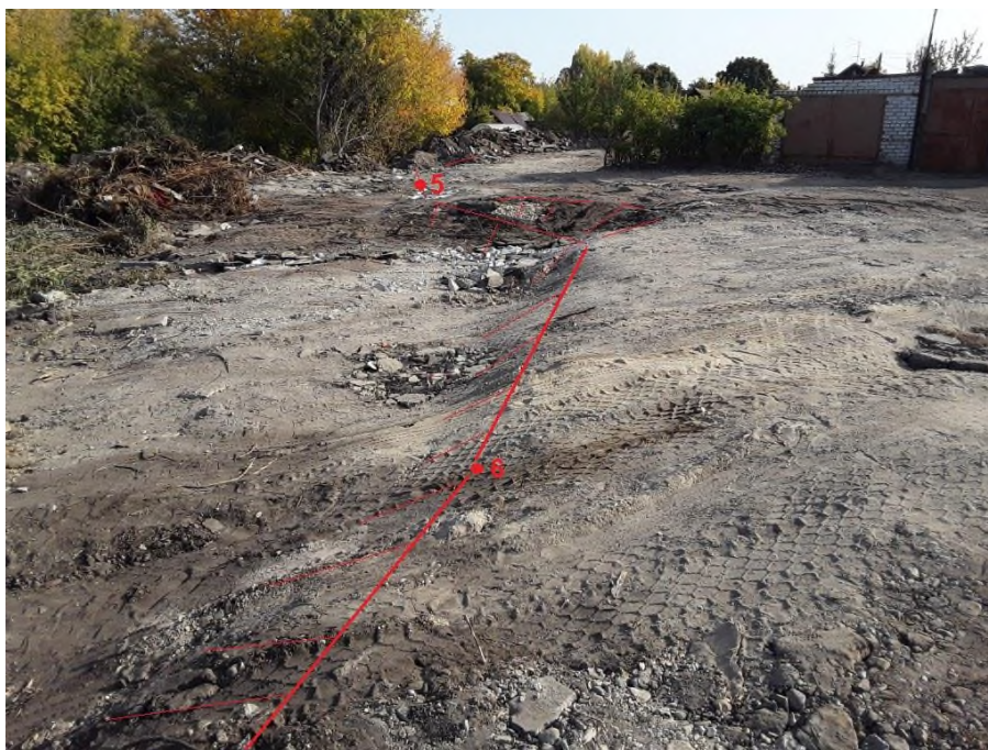
Рис. 63.2020.0001. Бровка срыва оползня, проходящая по границам домовладений №»1 и 2 по ул. Раменская, г.Сызрань, Самарская область.
