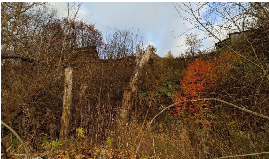
Фото 29-2020-0001 (в). г. Котлас, район ДОКа, ж/д станция Заовражье, ул. Мостозавод, 107, лестница близ ж/д моста. Активное проявление оползневого процесса
