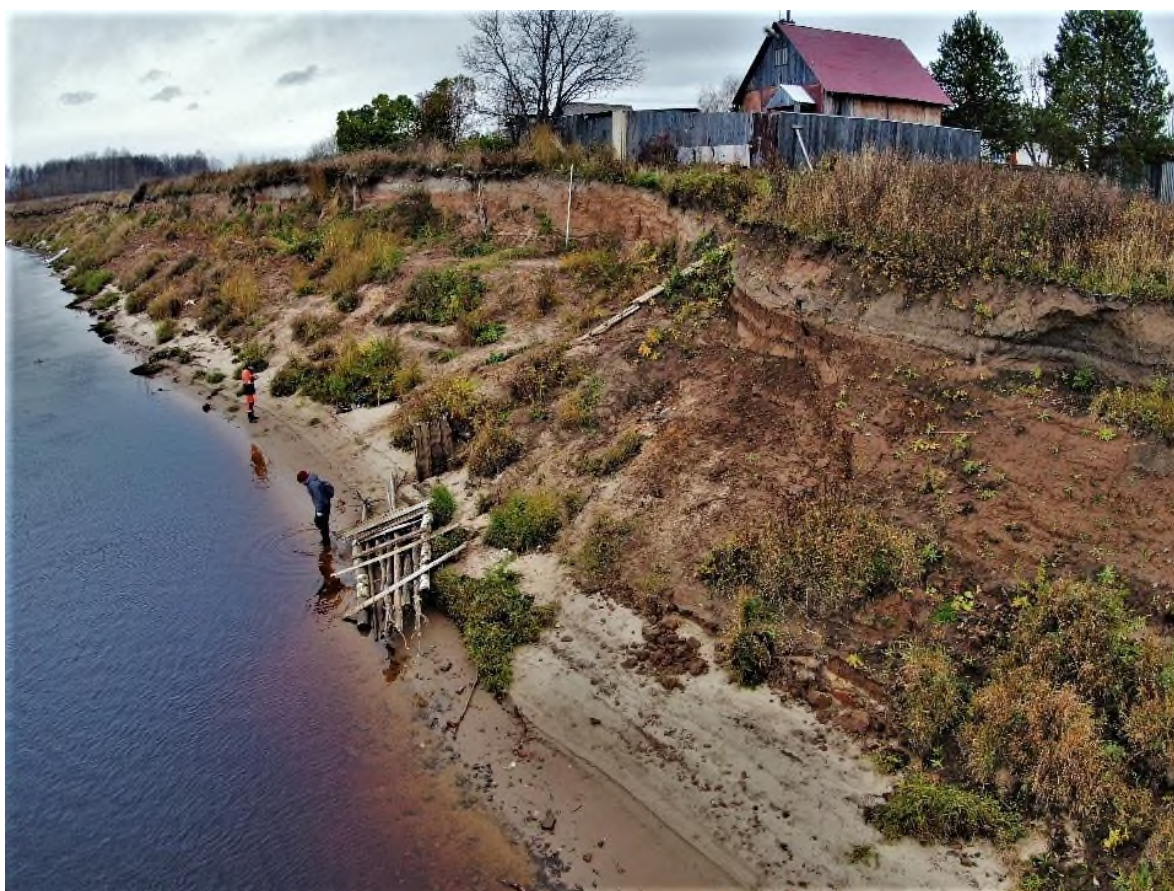
Фото 29-2020-0005 (а). МО Приводинское, д. Пускино. Активное проявление оползневого процесса
