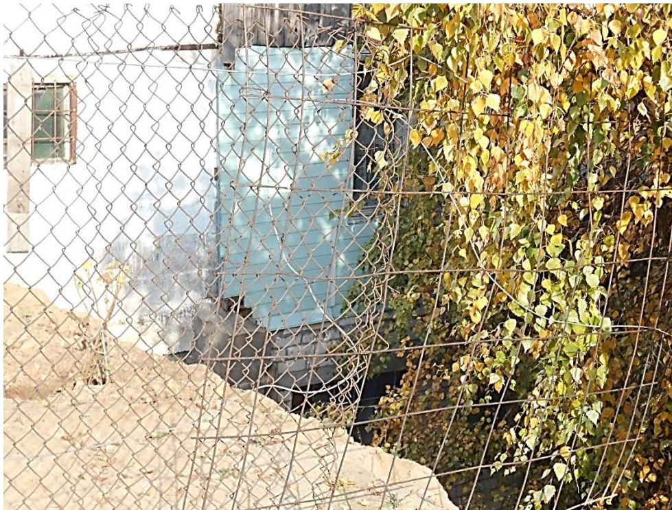
Фото 16.2020.0009. Обрыв оползня у южной стены дома 47а по ул. Бадаева, г. Казань, Республика Татарстан
