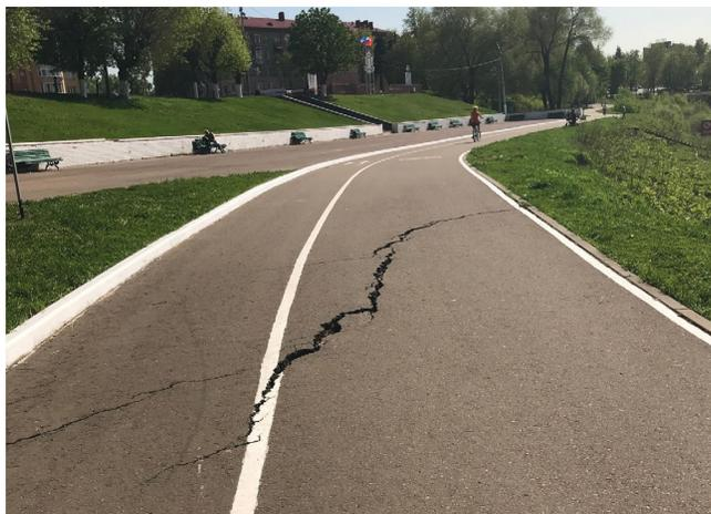
**Рис. 2.21** Трещина в асфальтированной дорожной покрытии г. Раменское, Московская область
