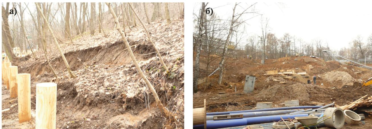
**Рис. 2.16** Оползневой склон Воробьевых гор: а) стенка срыва активного оползня; б) строительство канатной дороги, г. Москва
