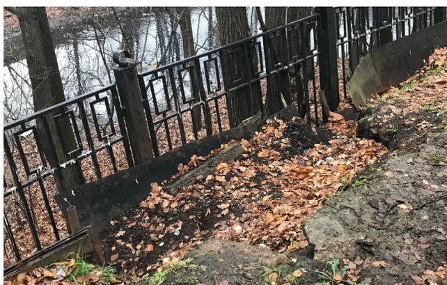
**Рис. 2.19** Оползень в приобводной части склона руч. Воронинский, ул. Академика Бакулева д.6, г. Москва
