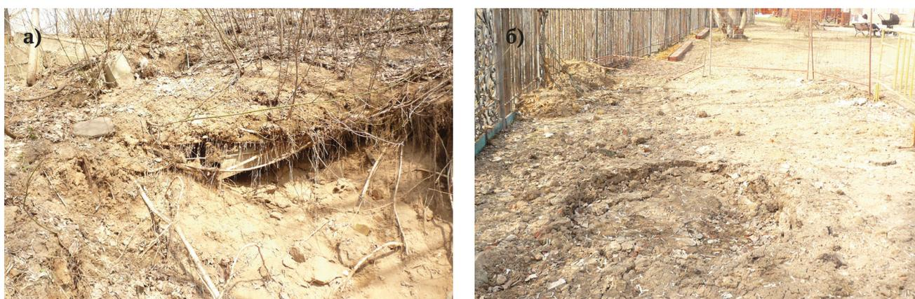
**Рис.2.17** Активизация оползневой процесс на территории Храма Живоначальной Троицы: а) суффозионный оползень; б) просевший грунт вдоль бровки склона, по Карамышевскому проезду, г. Москва
