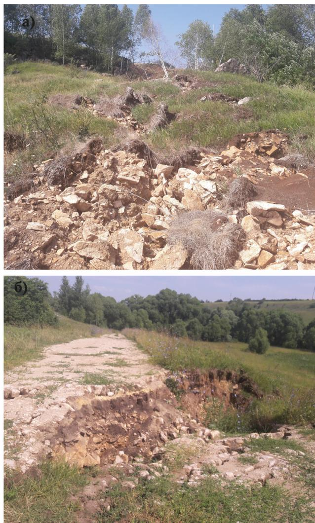
**Рис. 2.28 Активизации оползневого процесса в отвалах карьера на правом берегу р. Проня: а) оползень; б) разрушенная часть грунтовой дороги, окраина с. Беломестное, Новомосковский район, Тульская область**
