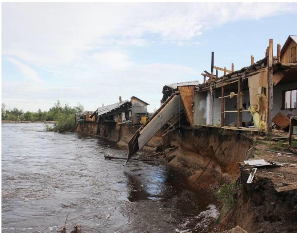
Рис. 2.37 Гравитационно-эрозионные процессы в с. Биофабрика, Забайкальский край
