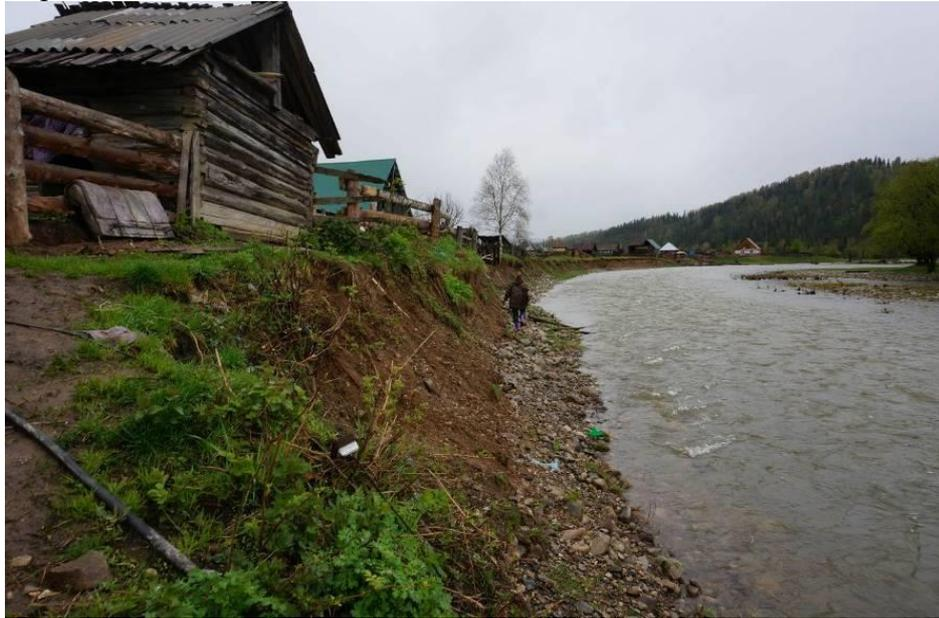
Рис. 2.33 Хозяйственные строения в зоне разрушения берегового уступа в с. Курмач-Байгол, Республика Алтай
