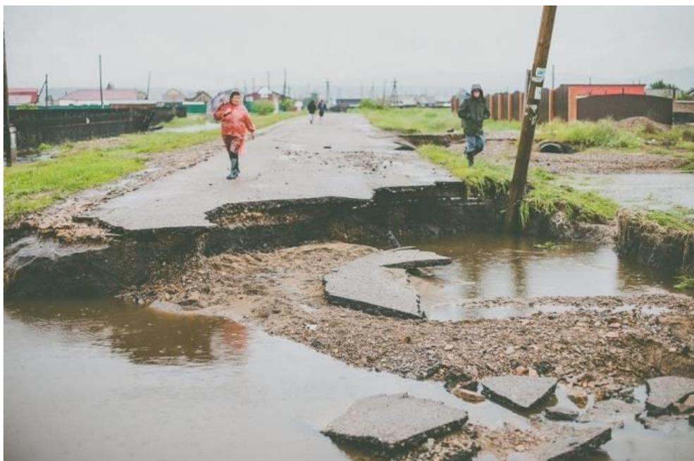
Рис. 2.36 Разрушение линейных инженерных объектов гравитационно-эрозионными процессами, Забайкальский край
