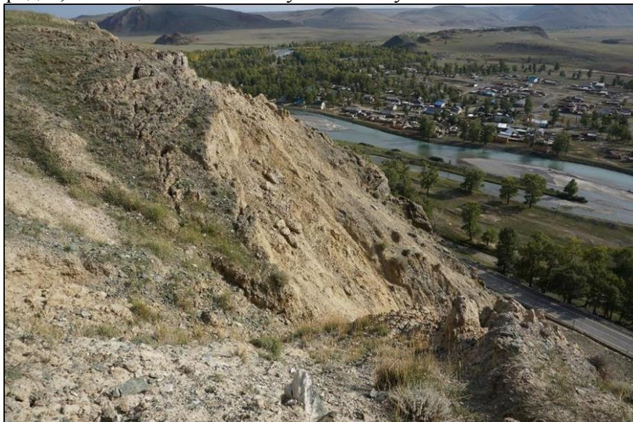
Рис. 2.24 Развитие оползневых процессов на склоне над Чуйским трактом.
