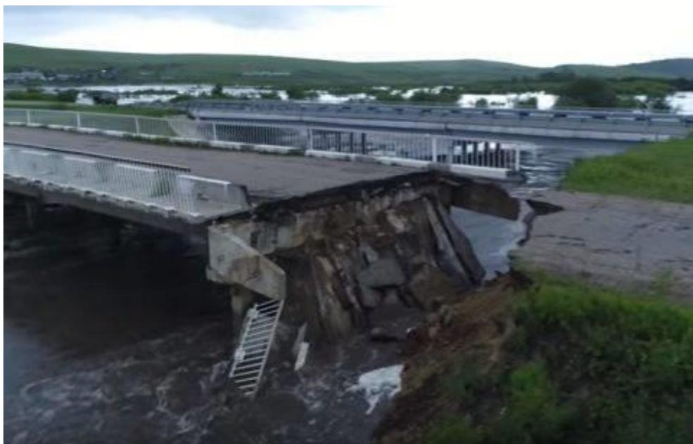
Рис. 2.35 Разрушение автомобильного моста через р. Кия, Забайкальский край
