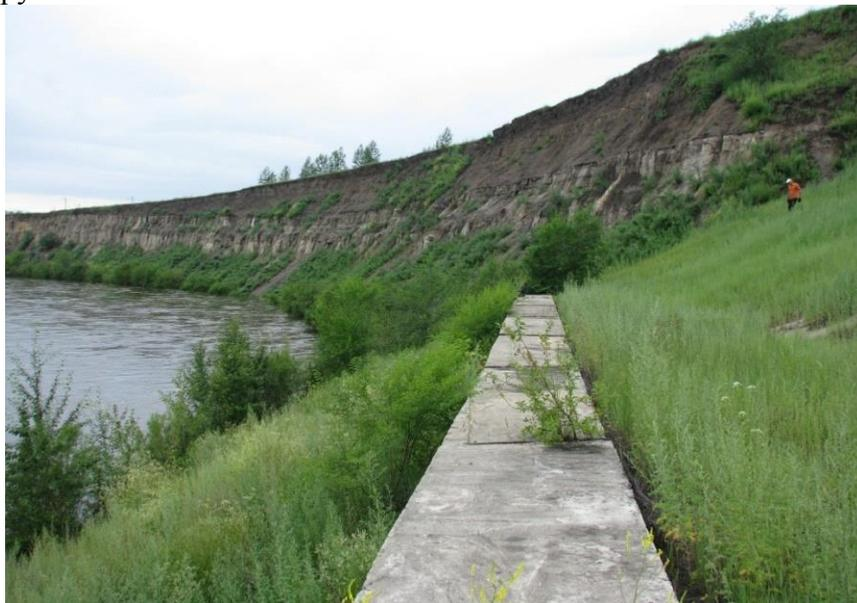
Рис. 2.43 Защитные сооружения на берегу р. Ингода, Забайкальский край
