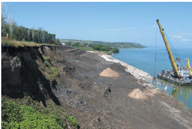
Рис. 2.44. Развитие гравитационно-абразионных процессов в районе г.Сенгилей, Ульяновская область (ТЦ ГМСН по Ульяновской области)
