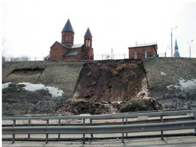
Рис. 2.19. Оползни на съезде к метромосту, г.Нижний Новгород (ФГУГП “Волгагеология”)
