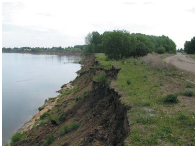
Рис. 2.41. Разрушение берегового уступа вблизи участка автодороги Зырянское–Причупымск, Томская область (РЦ ГМСН по Сибирскому федеральному округу)
