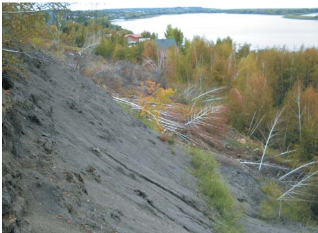
Рис. 2.22. Центральная часть оползня “Зоналка”, Саратовская область (ФГУП “Волгагеология”)
