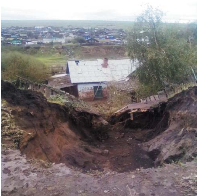
Рис. 2.34. Развитие овражной эрозии в г.Кяхта после пивневых дождей, Республика Бурятия (РЦ ГМСН по Сибирскому федеральному округу)
