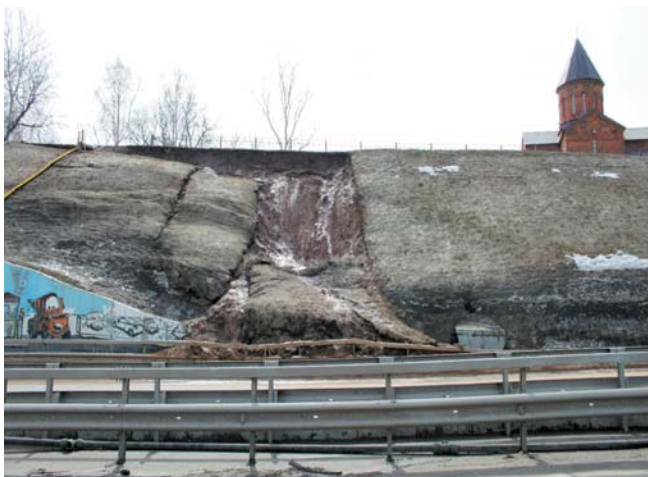
Рис. 2.19. Оползни на съезде к метромосту, г.Нижний Новгород (ФГУГП “Волгагеология”)
