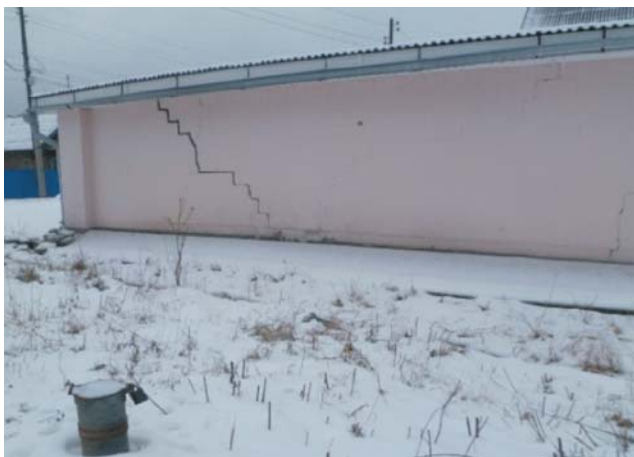
Рис. 2.52. Деформации строений в п.Крыпатовском в результате сдвижения пород над шахтным полем, Свердловская область (РЦ ГМСН по Уральскому федеральному округу)
