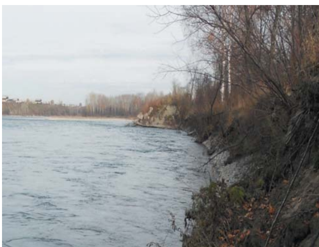
Рис. 2.39. Размыв дамбы обвалования вокруг Катунского водозабора, Республика Алтай (РЦ ГМСН по Сибирскому федеральному округу)
