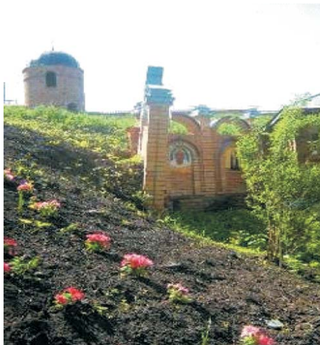
Рис. 2.3. Деформации строений в п.Рощинский, Пупецкая область (ТЦ ГМСН “Пупецкгеомониторинг”)
