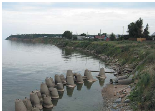
Рис. 2.46. Размыв берега на территории с.Старый Белый Яр, Ульяновская область (ТЦ ГМСН по Ульяновской области)
