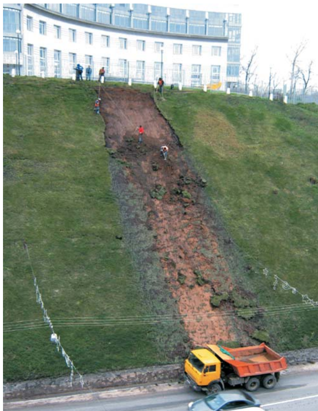
Рис. 2.20. Оползень на Зеленском съезде, г.Нижний Новгород (ФГУП “Волгагеология”)
