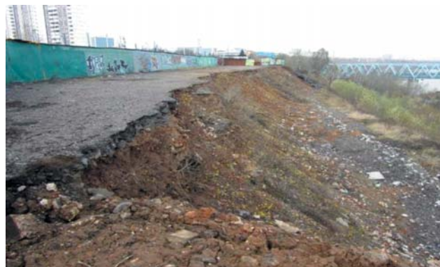
Рис. 2.6. Стенка срыва оползня на участке “Москворечье”, г.Москва (ОАО “Геоцентр-Москва”)
