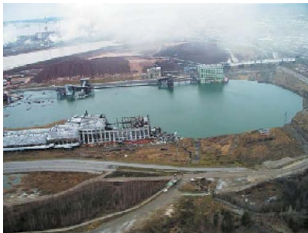
Рис. 2.49. Провал №1 на БКПРУ-1 по состоянию на 01.11.2012 г., Пермский край (Верхнекамский центр МГС ОАО “Уралкалий”)
