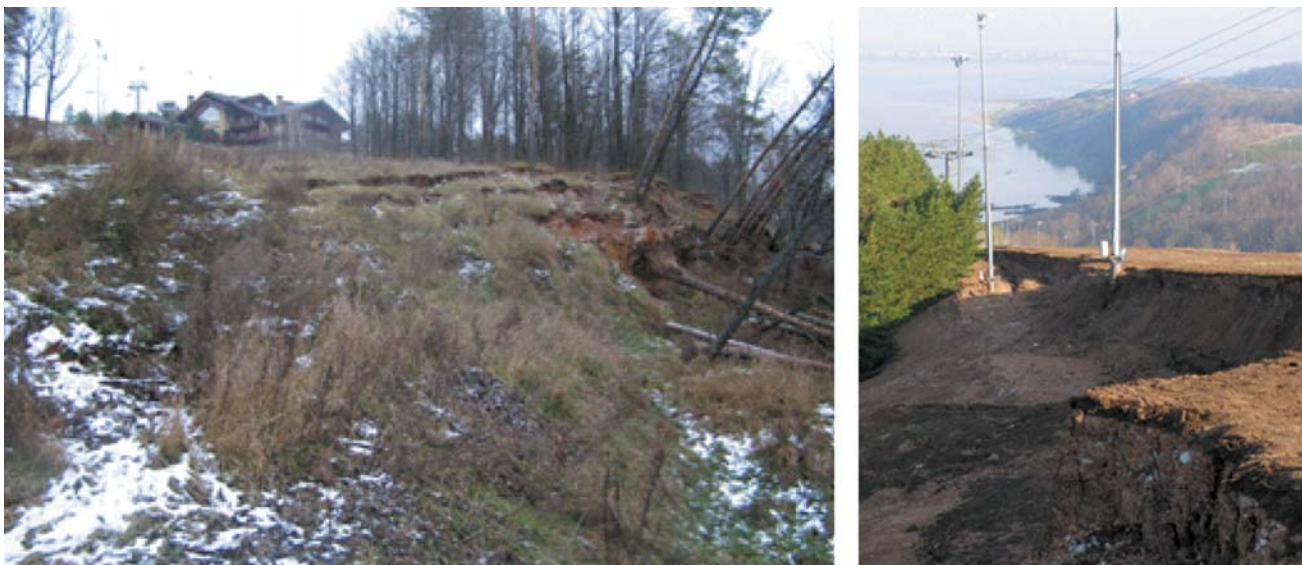
Рис. 2.17. Оползневые деформации на территории ГСОК “Казань”, Республика Татарстан (ТЦ ГМСН по Республике Татарстан)
