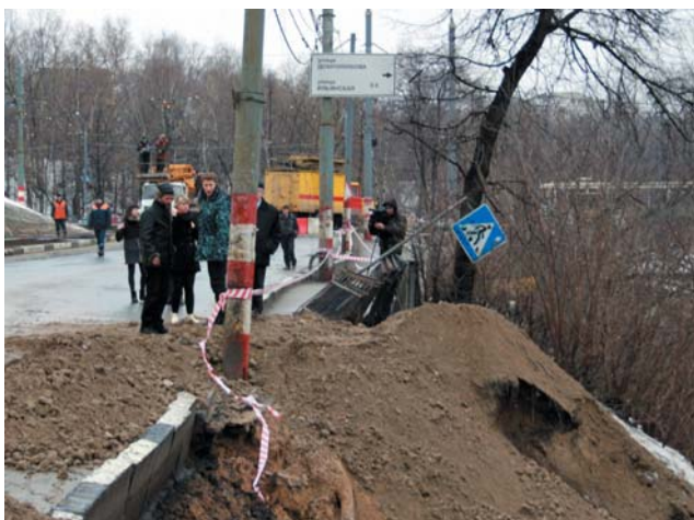
Рис. 2.18. Оползень в Почаинском овраге, г.Нижний Новгород (ФГУГП “Волгагеология”)
