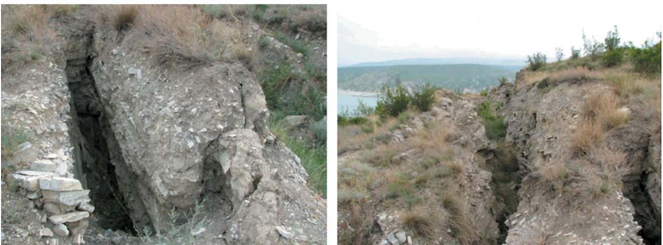
Рис. 2.14. Расширение оползневых трещин на оползневом массиве №1 Чиркейского участка Сулакской наблюдательной площадки (ГУП РЦ “Дагестангеомониторинг”)
