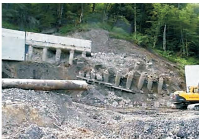
**Рис. 2.10. Разрушенный в результате активизации оползневого процесса участок подпорной стены в верховом откосе подъездной автодороги к биатлонному комплексу (ТЦ ГМСН по Краснодарскому краю)**
