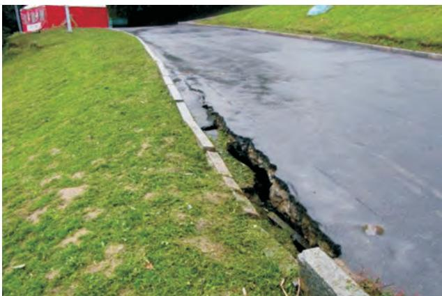
**Рис. 2.8. Трещина закопа на поверхности асфальтированной дороги, вблизи канатно-кресельного подъемника, в пределах наблюдательного участка “Воробьевы горы” в г.Москве (ТЦ ГМСН по г.Москва)**
