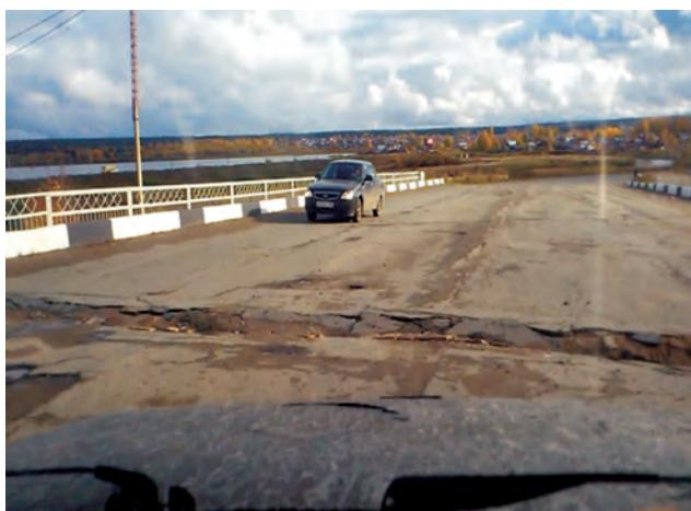
Рис. 2.47. Деформированный мост на участке автодороги Березники–Чкалов по состоянию на август 2013 г. (ТЦ ГМСН по Пермскому краю)
