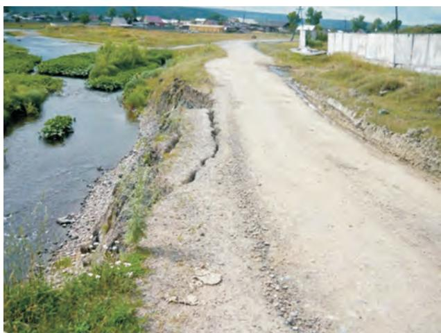
**Рис. 2.26. Деформированный участок автодороги в п.Памяти 13 Борцов, в пределах наблюдательного участка “Стеклозавод” (ТЦ ГМСН по Красноярскому краю)**
