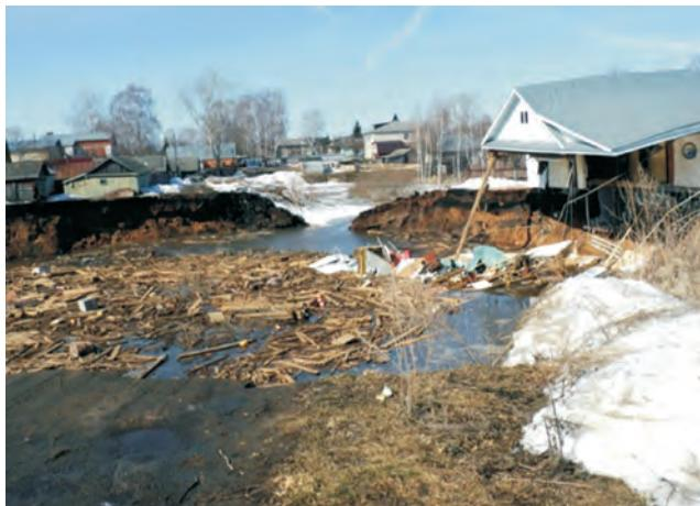
**Рис. 2.34. Разрушенные и деформированные сооружения в результате активизации карстово-суффозионных процессов в пгт.Бутурлино (ТЦ ГМСН по Нижегородской области)**
