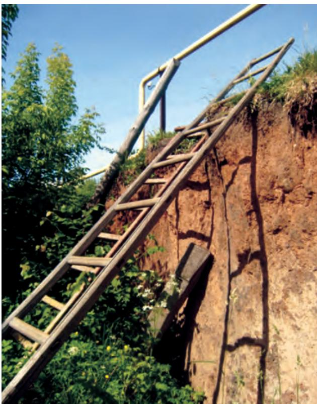
Рис. 2.3. Газопровод, проходящий по бровке активного оползня в п.Новописцово (ТЦ ГМСН по Ивановской области)
