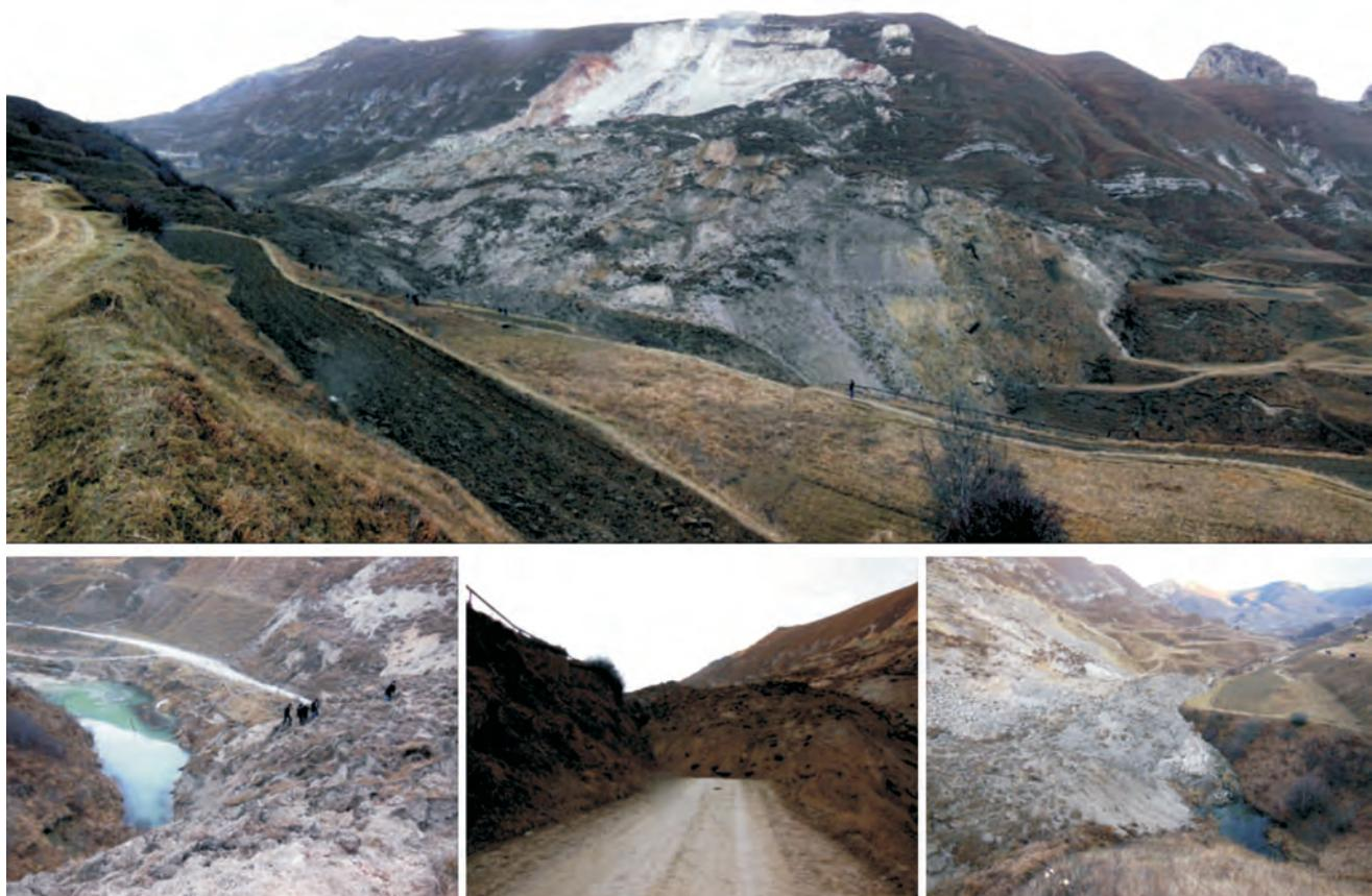
Рис. 2.13. Разрушенный участок автодороги Шукты—Цуликана в результате катастрофической активизации оползневого процесса (ТЦ ГМСН по Республике Дагестан)
