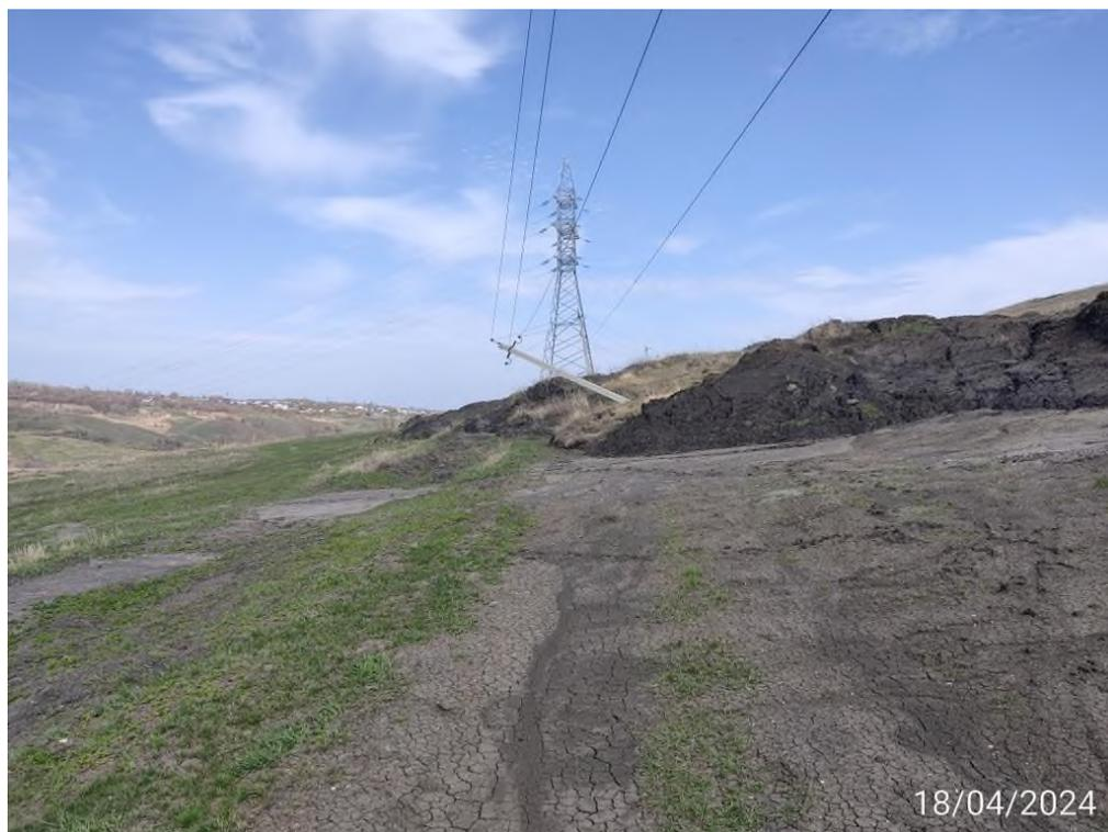
Фото 63-11-00098. Основание склона. Наплывшие грунты на автодорогу и деформированная опора ЛЭП ВЛ-10кВ, г.Сызрань, Самарская область.
