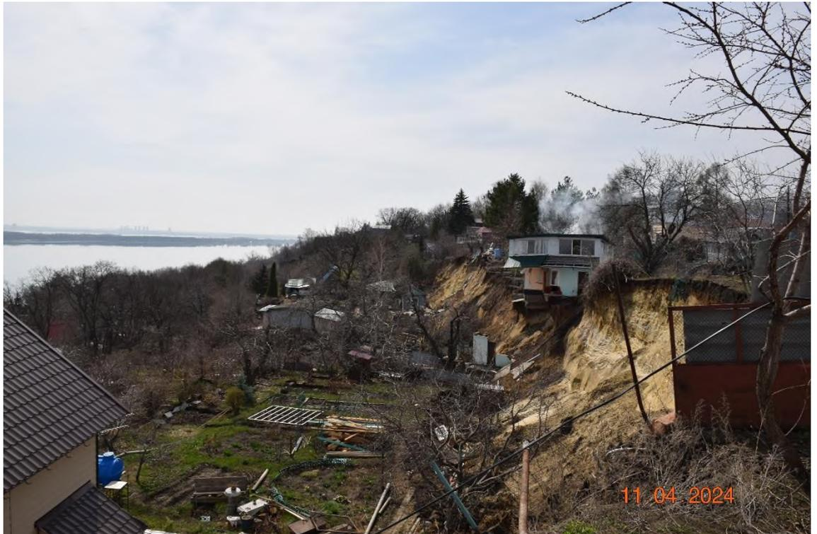
Фото 64-11-00039. Стенка срыва, нависание постройки, блок с вертикальным смещением с постройками «СНТ Труженник-65», г. Саратов, Саратовская область
