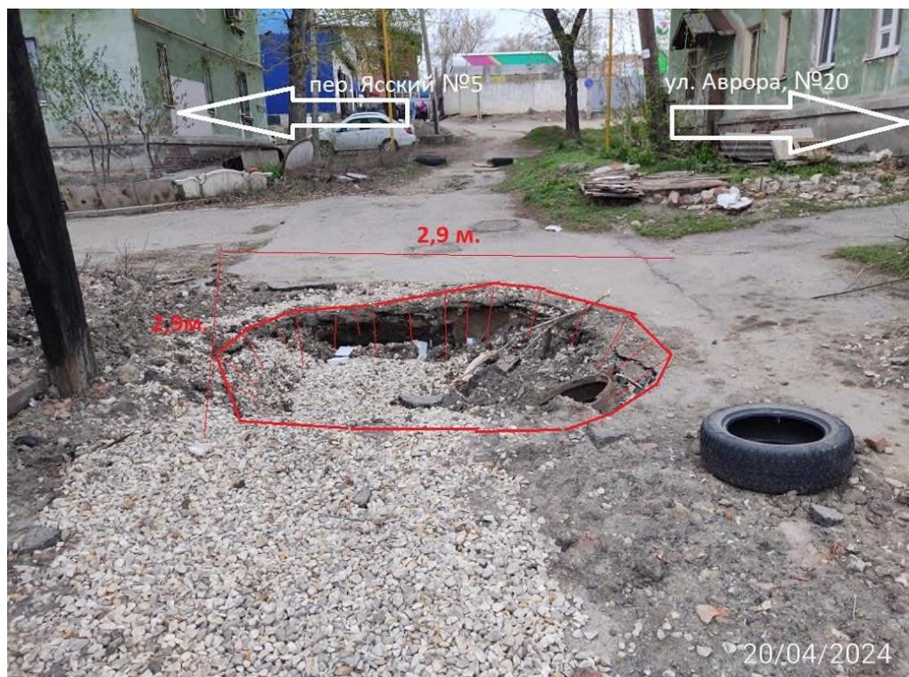
Фото 63-05-00047. Провал №00047, образовавшийся в 8 метрах западнее дома №20 по ул. Аврора, г. Самара, Самарская область.
