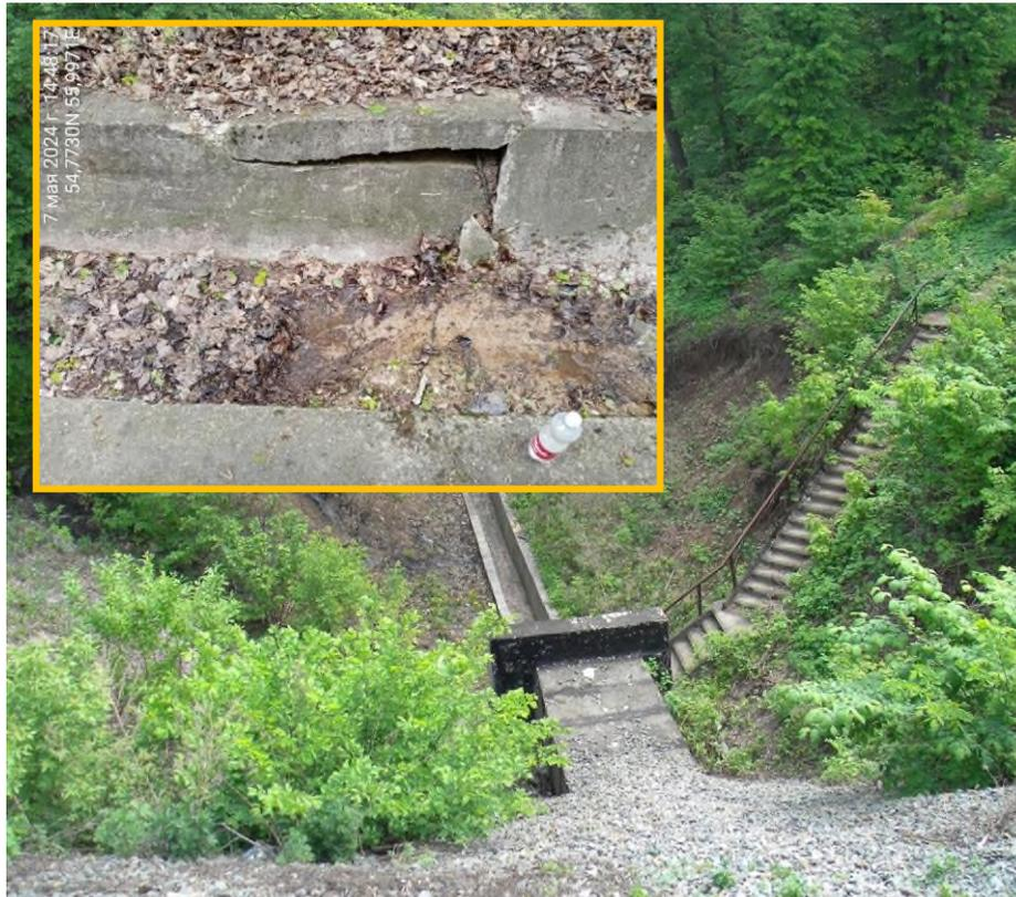
Фото 02-05-00199 Разрушение бетонного лотка над воронкой 9/9-10 в овраге 9 «Южный участок» Уфимского косогора. Республика Башкортостан
