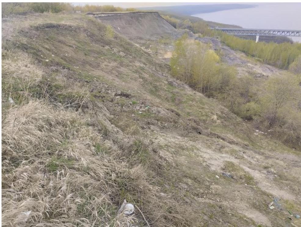
Фото 73-11-00003. головная часть, бровка сползания грунта
