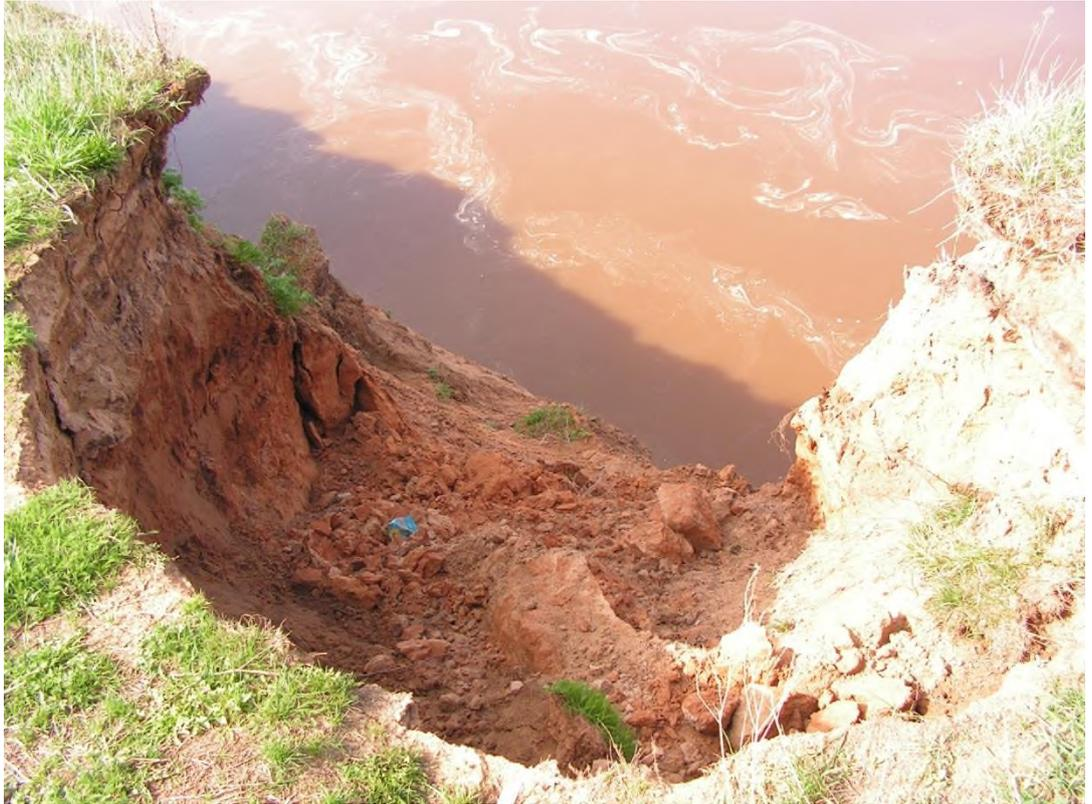
Фото 18-11-00020. Оползневой процесс. Участок дежурных инженерно-геологических обследований «Крымская Слудка», Кизнерский район, Удмуртская Республика. Апрель 2024 г. Оползень вязкопластического течения в т.н.7
