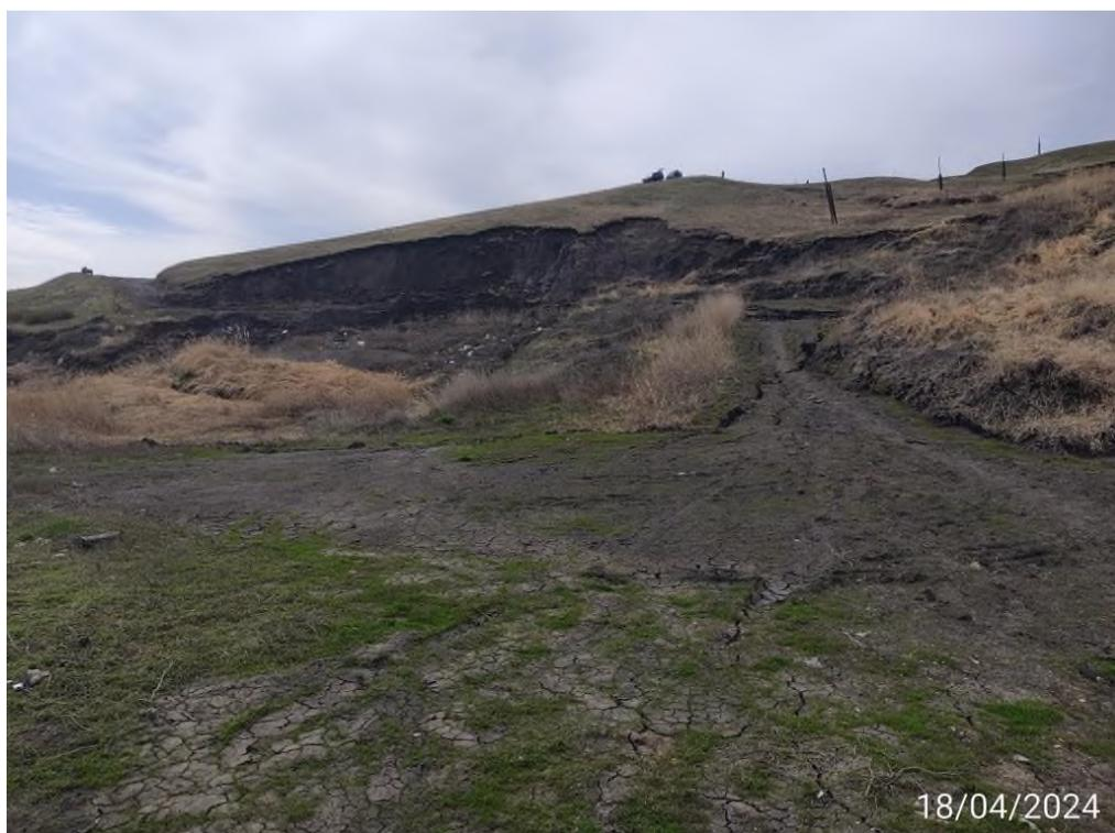
Фото 63-11-00078. Средняя часть оползня №00078. Деформированная грунтовая автодорога и линия ЛЭП, г. Сызрань, Самарская область.
