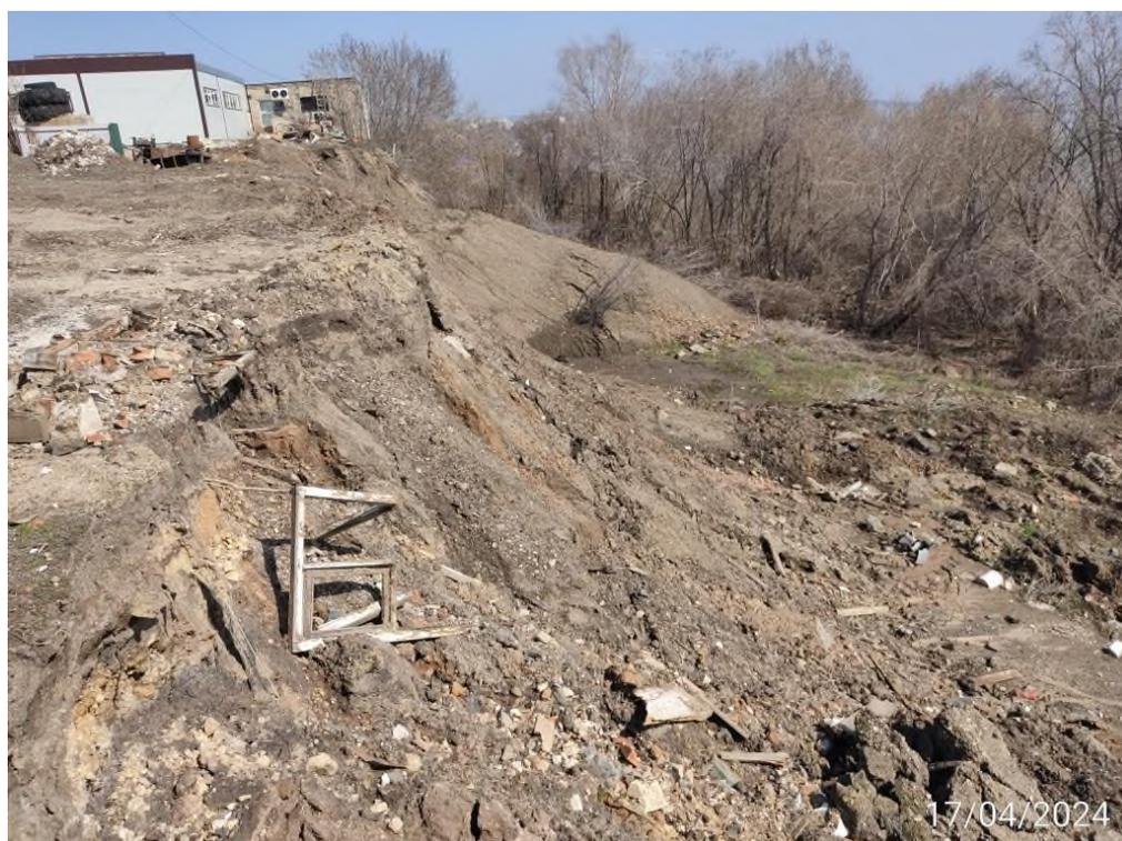
Фото 63-11-00004. Отсевший блок общей площадью 430м2, в верхней части оползня №00004, г. Сызрань, Самарская область.
