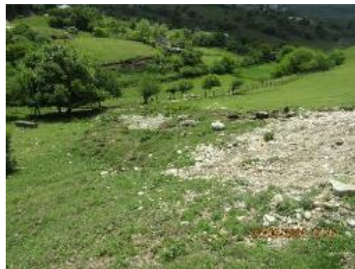
Фото 09.2024.0002. Оползневое проявление в низовом откосе автодороги на северной окраине а. Эльтаркач
