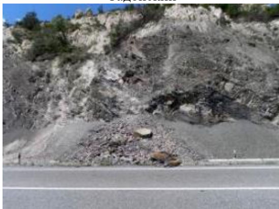
15-12-00131. Обвально-осыпной участок ТрансКАМ 493
