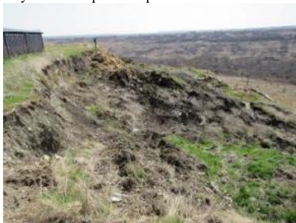
Фото. 26-11-00157. Смещения на локальном участке в головной и верхней части зоны транзита
