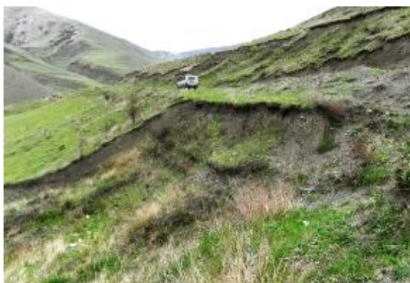
15-11-00128. Оползень Дзуарикауский Нижний I
