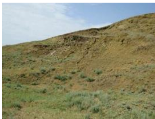
Фото. 26-11-00114. Смещения низкой интенсивности в зоне транзита у правого борта оползня
