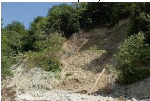
Фото 07-11-00001 – оползень 07-11-00001 (активизация июнь 2024г.), в правом борту р. Белая, в 500 м к ЮЗ от устья р. Белая, г.о. Нальчик. (14.06.2024 г., ООО «Каббалкгеомониторинг»)
