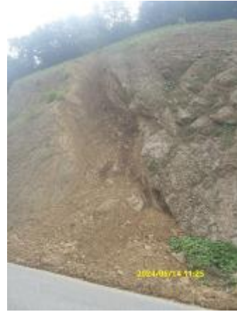
Фото 20-11-00461. Шатойский район. с.Пионерское в 0,66км южнее на автодороге с.Пионерское – с.Чишки. Перекрыло автодорогу с покрытием на участке длиной 7м, шириной до 1м. 14.06.24.
