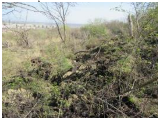
Фото. 26-11-00015. Смещения разной интенсивности на локальных участках оползня
