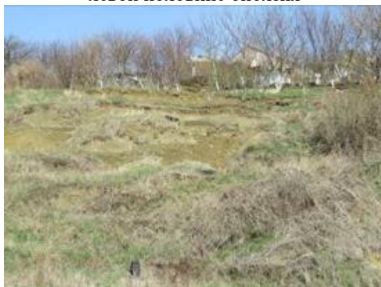
Фото. 26-11-00156. Смещения на локальном участке в правой верхней части оползня.
