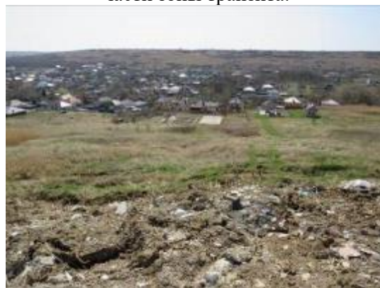
Фото. 26-11-00003. Смещения в головной части у левого борта оползня
