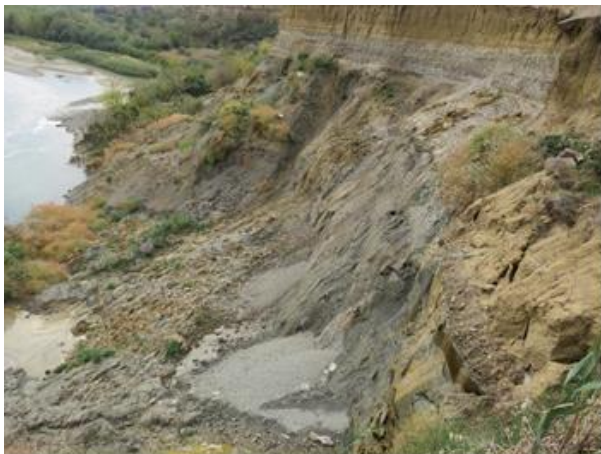
Фото. 26-11-00063. Оп. №1639. Смещения высокой интенсивности в левой части оползня
