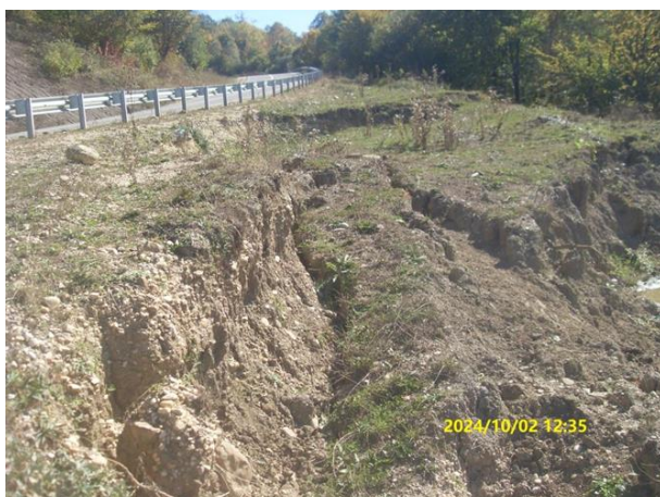
Фото 20-11-00506. Ножай-Юртовский район, автодорога с.Мехкешты - с.Зандак - 1,31км
