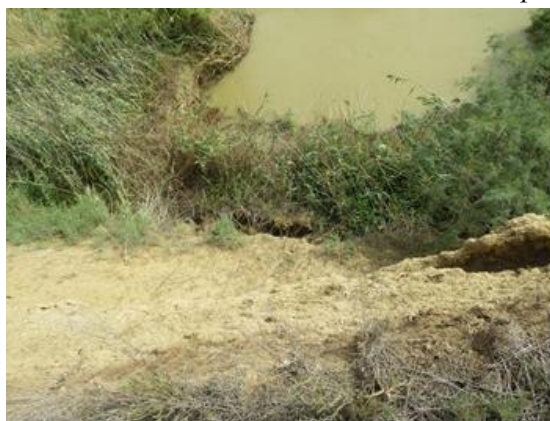
Фото. 26-11-00500. Оп. №3257. Смещения средней интенсивности у основания откоса центральной части оползня.
