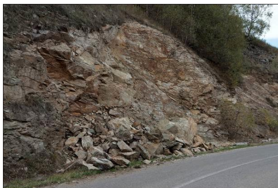
Фото 07-10-00013. Обвальный участок в верхнем откосе дороги Кисловодск - Долина Нарзанов – Джилы-Су в правом борту р. Хасаут, в 1,6 км от т/б «Долина Нарзанов»
