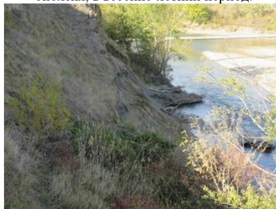
Фото. 26-11-00048. Оп. №2994. Смещения не высокой интенсивности на локальных участках левой части оползня в зоне транзита и языке
