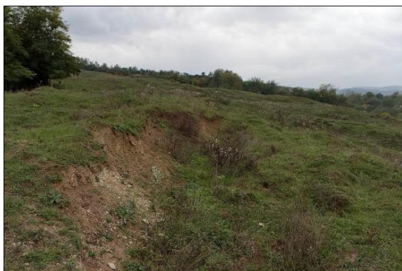
Фото 07-11-00060. Бровка отрыва активного участка на оползне 07.11.00060 в правом борту р. Куркужин
