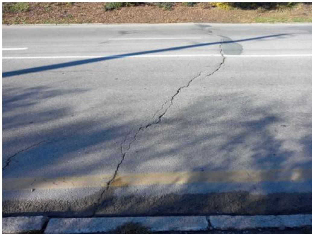
Фото 10. Проявление 91-11-04401. Южнобережное шоссе. Левый борт оползня №69/263. Трещины и деформации на дорожном полотне
