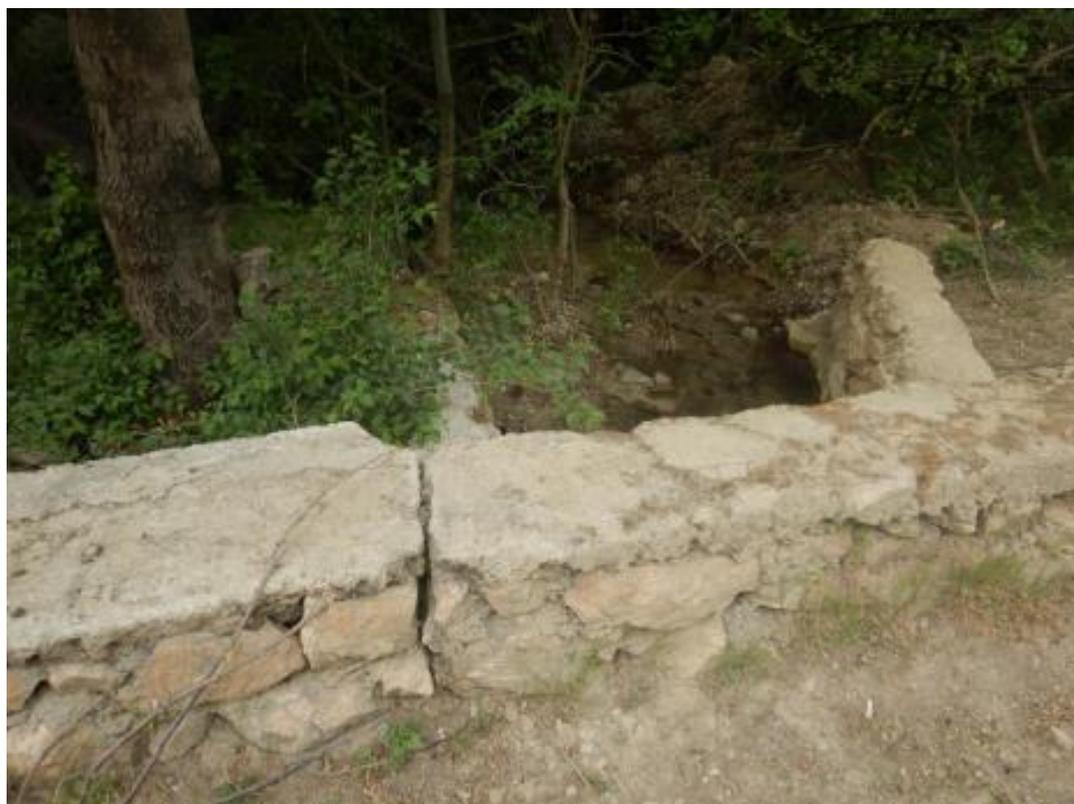
Фото 6. Проявление 91-11-02702. Головной (верховой) склон в районе Севастопольского шоссе, заболачивание в районе водопропуска
