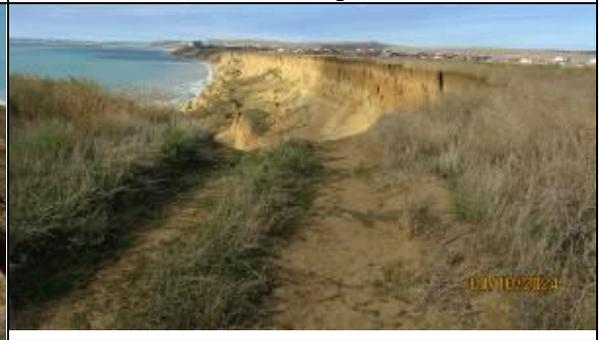
Фото 23-11-00027. Оползневая активизация на уступе побережья Черного моря в 250м к югу от п. Таманского. Разрушена грунтовая автодорога на протяжении 100м.
