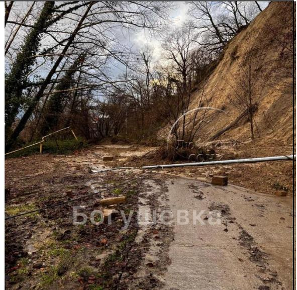
Фото 23-11-00\*\*\*. Оползнем разрушена дорога в с. Богушевка. Фото из открытых источников СМИ
