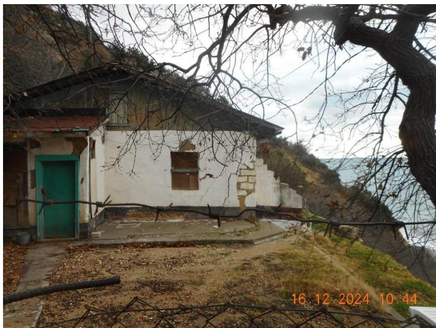
Фото № 92.11.0005-1. Деформации каменного строения на террасе выше подпорной стены (16.12.2024 г.)
