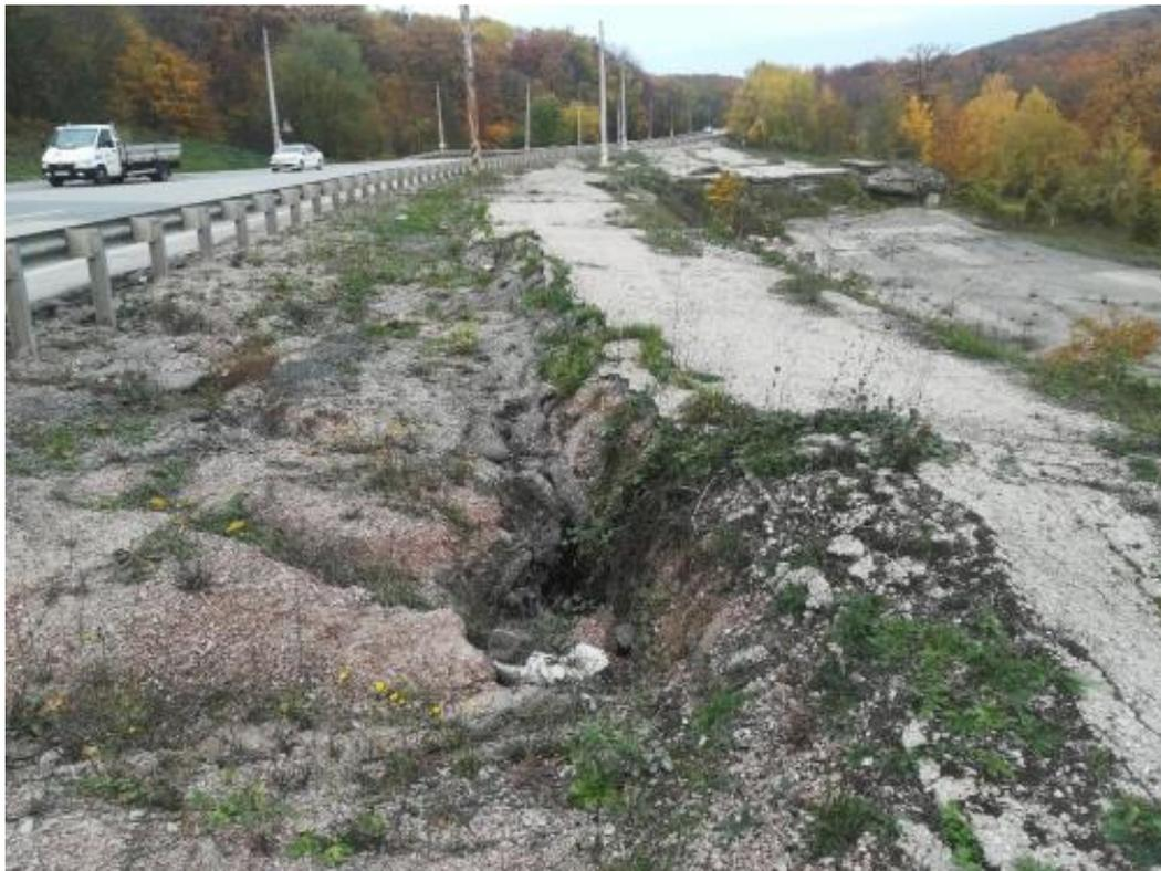
Фото 11. Проявление 91-11-04702. Оползень № 266, средняя часть, локальный очаг. Деформирование (проседание) асфальта из-за суффозии вдоль свайного ростверка на старом неэксплуатируемом участке а/д
