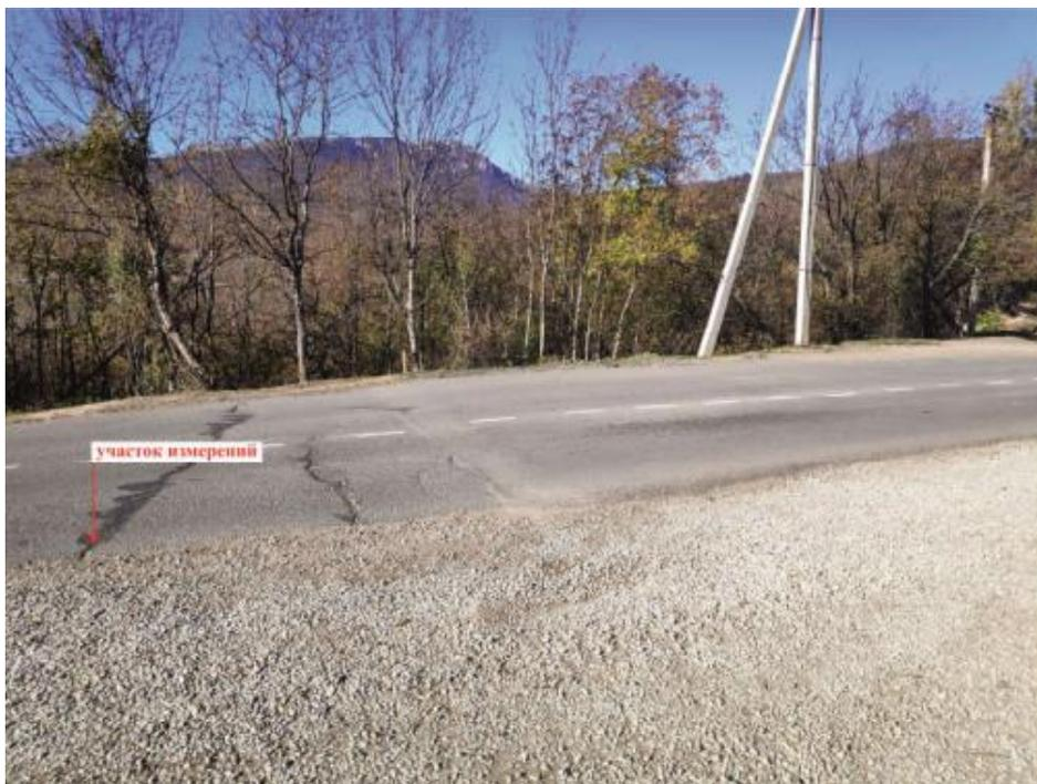
Фото 12. Проявление 91-11-04901. Участок а/д 35 ОП МЗ 35Н-012. Правый борт локального оползневого очага. Участок измерения: трещина шириной 3,7 см, на всю ширину автомобильной дороги, трещина залечена гудроном.
