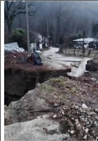
Фото 23-11-00\*\*\*. Дорога в с. Бестужевское разрушена оползнем. Фото из открытых источников СМИ
