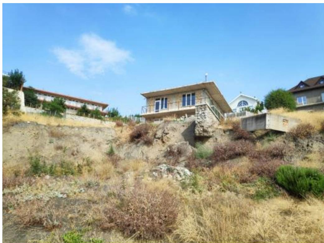
Фото 14. Проявление 91-11-05201. Оползень № 834, средняя часть. Головная часть активной зоны. Зависшее основание подпорной стены.
