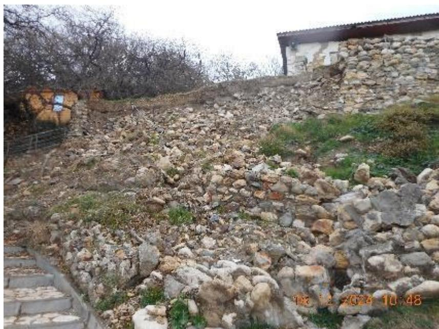
Фото № 92.11.0005-2. Разрушение подпорной стены (16.12.2024 г.)
