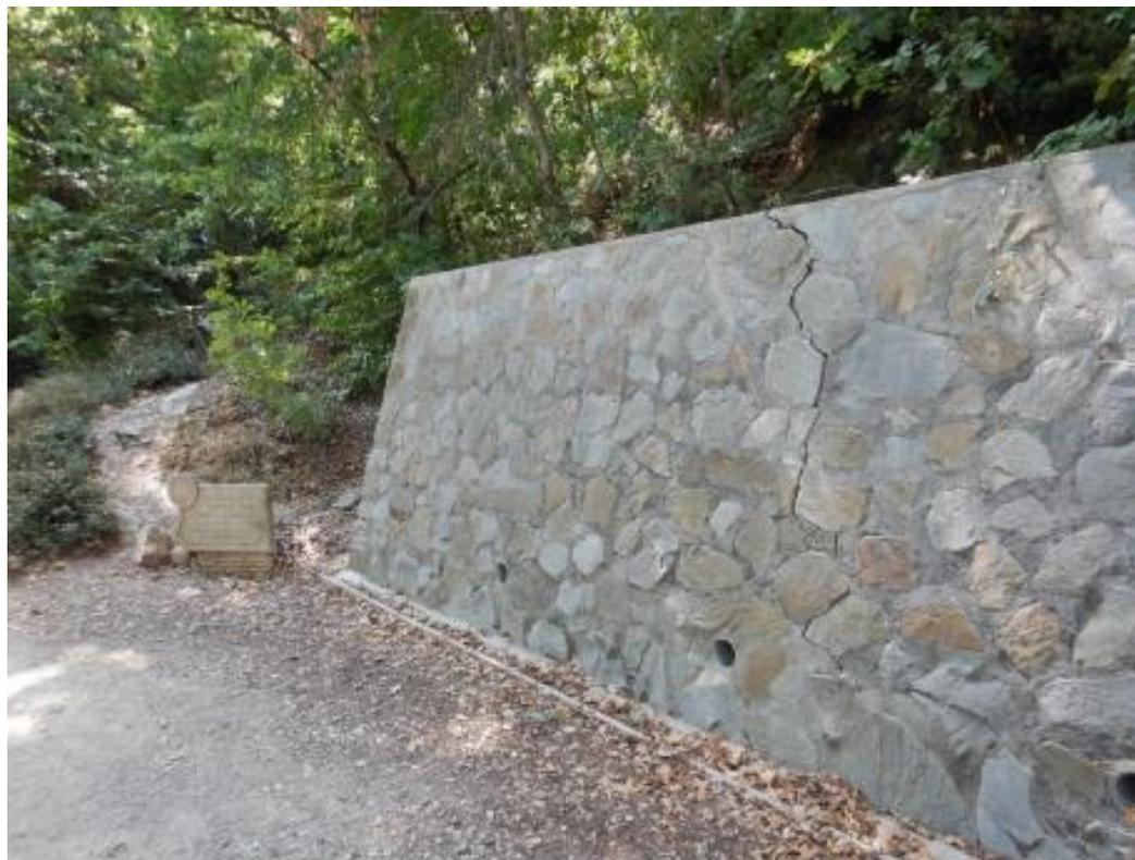
Фото 8. Проявление 91-11-03504. Деформации подпорной стены, приуроченные к правому борту оползня №52. Величина раскрытия 1,5 см
