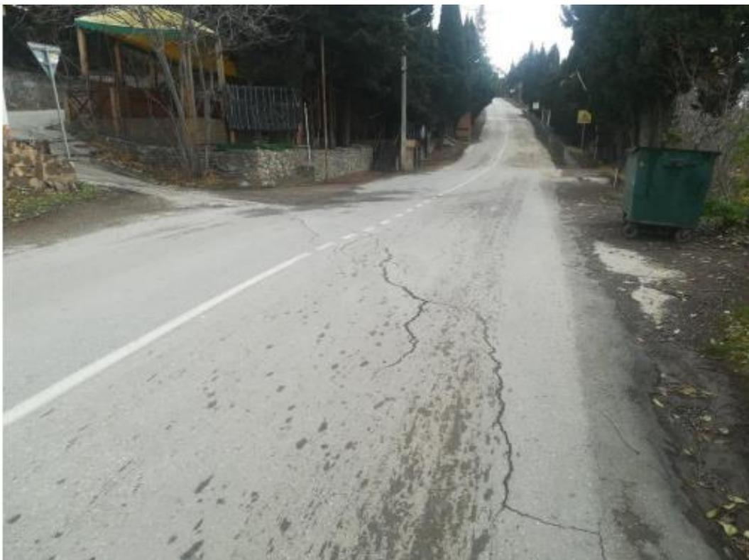
Фото 19. Проявление 91-11-05601. Оползень № 732, нижняя часть, правый борт. Трещины и деформации на а/д 35 ОП РЗ 35К-005.
