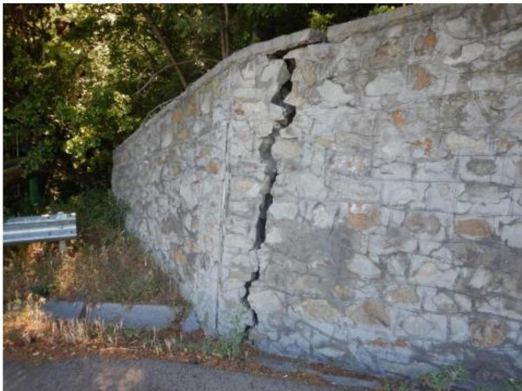
Фото 7. Проявление 91-11-03401. Деформации на верховой подпорной стене Алуштинского шоссе, приуроченные к левому борту оползня. Величина раскрытия южной трещины в верхней части стены 10 см.
