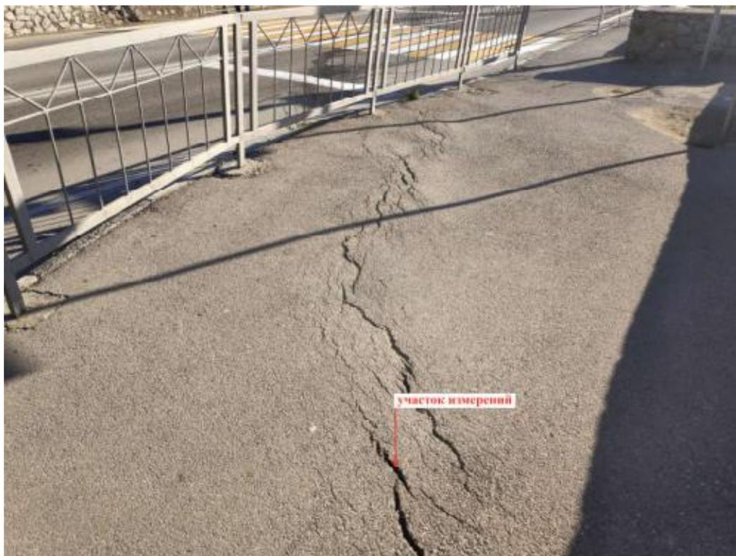
Фото 9. Проявление 91-11-04201. Оползень № 408, головная часть, правый борт. Трещины на асфальте а/д35 ОП РЗ 35А-002. Участок измерений
