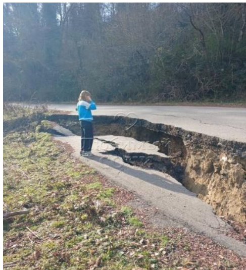
Фото 23-11-00576. Активный оползневой процесс разрушил дорожное полотно. МО город-курорт Сочи, Адлерский район, с. Галицыно.
