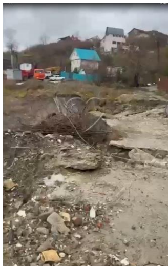
Фото 23-11-00575. Головная часть оползня пересекает местную автодорогу. МО город-курорт Сочи, Лазаревский район, СТ Черноморец.
