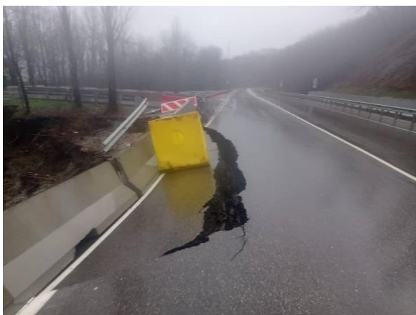
Фото 23-11-00262. Разрушение участка автодороги М4 «Дон» под воздействием оползневой процесса. Фото из открытых источников СМИ
