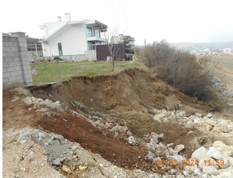
Фото № 92.11.0004-1. Головной срыв оползня в районе придомовой территории по ул. Мускатная д. 37, 39 (05.03.2024 г.)
