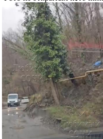
Фото 23-11-00490. Активизация оползневого процесса в верховом откосе дороги. МО город-курорт Сочи, Хостинский район, мкр. Малый Ахун. Фото из открытых источников СМИ
