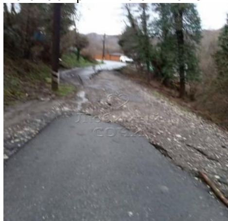
Фото 23-11-00576. Активный оползневой процесс разрушил дорожное полотно. МО город-курорт Сочи, Адлерский район, с. Галицыно.
