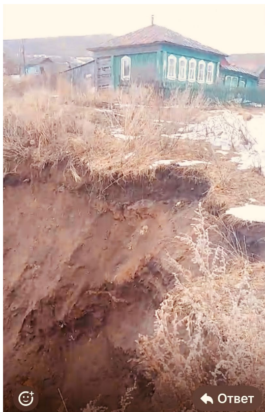
Фото 74-11-00266. Активизация оползневого процесса в г. Катав-Ивановск, по ул. Рабочая, в районе домов № 1 и 2
