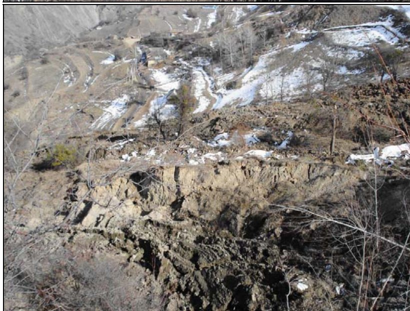
Рис. 6, 7, 8. Активизация оползневого процесса в с.с. Бугарой, Кокадой Чеченской Республики (фото ООО «СтройСервис»).
