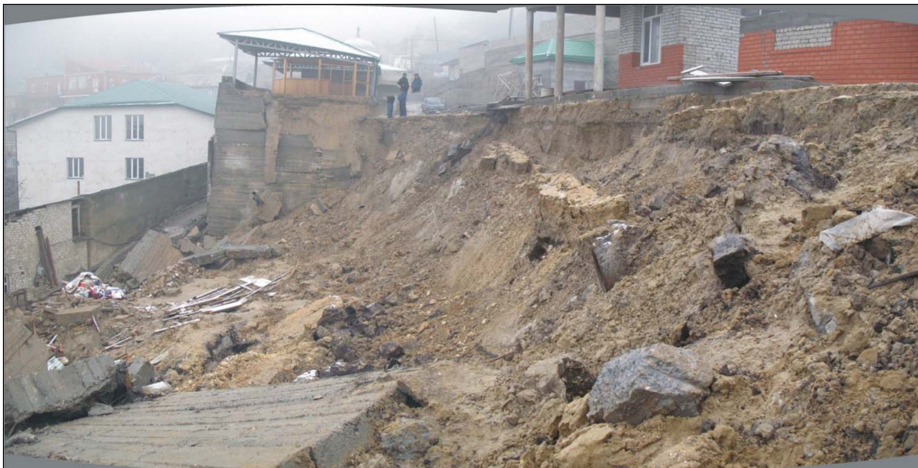
Рис.3. Стенка отрыва оползня-блока в пос. Тарки.
