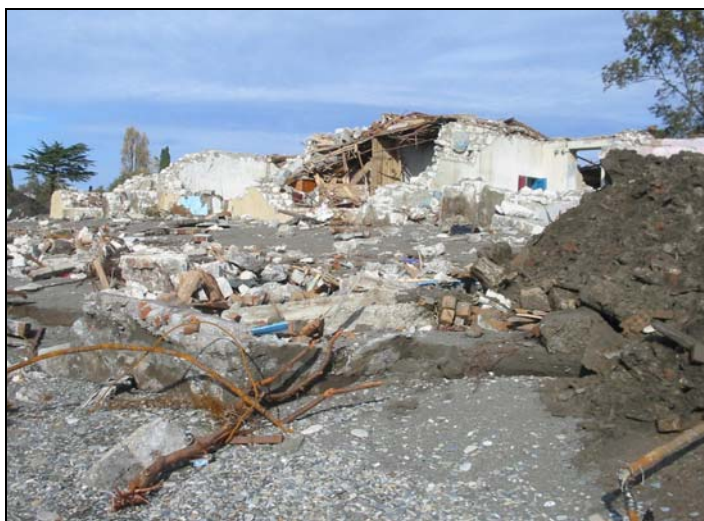
Рис.8. Разрушения жилых домов.
