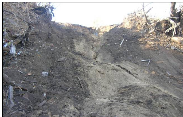
Рис.12. Сход грунтовых масс на бывшую дорогу-спуск в долину р. Оби в районе ул. Депутатская, 22. Алтайский край, г. Барнаул.
