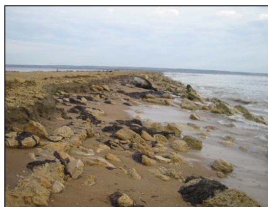
Рис.6. Размыв мелких фракций наброски и глинистого заполнителя дамбы.
