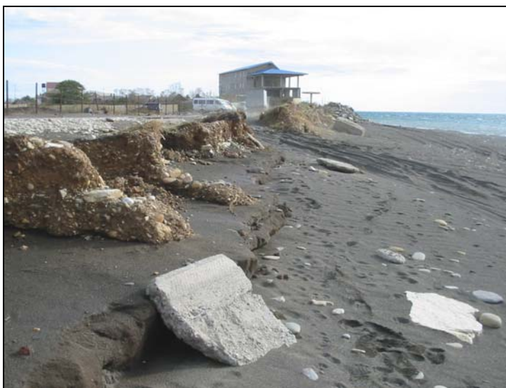
Рис.9. Интенсивный размыв абразионного уступа в тыловой части пляжа, сформированного в техногенных грунтах обваловки.
