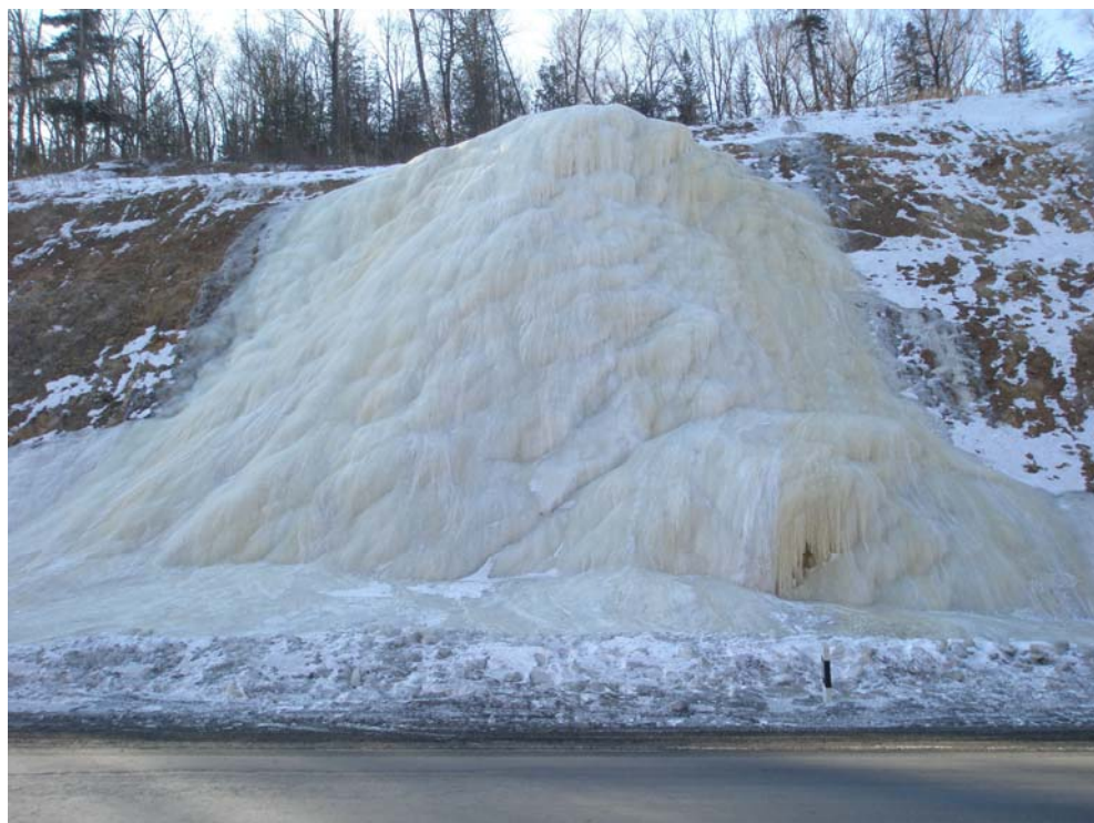
Рис.2. Наледь на федеральной трассе между населенными пунктами Бира и Будукан.
