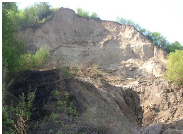
Рис.8. Участок ул. Квартал 953а, 481. Оползень суффозионного генезиса, г. Барнаул, Октябрьский район.
