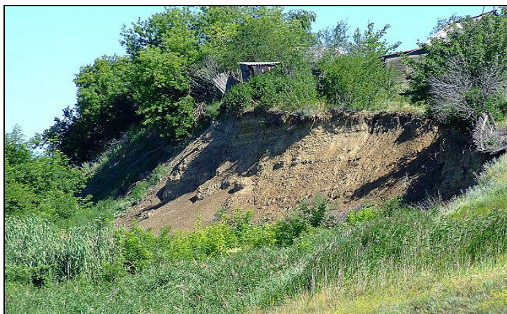
Рис.1. Левый борт оврага по ул. Прибрежная в г. Октябрьск.
