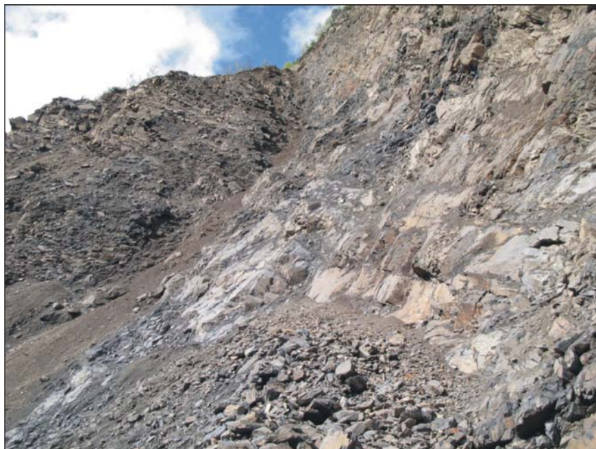
Рис.15. Стенка срыва оползня на участке 16-го км автодороги Тлярата – Камилух в районе с. Цумилух.
