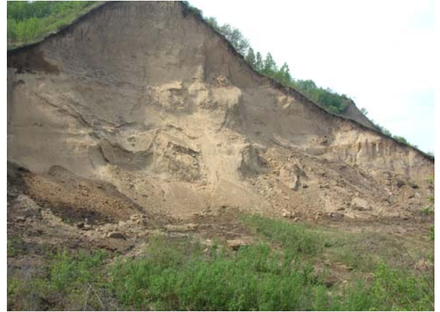
Рис.10 Оползень на участке ул. Квартал 953а, 21-34, г. Барнаул, Ленинский район.
