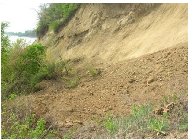
Рис.3. Участок с/т «Энергетик», центральная часть. Эрозионный оползень. г. Барнаул, Центральный район.
