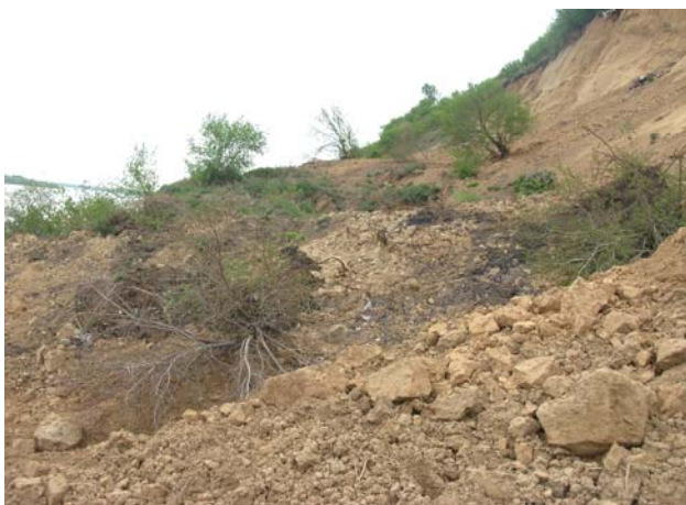
Рис.5. Оползень на участке ул. Тачалова, 69, 67, 57 (снесенные), пер. Сычева. Нагорная часть г. Барнаула, Центральный район.
