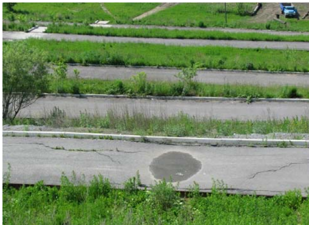
Рис.13. Просадочное „блюдце” на берме № 2 (оползневой цирк №11). Лагерный сад, г. Томск.
