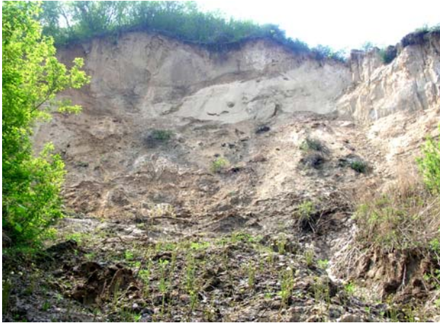
Рис.9. Оползень на участке оползня Моторного завода, г. Барнаул, Ленинский район.
