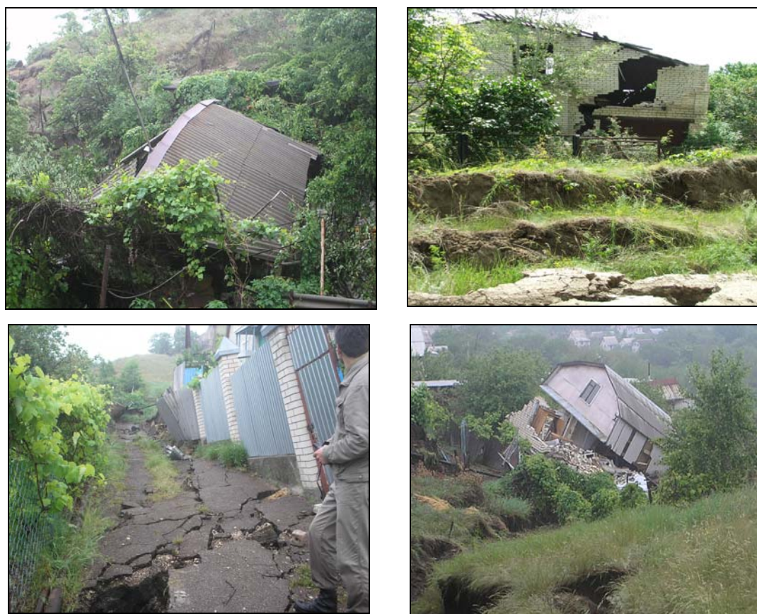
Рис.17. Оползень на участке Широкий Буерак– Формосово Саратовского района Саратовской области, май 2008 г.
