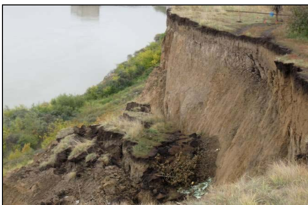
Рис.12. Участок с/т «Обь 2». Эрозионный оползень. Ленинский район, г. Барнаул, Алтайский край.
