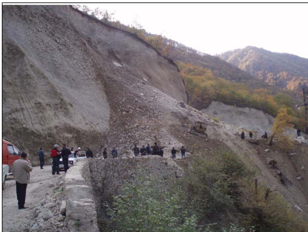
Рис.3. Автодорога в с. Шатой. Обвал, сформировавшийся на подрезанном дорогой склоне (ООО «Стройсервис»).
