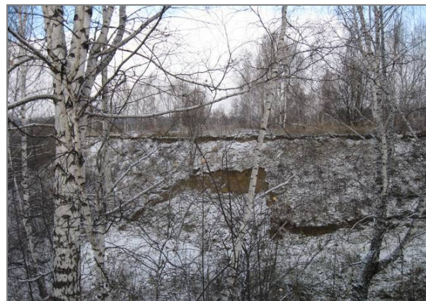
Рис.2. Оползневой блок в борту оврага, мкр. «Каштак» г. Томск, Томская область (ОАО «Томскгеомониторинг»).
