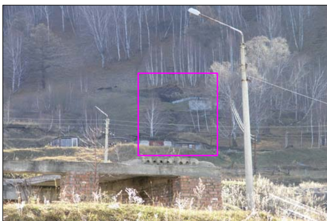
Рис.8. Вид на оползень со стороны селитебной зоны с. Толгоек, Республика Алтай (ОАО "Алтай-Гео").
