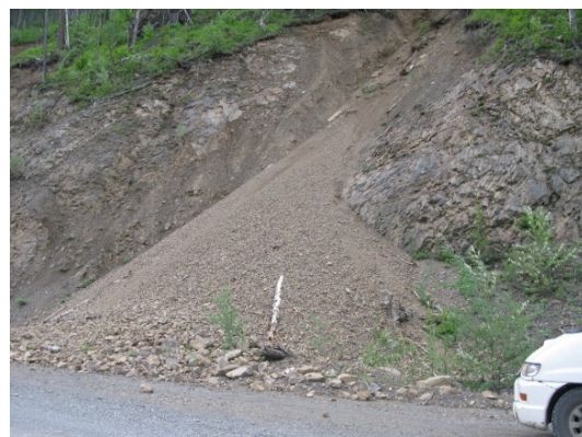
Рис.5. Осыпные процессы вдоль дороги Лидога – Ванино (Комсомольское отделение ДВ РЦ ГМСН).
