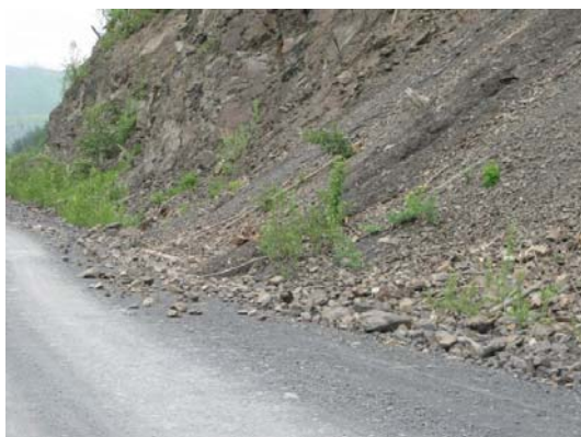
Рис.5. Осыпные процессы вдоль дороги Лидога – Ванино (Комсомольское отделение ДВ РЦ ГМСН).
