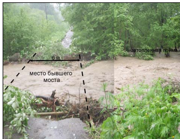
Рис.21. Разрушенный паводком мостовой переход, на р. Владимировка (23 июня 2009 г.) (ФГУГП «СахГРЭ»).
