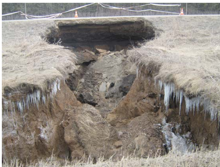
Рис.12. Провал на участке автодороги г. Богданович – г. Сухой Лог (ОАО «Уральская гидрогеологическая экспедиция»).
