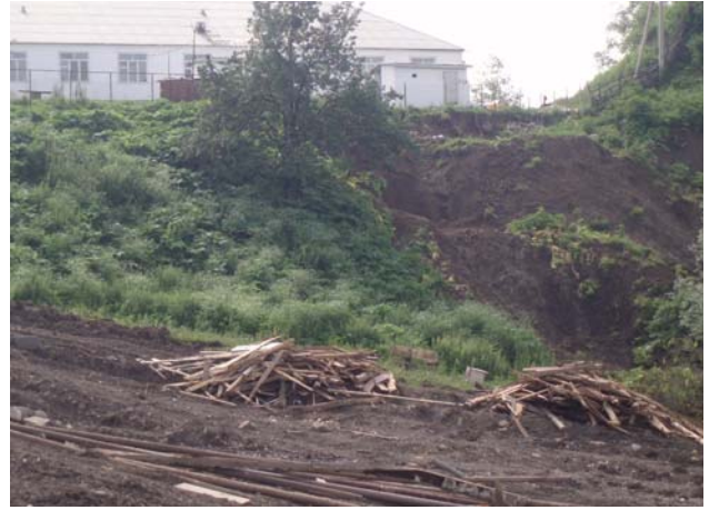
Рис.10. Оползневые смещения в районе школы с. Гуржи-Мохк (ООО «Стройсервис»).
