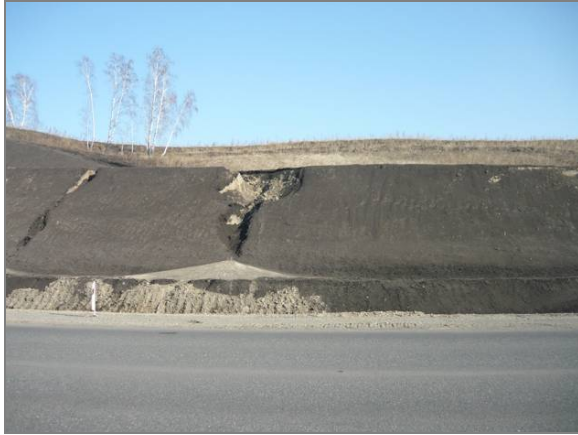
Рис.1. Овражная эрозия на прилегающих склонах трассы М-53, Красноярский край (ФГУП «Красноярскгидрогеология»).
