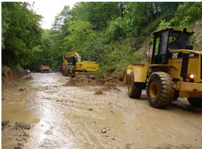
Рис.11. Автодорога Новороссийск – Сочи. Дорожная техника расчищает оползневые грунты (ГУП «Кубаньгеология»).
