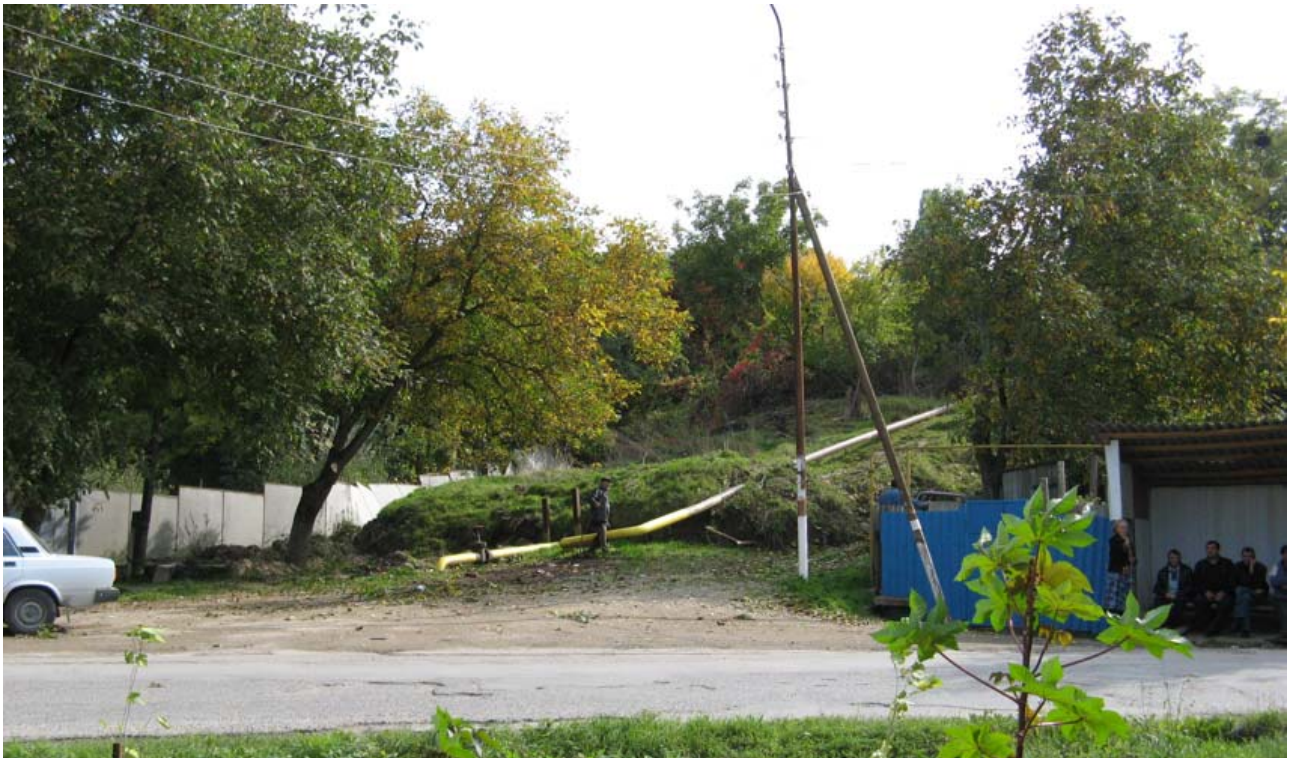
Рис 14. Языковая часть оползня в пос. Свобода; 08.10.2009, (КТЦ ГМГС ФГУП «Кавказгидрогеология»).
