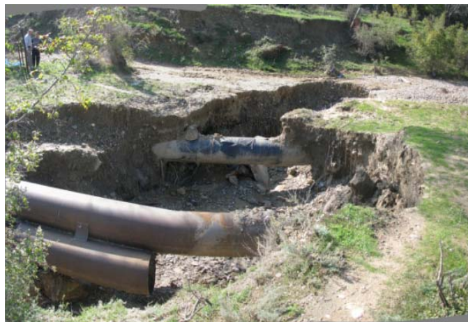
Рис. 3. Развитие эрозии на 148,3 км нефтепровода «Баку - Грозный» (ГУП «РЦ Дагестангеомониторинг»).
