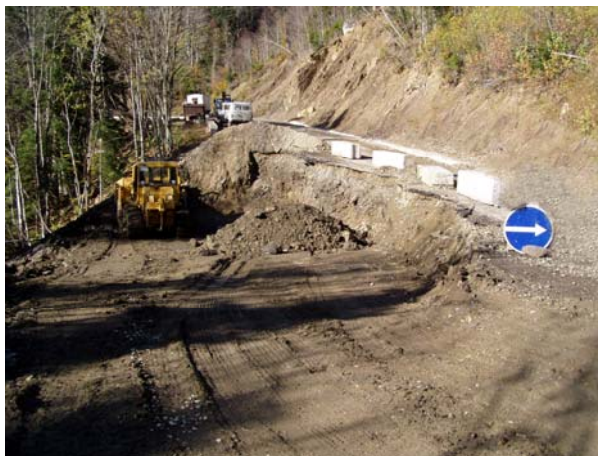
Рис. 8. Ремонт разрушенного полотна автодороги в результате схода оползня (КГЦ ГУП “Кубаньгеология”).
