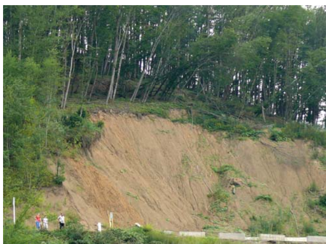
Рис. 10. Оползень на автомобильной дороге Горячий Ключ – Фанагорийское; 18.07.2009 (ГУП «Кубаньгеология»)
