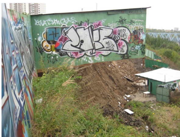
Рис. 7. Оползневой процесс на участке «Москворечье» (ОАО «ГЕОЦЕНТР-МОСКВА»).
