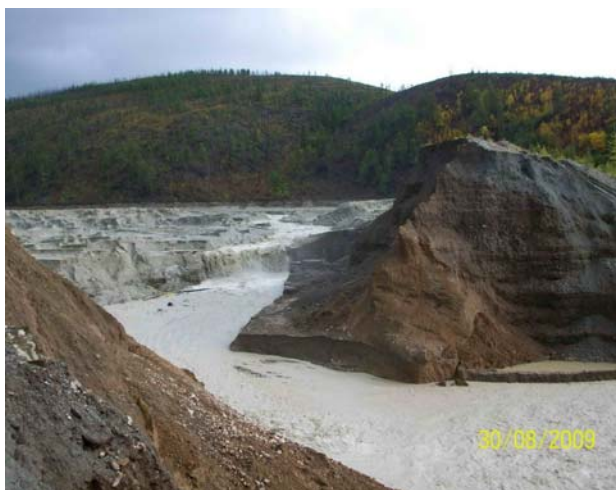
Рис. 18. Частичное разрушение дамбы хвостохранилища в окрестностях п. Карамкен хасынского района Магаданской области; 30.08.2009 (ГУП “Дальневосточный Региональный Центр государственного мониторинга состояния недр”)
