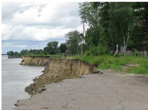
Рис. 4. Разрушение дорожного полотна по ул. Дзержинского, г. Колпашево Томской области (ОАО «Томскгеомониторинг»)
