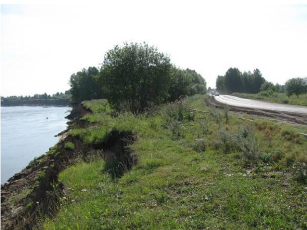
Рис. 10. Бровка берегового уступа на участке автодороги Зырянское – Причулымск, Томская область (ОАО «Томскгеомониторинг»)
