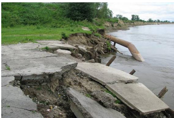
Рис. 5. Деформации сооружений в зоне берегового уступа в районе пристани, г. Колпашево Томской области (ОАО «Томскгеомониторинг»)
