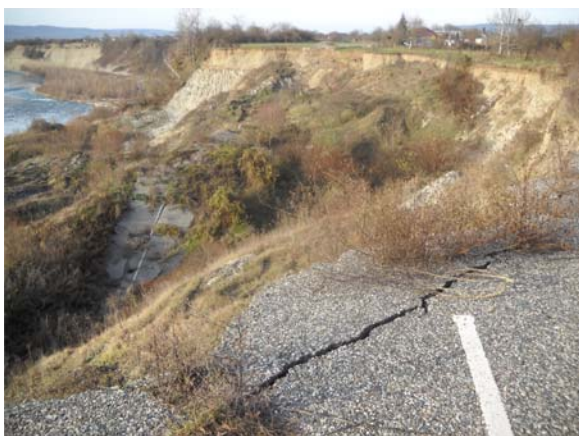
Рис.1. Оползень на южной окраине ст. Абадзехской (ГУП «Кубаньгеология»)
