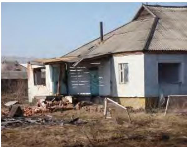
Рис. 6. Разрушение домов в результате подтопления. Кемеровская область, с. Борисово, Причинами подтопления являются природные (близкое залегание грунтовых вод) и техногенные (ухудшение дренированности территорий в результате про-
