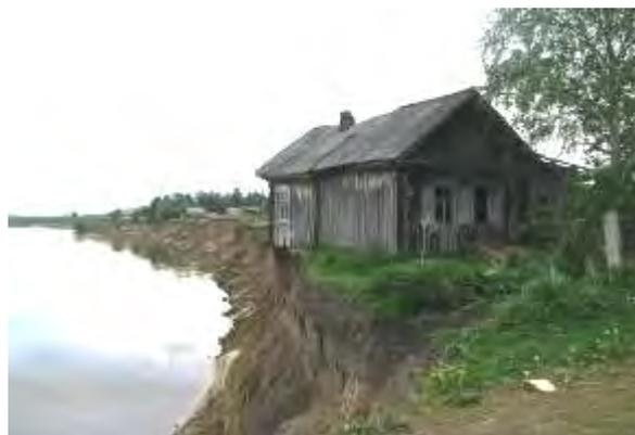
Рис. 5. Разрушение берегового склона по ул. Коммунальная. Томская область, с. Зырянское
