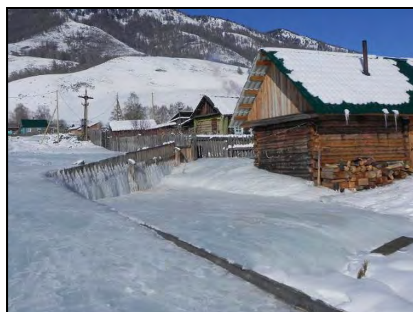
Рис.8. Наледь в с. Баштала по ул. Родниковой, Республика Алтай (ТЦ «Алтайгеомониторинг»)
