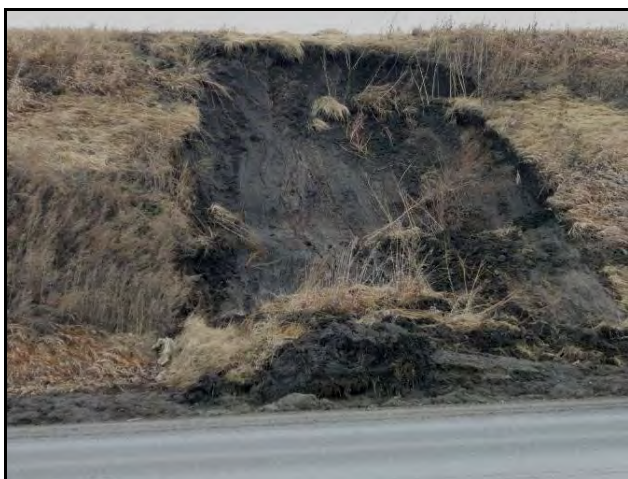
Рис.1. Оползни-сплывы на придорожном склоне Северного шоссе, г. Красноярск (ОАО «Красноярскгидрогеология»)
