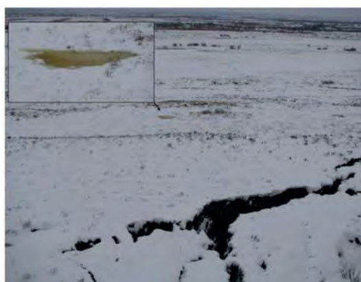
Рис.4. Мочажины на теле оползня (ГУП РЦ «Дагестангеомониторинг»)
