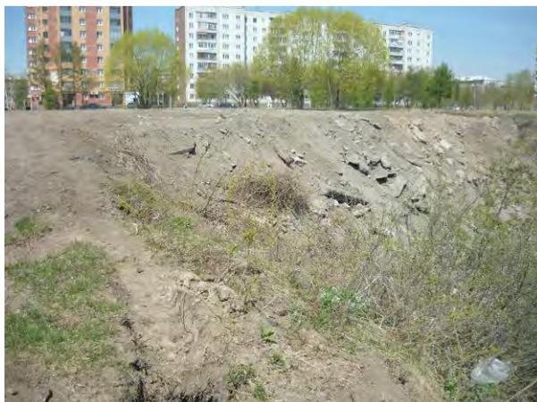
Рис.12. Спланированный, засыпанный участок интенсивно обрушивающегося берега,
