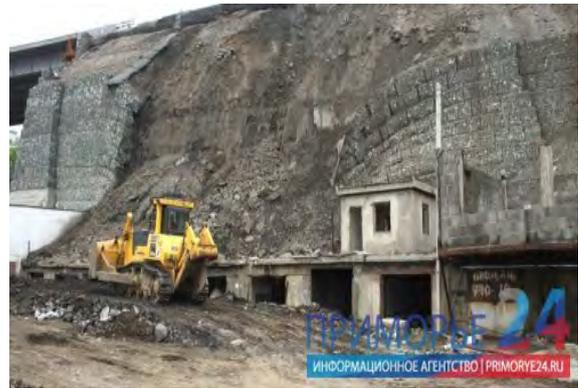
Рис.32. Обрушение 20-метровой подпорной стены на участке автодороги Седанка – Патрокл, Приморский край (Приморский ТЦ ГМСН)
