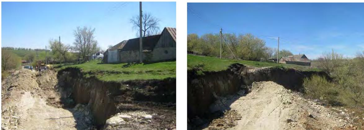
Рис.18. Карстово-суффозионный провал, осложненный оползневым процессом, на грунтовой дороге в с. Злобино (ТЦ ГМСН «Липецкгеомониторинг»)
