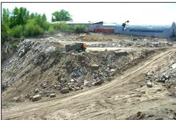
Рис.4. Участок оврага ОМФ, засыпка оползневой цирка строительным мусором, ул. Фабричная, 29, Октябрьский район, г. Барнаул (ОАО «Алтайская гидрогеологическая экспедиция»)
