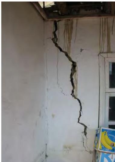
Рис.23. Деформации домостроений в результате активизации оползневого процесса в с. Аракани (контур 5) (ГУП РЦ «Дагестангеомониторинг»)
