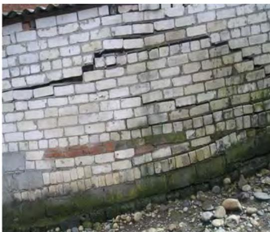
Рис.26. Деформации стен здания в а. Эркин-Юрт (ОАО «Гидрогеоэкология»)
