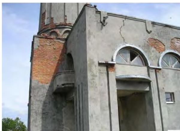
Рис.27. Деформации стен мечети в а. Эркин-Юрт (ОАО «Гидрогеоэкология»)
