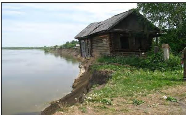
Рис.8. Разрушение берегового склона по ул. Коммунальной, с. Зырянское, Томская область (ОАО «Томскгеомониторинг»)
