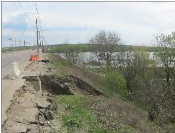
Рис.17. Оползание грунтов откоса у Октябрьского моста через р. Воронеж (ГЦ ГМСН «Липецкгеомониторинг»)
