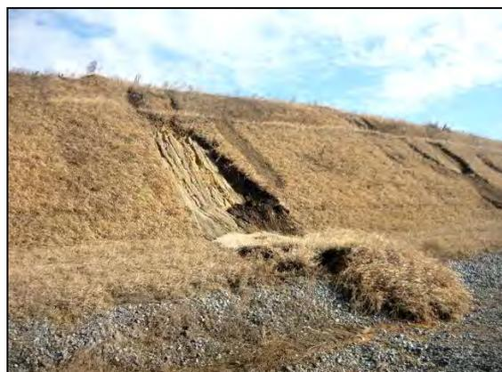
Рис.15. Проявления струйчатой эрозии (а) и оползневых процессов (б) на объездном участке трассы М-53, Красноярский край (Красноярский ТЦ ГМСН)
