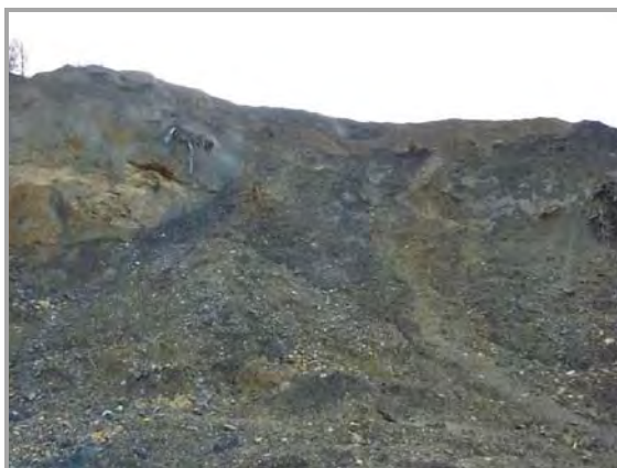
Рис.11. Очаги оплывания глинистых грунтов вниз на полку грунтовой дороги в средней части откоса (ГУП «Кубаньгеология»)
