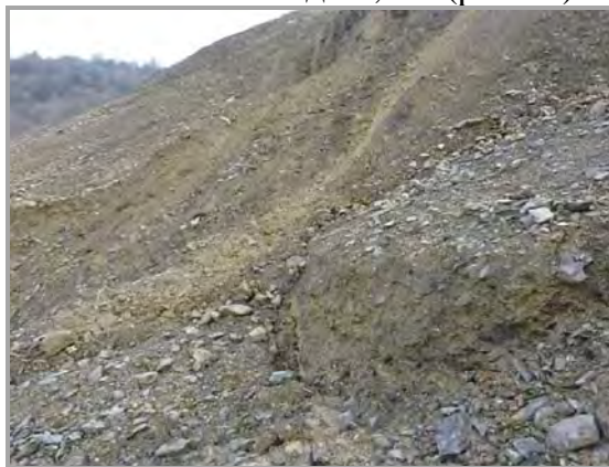
Рис.9. Свежий сформировавшийся левобортовой оползневой уступ в поверхности полки грунтовой дороги, проходящей в средней части техногенного откоса (ГУП «Кубаньгеология»)
