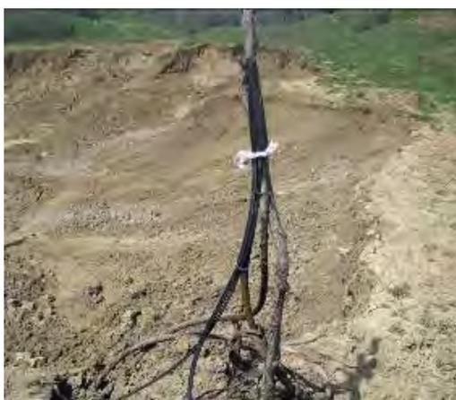
Рис.1. Поврежденная оползнем линия связи в пос. Агачаул, Республика Дагестан (Фото РЦ «Дагестангеомониторинг»)
