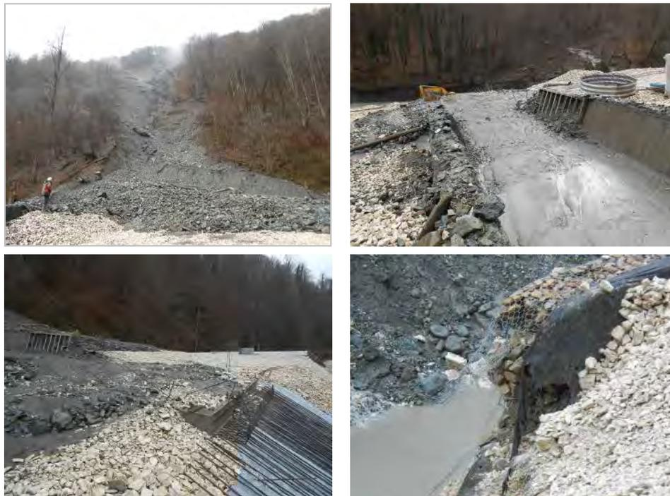
Рис.12. Фрагменты разрушенной в результате схода селевого потока противозерозионной стены, пос. Эсто-Садок, Краснодарский край (Южный региональный центр ГМСН)
