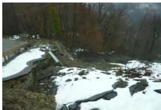
Рис.9. Часть автодороги с.Шамяновка – с.Васильевка, разрушенная оползнем (ГУП «Кубаньгеология»)
