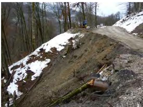
Рис.6. Участок дорожного полотна, разрушенного в результате оплывания грунтов, пос. Красная Поляна, Краснодарский край (Южный региональный центр ГМСН)
