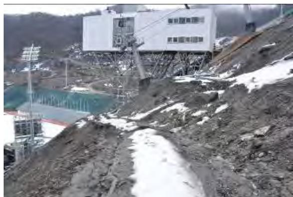
Рис.5. Переувлажненные породы на участках склона, пос. Красная Поляна, Краснодарский край (ФГУГП «Гидроспецгеология»)
