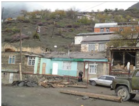
Рис.13. Деформации и разрушения в результате активизации оползневого процесса в с. Эчеда, Цумадинский район, Республика Дагестан (ГУП РЦ «Дагестангеомониторинг»)
