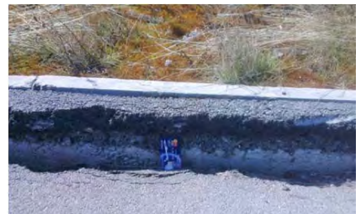
Рис.7. Трещина разрыва и суффозионный провал на двухуровневой дорожной развязке, г. Ханты-Мансийск, Ханты-Мансийский автономный округ (ТЦ ГМСН по Ханты-Мансийскому автономному округу)
