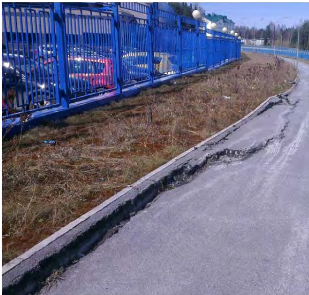
Рис.7. Трещина разрыва и суффозионный провал на двухуровневой дорожной развязке, г. Ханты-Мансийск, Ханты-Мансийский автономный округ (ТЦ ГМСН по Ханты-Мансийскому автономному округу)
