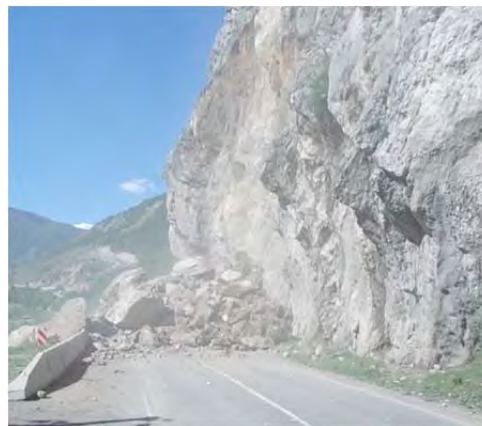
Рис.12. Второй обвал на обвалоопасном участке у южного портала Бизского тоннеля, Республика Северная Осетия – Алания (ОАО «Севосетингеоэкомониторинг»)
