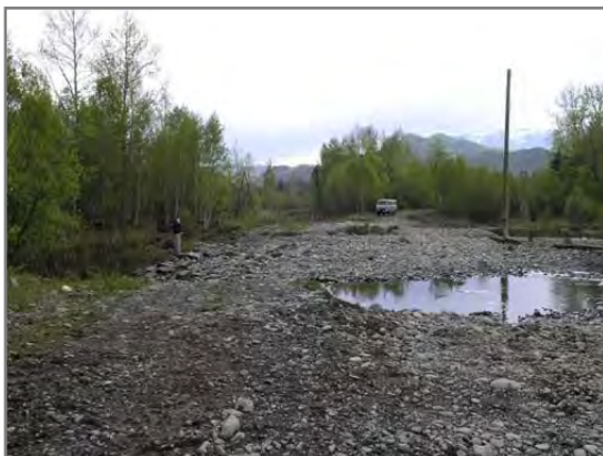
Рис.23. Проран в дороге на с. Саксобай, Республика Алтай (ТЦ «Алтайгеомониторинг»)
