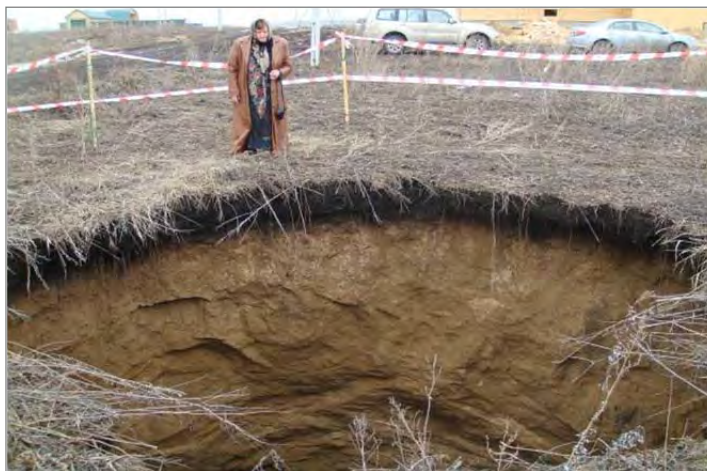
Рис.26. Суффозионная воронка на поверхности третьей террасы р. Томь в зоне жилой застройки в с. Березово, Кемеровская область (ТЦ ГМСН по Кемеровской области)
