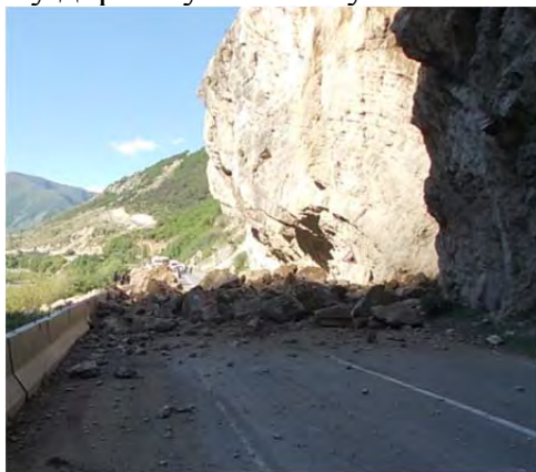
Рис.11. Первый обвал на обвалоопасном участке у южного портала Бизского тоннеля, Республика Северная Осетия – Алания (ОАО «Севосетингеоэкомониторинг»)
