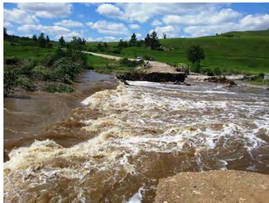
Рис.18. Разрушение автодороги Тунгокочен – Верх-Усугли, Забайкальский край (фото ГУ МЧС по Забайкальскому краю)
