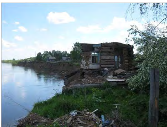
Рис.15. Разрушение дома в с. Зырянское, Томская область (ОАО «Томскгеомониторинг»)
