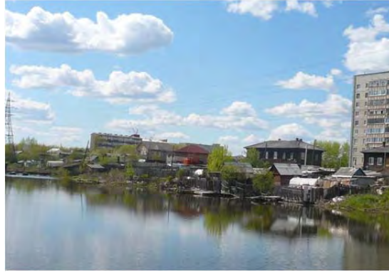
Рис.6. Подтопление хозяйственных построек, огородов рекой Бабарынка, г. Тюмень, Тюменская область (ТЦ ГМСН по Тюменской области)
