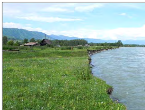
Рис.20. Разрушение берега (12 м) в центре эрозионной дуги на уч. Березовка, Республика Алтай (ТЦ «Алтайгеомониторинг»)
