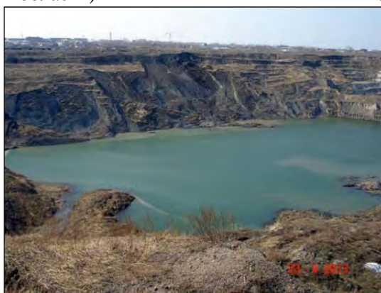
Рис.10. Оползни по бортам Центрального карьера в г. Копейске, Челябинская область (ТЦ ГМСН по Челябинской области)
