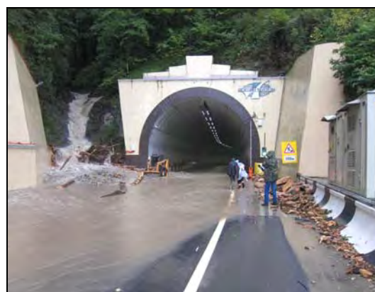
Рис. 12. Наносоводный поток, перекрывший полосу автодороги Адлер – Красная Поляна на участке «устье р. Кепша – устье р. Чвижепсе» (ЮРЦ ГМСН)
