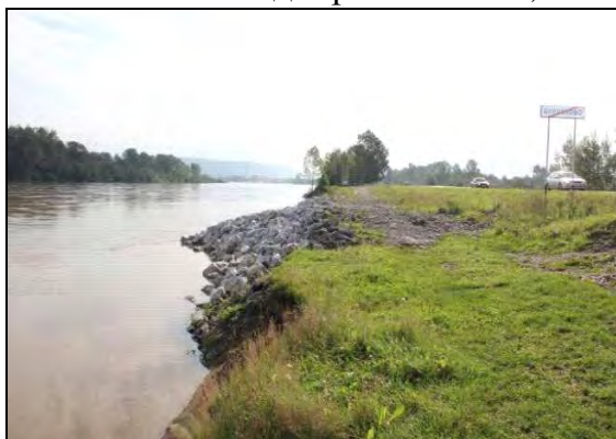
Рис.7. Укрепление берега вблизи автодороги Новокузнецк – Междуреченск, Кемеровская область (ТЦ ГМСН по Кемеровской области)
