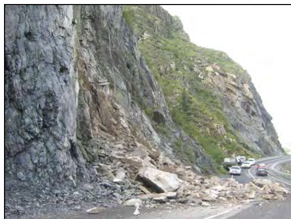
Рис.19. Обвал на 686 км трассы М-52 «Чуйский тракт», Республика Алтай (МЧС по Республике Алтай)
