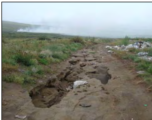
Рис.9. Активизация овражной эрозии на грунтовой дороге в районе Кызылского полигона ТБО, Республика Тыва (Тувинский ТЦ ГМСН)
