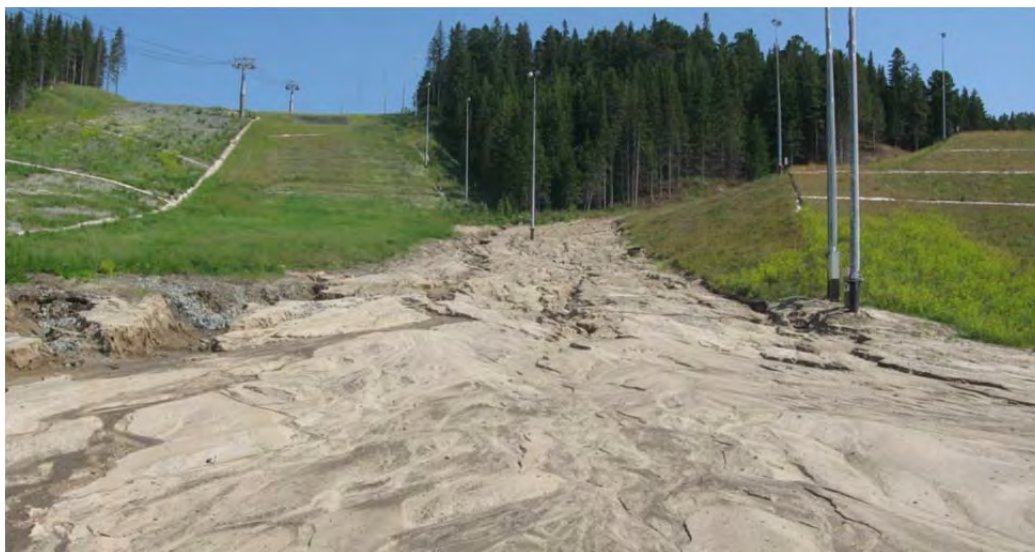
Рис.16. Селевой поток между двумя спусками на территории горнолыжного курорта «Хвойный Урман» ул. Ледовая, 12 (ТЦ ГМСН по Ханты-Мансийскому автономному округу)
