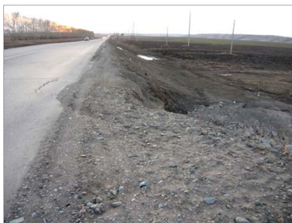
Рис.14. Деформированный в результате размыва основания участок полотна дороги Красноярск – Элита, Красноярский край (ТЦ ГМСН по Красноярскому краю)
