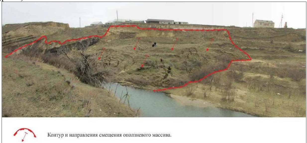
Рис.1. Фотопанорама оползневого участка на восточной окраине с. Карабудахкент (ГУП РЦ «Дагестангеомониторинг»)
