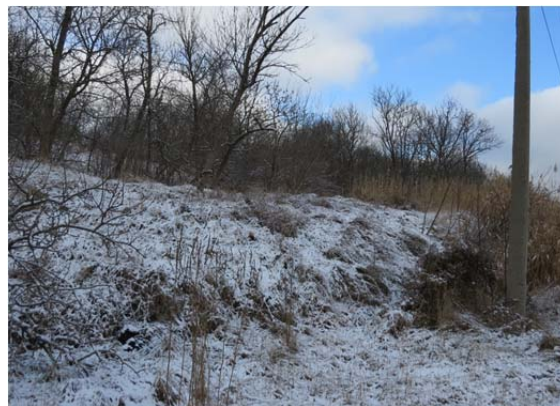
Рис.2. Языковая часть оползня приблизилась к ЛЭП (ТЦ ГМСН по Ставропольскому краю)
