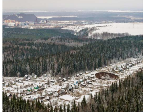
Рис.16. Провал над II-й северо-восточной панелью СКРУ-2. На заднем плане – южная часть г. Соликамск; слева – производственная площадка рудника СКРУ-2 (ТЦ ГМСН по Пермскому краю)
