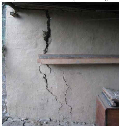
Рис.13. Деформированные домовладения с. Орта-Стал в результате активизации процессов подтопления (ГУП РЦ «Дагестангеомониторинг»)
