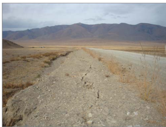
Рис.6. Процессы овражной эрозии на Эйлиг-Хемском участке: а – трещины отседания у полотна дороги, б – отсыпанный овраг у дороги, Республика Тыва (Тувинский ТЦ ГМСН)
