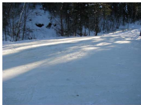
Рис.4. Наледь на биатлонной трассе Центра лыжного спорта в г. Ханты-Мансийске (ТЦ ГМСН по Ханты-Мансийскому автономному округу)
