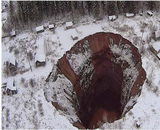
Рис.15. Провал над II-й северо-восточной панелью СКРУ-2. Вид сверху (ТЦ ГМСН по Пермскому краю)
