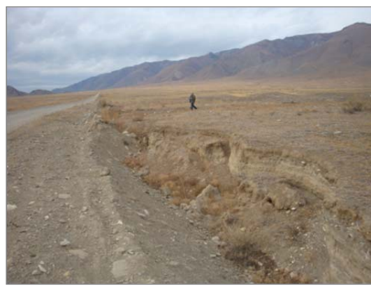
Рис.6. Процессы овражной эрозии на Эйлиг-Хемском участке: а – трещины отседания у полотна дороги, б – отсыпанный овраг у дороги, Республика Тыва (Тувинский ТЦ ГМСН)
