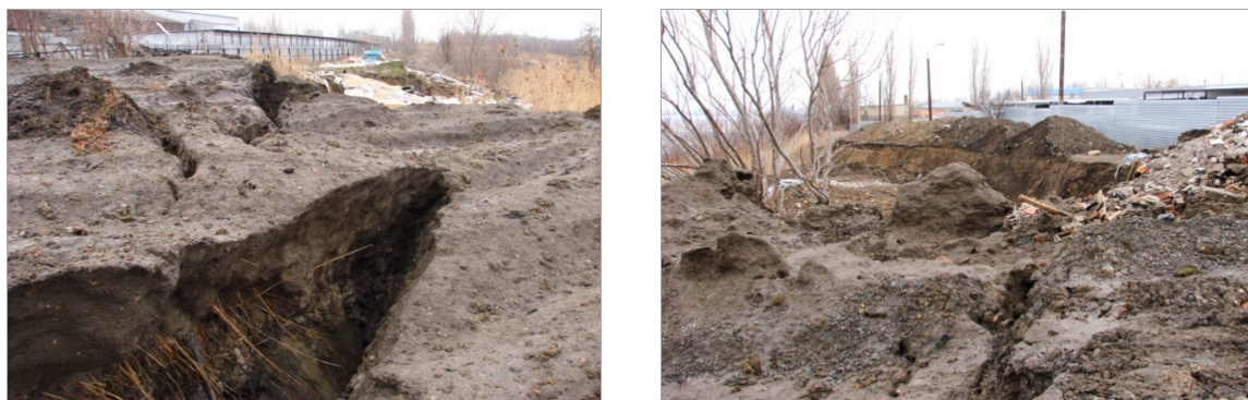
Рис. 6. Оползневые смещения в головной части оползневого массива № 129 в Октябрьском районе г. Ставрополя, пригруженного насыпными грунтами в результате складирования снега (ТЦ ГМСН по Ставропольскому краю)
