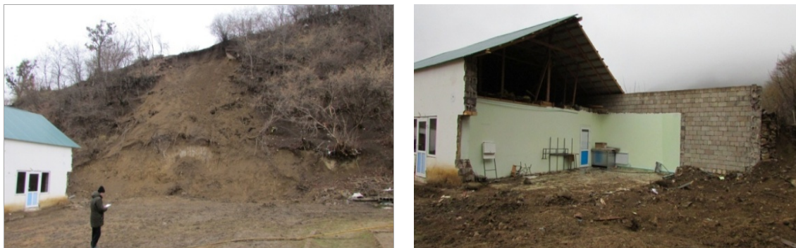
Рис. 5. Общий вид оползневого участка и фрагмент разрушенной части здания школьной столовой в с. Хучни Табасаранского района Республики Дагестан (ГУП РЦ «Дагестангеомониторинг»)
