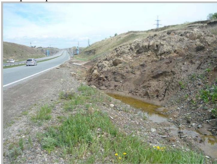
Рис. 15. Смещенные оползневые массы на обочину и полотно трассы М-54 (ТЦ ГМСН по Республике Хакасия)
