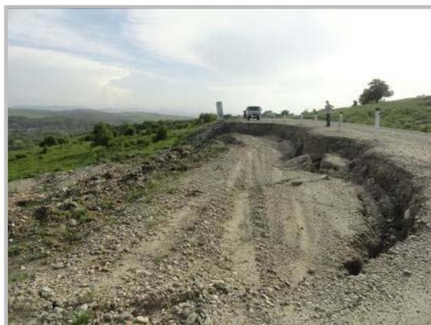
Рис. 5. Участок активизации оползневой процесса в приводораздельной части на отрезке автодороги Мостовской – Отрадная (ТЦ ГМСН по Краснодарскому краю)
