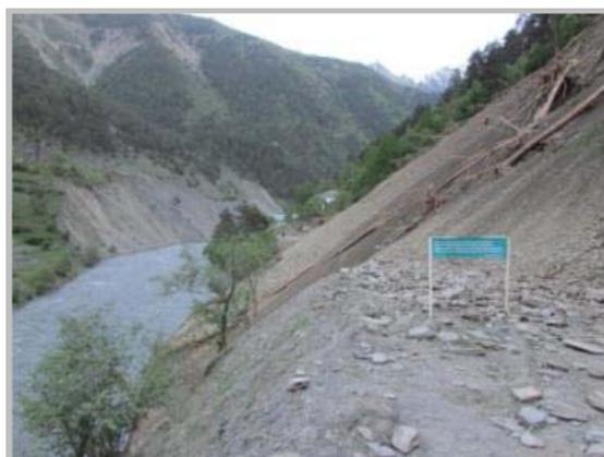
Рис. 21. Разрушенный в результате активизации оползневого процесса участок автодороги Анцух – Тлярата (ТЦ ГМСН по Республике Дагестан)
