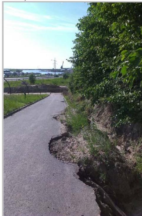
Рис. 14. Разрушенный участок дороги на территории «Архиопарка» (ТЦ ГМСН по Ханты-Мансийскому автономному округу)
