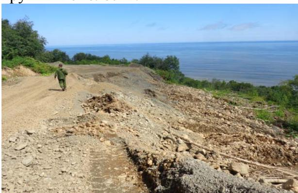
Рис.8. Головная часть оползня и восстановленный фрагмент автодороги на участке Угледарский (Сахалинский ТЦ ГМСН)
