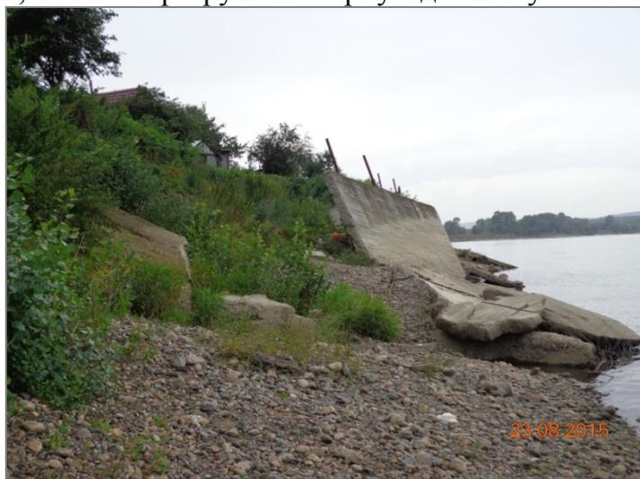
Рис.5. Разрушенная подпорная стенка в пределах с. Боровково, Кемеровская область (ТЦ ГМСН по Кемеровской области)
