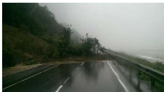
Рис.48. Оползневые отложения на автодороге Южно-Сахалинск – Оха, Макаровский район (ТЦ ГМСН по Сахалинской области)
