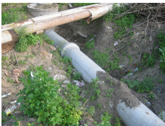
Рис.2. Участок развития овражной эрозии, угрожающей трубопроводу, Владимирская область (ТЦ ГМСН по Владимирской области)
