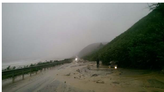
Рис.47. Отложения, перекрывшие автодорогу Южно-Сахалинск – Оха, Макаровский район (ТЦ ГМСН по Сахалинской области)
