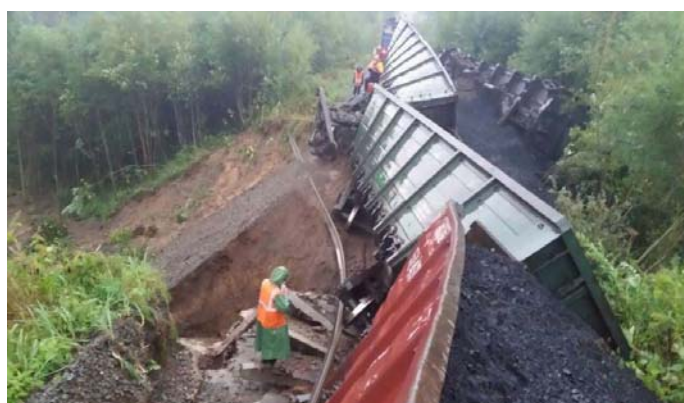
Рис.49. Сход железнодорожных вагонов в результате разрушения участка железной дороги Поронайск – Вахрушев (306 км, 10 пикет) (ТЦ ГМСН по Сахалинской области)
