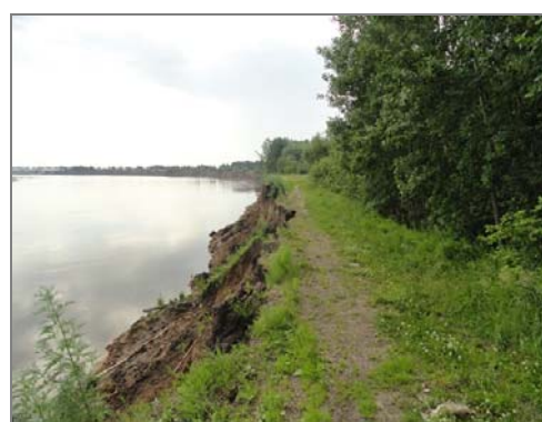
Рис.34. Участок разрушенной автодороги Зырянское – Причулымск, Томская область (ТЦ ГМСН по Томской области)
