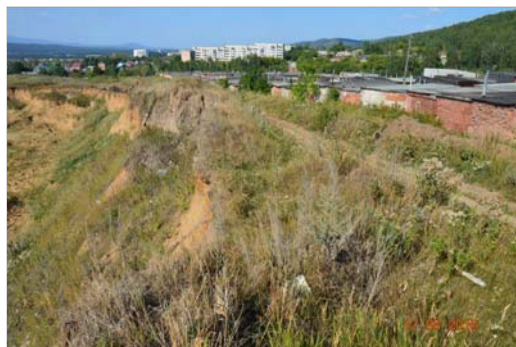
Рис.16. Участок активизации комплекса гравитационных ЭГП на восточном борту карьера Миасского кирпичного завода в районе гаражного массива, г. Миасс (ТЦ ГМСН по Челябинской области)
