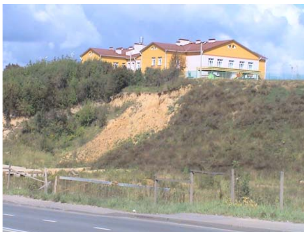
Рис.7. Участок активизации оползневого процесса, г. Смоленск, Смоленская область (ТЦ ГМСН по Смоленской области)
