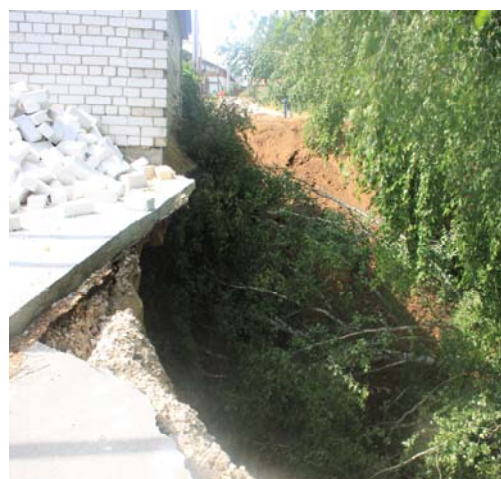
Рис.46. Деформированные в результате воздействия оползневого процесса стены гаража, г. Н. Новгород (ТЦ ГМСН по Нижегородской области)
