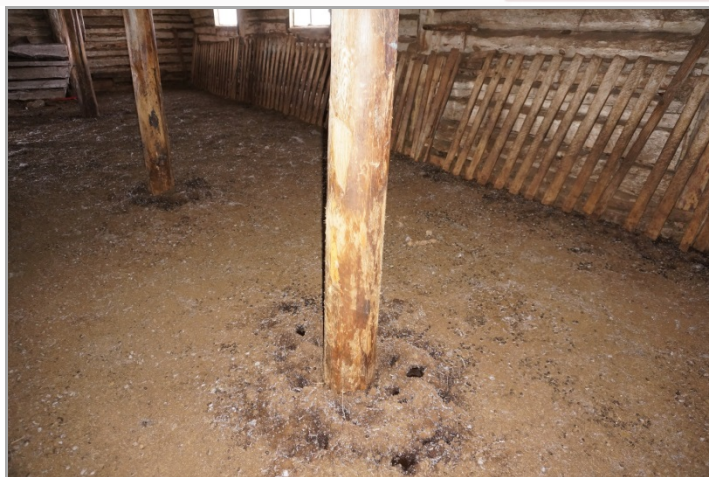
Рис. 11 Выход криогенно-напорных подземных вод на поверхность (а). Пучение грунтов вокруг опорных столбов (б). Республика Алтай
