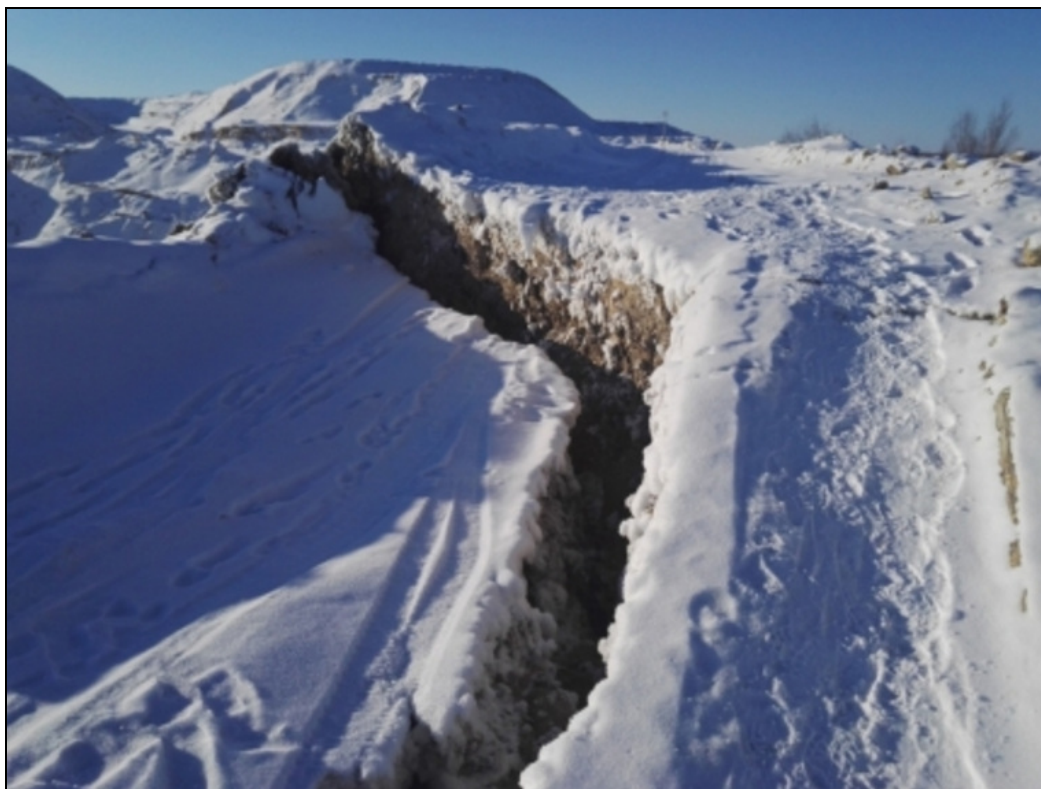
Рис. 9 Оползень на борту карьера Березняковского месторождения. (пресс-служба ГУ МЧС по Челябинской области)
