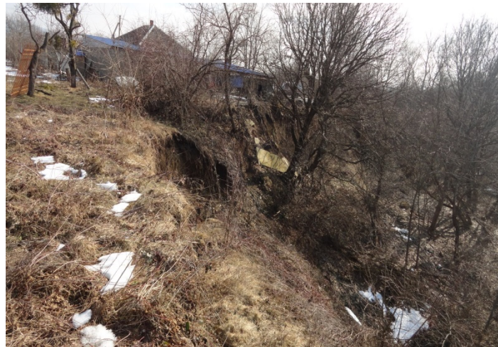
Рис. 2 Майкопский район, ст. Абадзехская. Фронтальный, блоково-консистентный оползень (ООО «НИЦ Кубаньгеология»)
