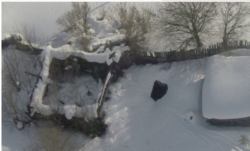
Рис. 6 Пермский край, г. Березники. Провал №5 на БКПРУ-1, выявленный 22.03.2017 (ТЦ ГМСН по Пермскому краю).
