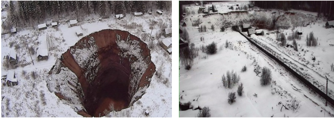
Рис. 8 Провал на СКРУ-2 на момент образования (слева) и по состоянию на 03.04.2017 (справа). Пермский край, г. Соликамск (ТЦ ГМСН по Пермскому краю).
