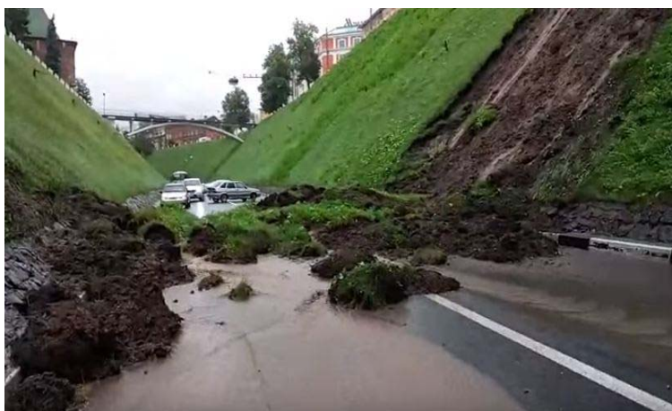
Рис. 58. Участок активизации оползневого процесса на левом борту Зеленского съезда, г. Нижний Новгород (6.07.2017)
