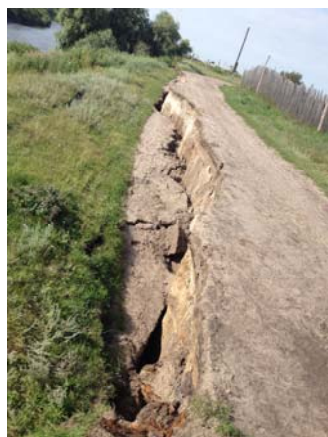
Рис. 60. Суффозионный провал в д. Старая Шадрина
