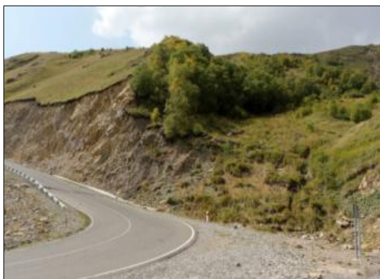
Рис. 40. Оползень на участке автодороги Кисловодск – Долина нарзанов – Джилысу (правая боковая плоскость смещения оползня проходит через два витка серпантина дороги) (22.09.2017)
