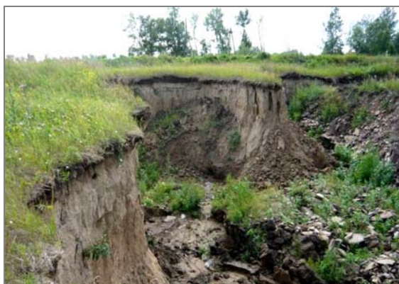
Рис. 88. Новый отвершек правого оврага на участке автодороги Минусинск – Беллык, 98 км, Красноярский край
