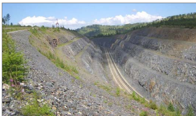
Рис. 86. Железнодорожная выемка на перегоне между станциями Седловая – Бурятская, Забайкальский край
