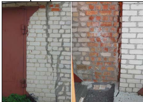
Рис. 3. Деформации в результате активизации оползневой процесса в стене гаража № 32 на ул. Мичуринской, г. Тамбов
