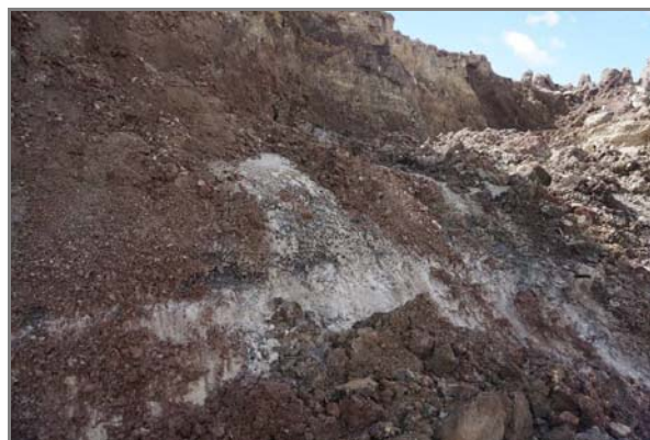
Рис. 77. Линзы льда в стенке отрыва оползня №71, подуч. Чаган-Узун, Республика Алтай
