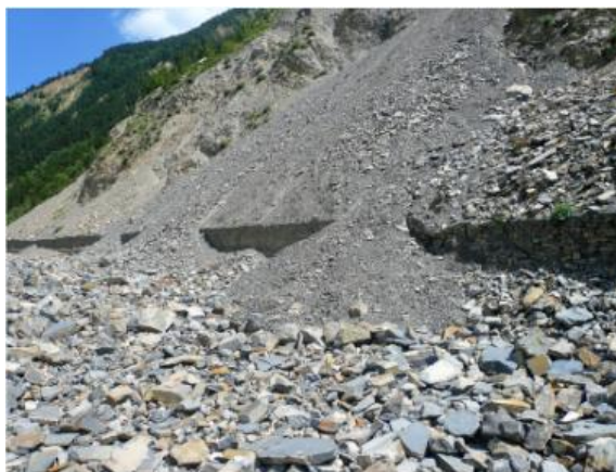
Рис.105. Участок перекрытой обвально-осыпными массами (700 м) технологической дороги газопровода Дзуарикау – Цхинвал
