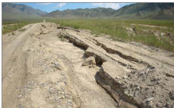
Рис.83. Участок активизации эрозионных процессов на уч. Эйлиг-Хемский, Республика Тыва
