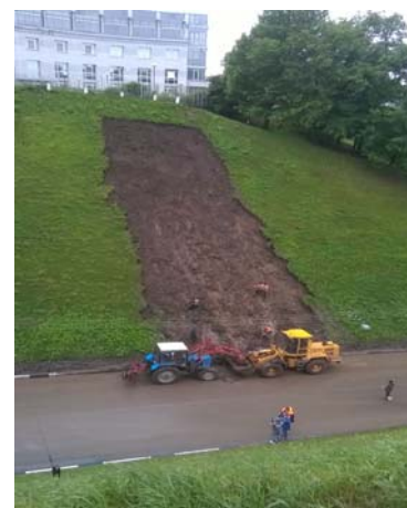
Рис.59. Принятие мер по ликвидации последствий активизации оползня, Зеленский съезд, г. Нижний Новгород
