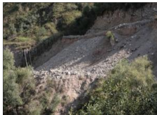
Рис. 41. Обвальными массами в правом борту р. Чегем был частично перекрыт участок (35 м) грунтовой автодороги Лечинкай – Булунгу (11.09.2017)
