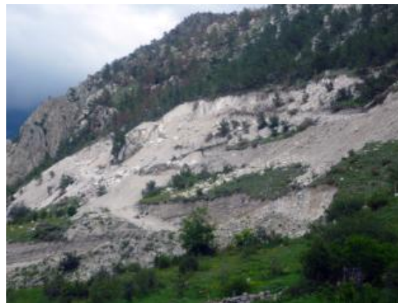
Рис.106. Участок развития обвально-осыпных процессов на восточной окраине с. Н. Унал в результате подрезки склона дорогой
