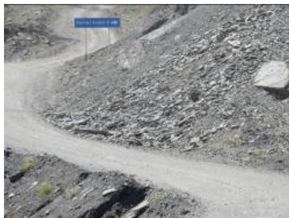
Рис. 103. Обвально-осыпной склон в пределах автодороги Агвали – Кидеро, в 1 км восточнее с. Цумада-Урух
