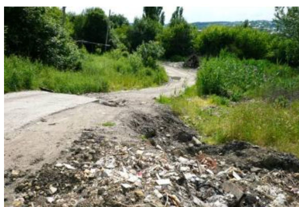
Рис.50. Деформированный в результате активизации оползня участок полотна автодороги (50 м), Ташлянский участок, г. Ставрополь
