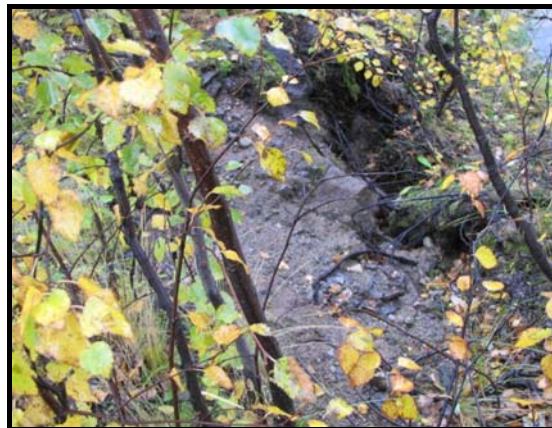
Рис. 6. Свежие трещины на участке оползания рыхлого грунта
