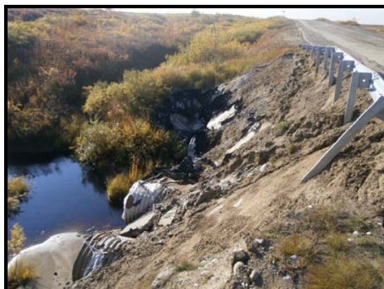
Рис. 21. Обрушение укрепляющих склон конструкций и металлических ограждений
