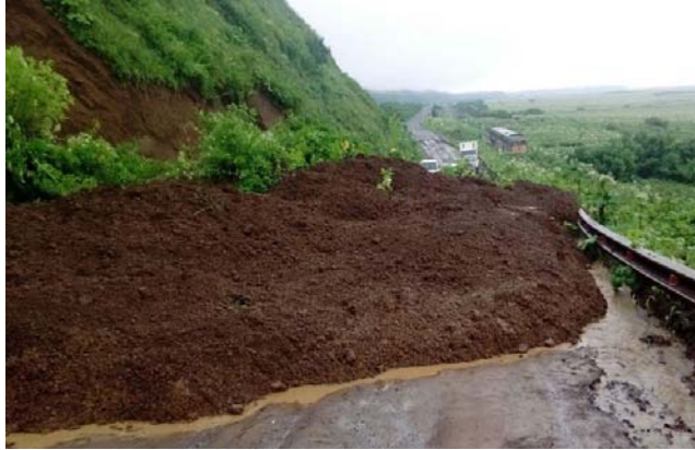
Рис.97. Участок активизации оползневых процессов на автодороге Холмск – Чехов
