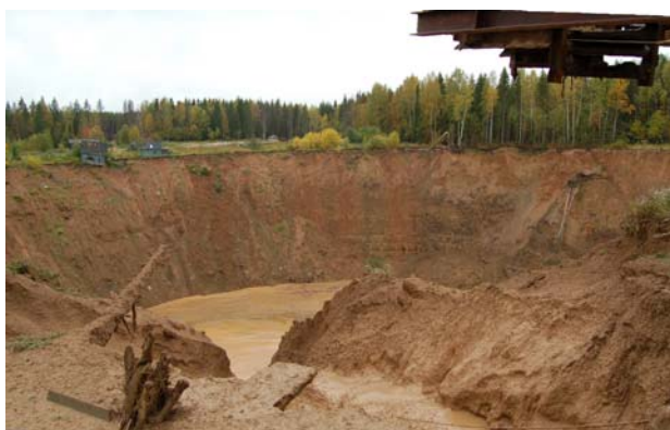
Рис.57. Провал на СКРУ-2, по состоянию на сентябрь 2017 г., г. Соликамск, Пермский край
