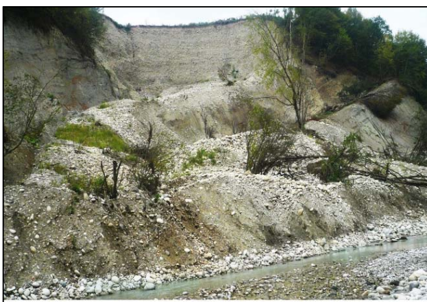
Рис. 23 Оползень на северной окраине с. Ахсарисар. Республика Северная Осетия-Алания
