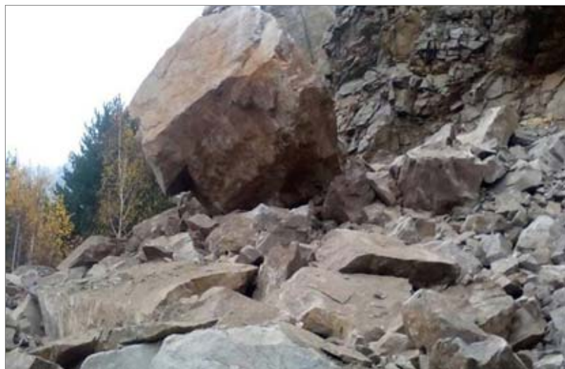
Рис. 5 Проявление обвального процесса на участке а/д Саяногорск–Черемушки (5 км), Республика Хакасия
