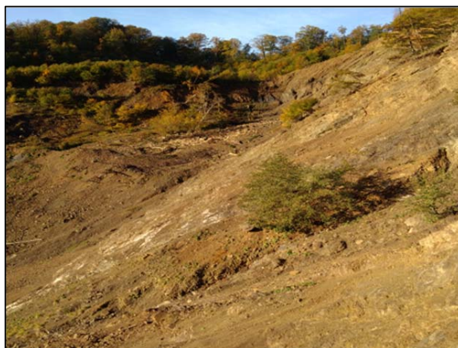
Рис. 13 Кепшинский оползень. Развитие оползневого процесса в среднеюрских аргиллитах. Краснодарский край
