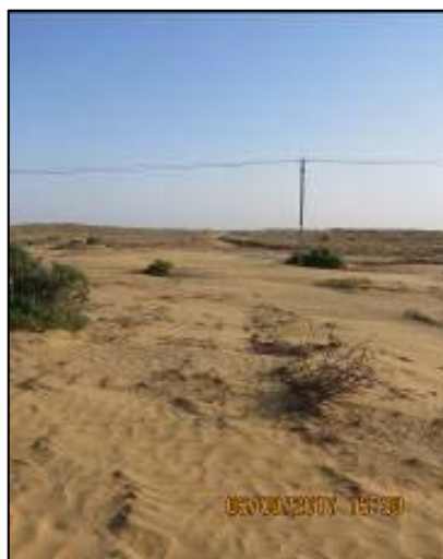
Рис. 18 Занесенная песками полоса отвода подземного газопровода (Прикумский участок наблюдений). Республика Калмыкия.
