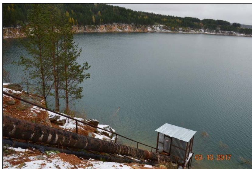
Рис. 34 Общий вид Галкинского карьера и насосная станция. Свердловская область.
