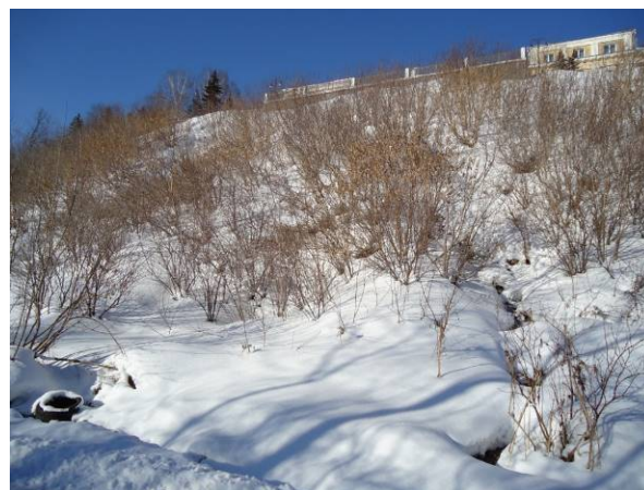
Рис. 15 Промоины в районе мемориала «Вечный огонь». Кировская область.
