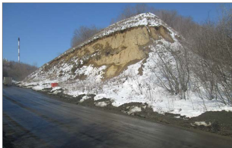
Рис. 20 Участок Лесокирзаводской спуск, эрозийный оползень, г. Барнаул
