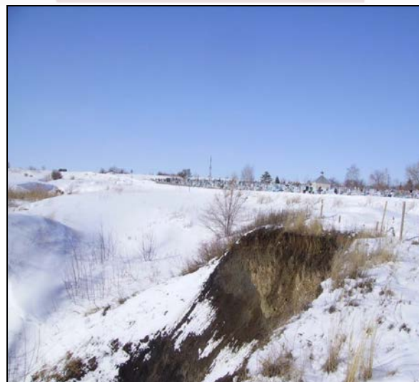
Рис. 2 Бровка оползня, расположенная в 25 м от городского кладбища. Самарская область
