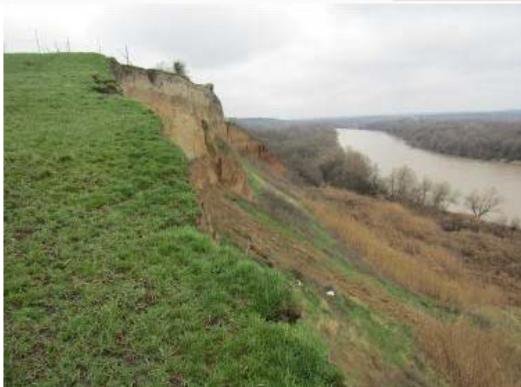
Рис. 8 Обвальнo-оползневой уступ на правом берегу р. Кубань. Краснодарский край.
