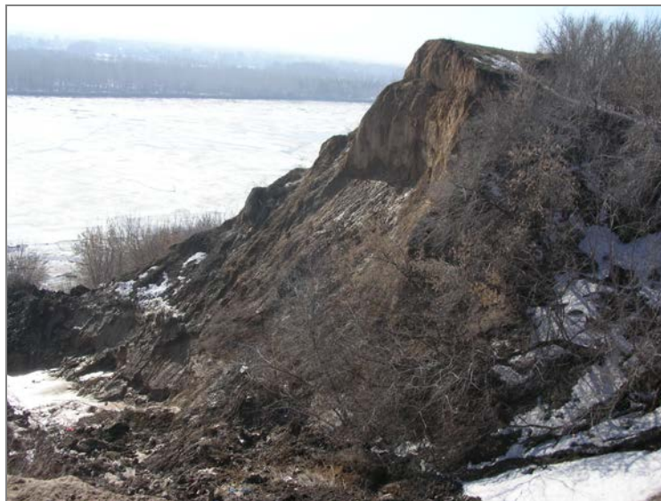
Рис. 19 Участок пер. Присягина – ул. Тачалова, оползень эрозийного генезиса, г. Барнаул
