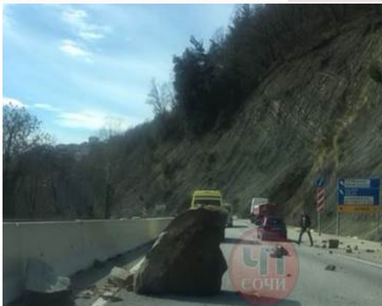
Рис. 5 Фрагменты обвала на проезжей части. Краснодарский край.
