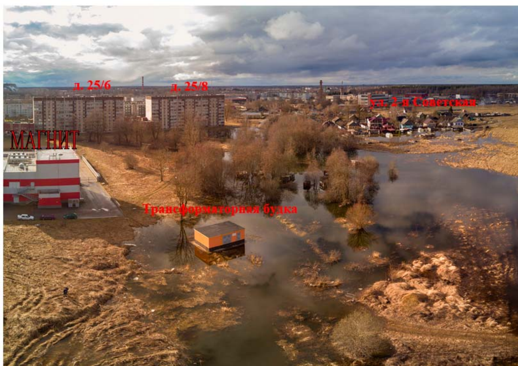
Рис. 2.1 Общий вид на подтопленную территорию перед домами по улицам Ленина, 2-я Советская и у гипермаркета «Магнит»
