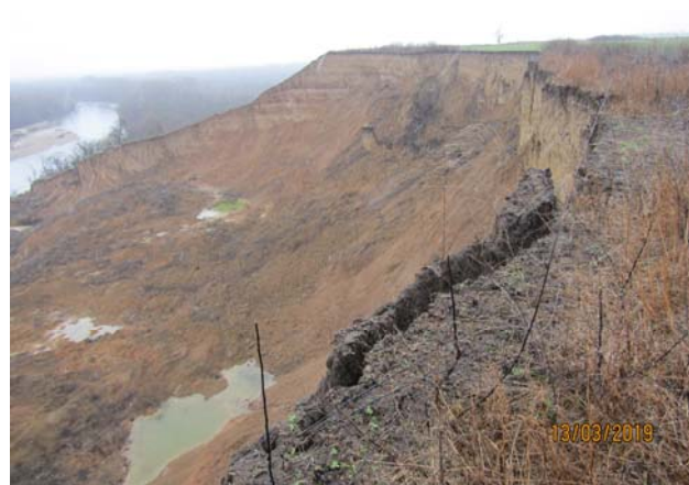
Рис. 2.6 Активный оползневой уступ в ст. Темижбекская
