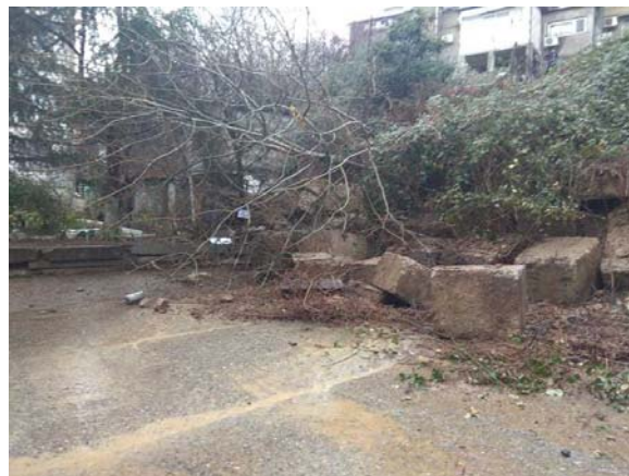
Рис. 2.8 Проявление оползневой оползневой процесса в г. Сочи по пер. Павлова
