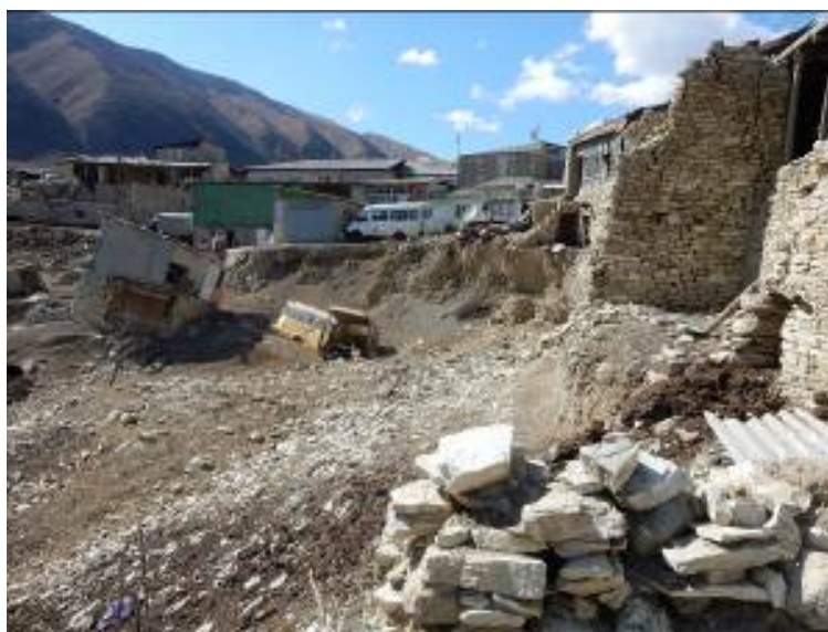
Фото 8. Деформированные оползнем дома, расположенные в юго-западной части с. Бурца Хунзахского района Республики Дагестан
