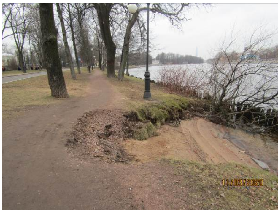
Фото 3. Проявление суффозионного процесса, зафиксированного в Петроградском районе, на левом берегу р. Большая Невка, г. Санкт-Петербург
