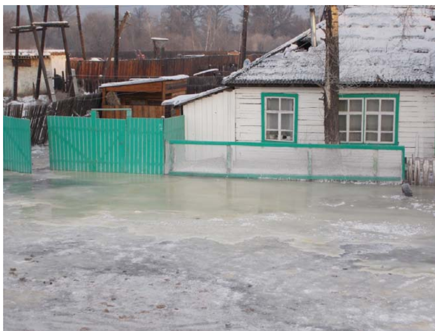
Фото 16. Подтопление жилых домов грунтовыми водами, г. Чадан, Дзун-Хемчикский район. Республика Тыва
